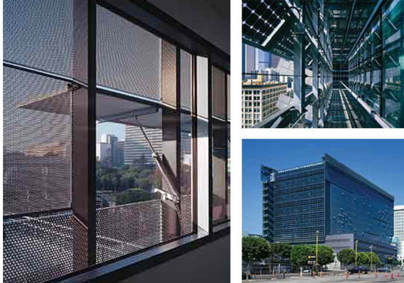
Şekil 2.80 Caltrans District 7 Headquarters Binası (Sullivan 2006)
