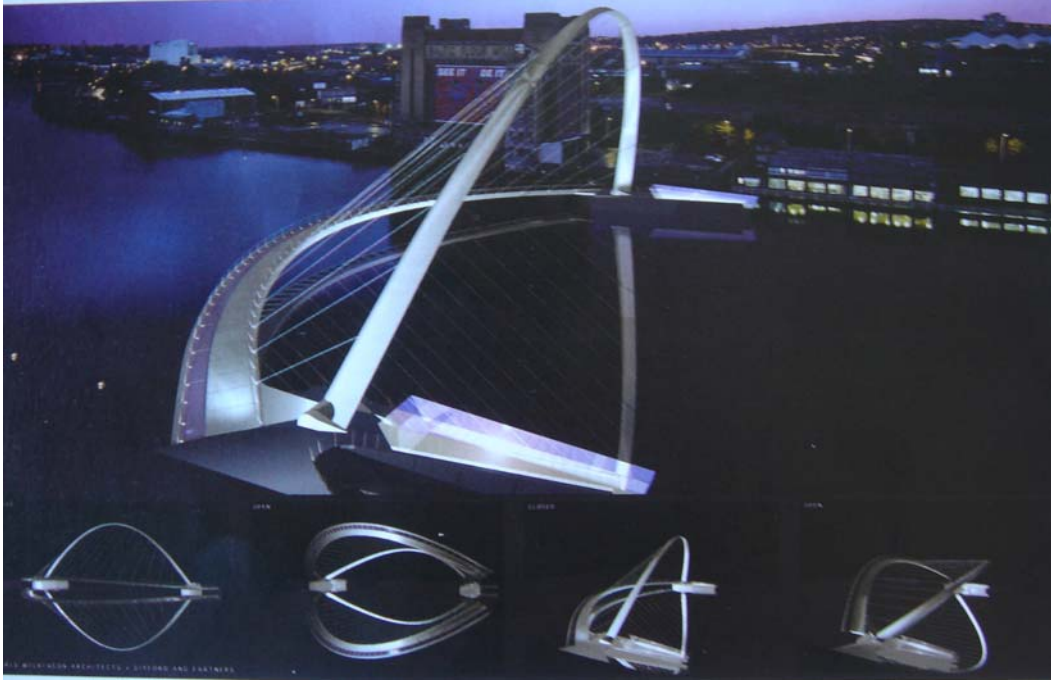
Şekil 3.5 Gateshead Millenium Köprüsü, gözden esinlenen köprünün açılış şemalarının gösterimi (Tasarım,2004/05)
