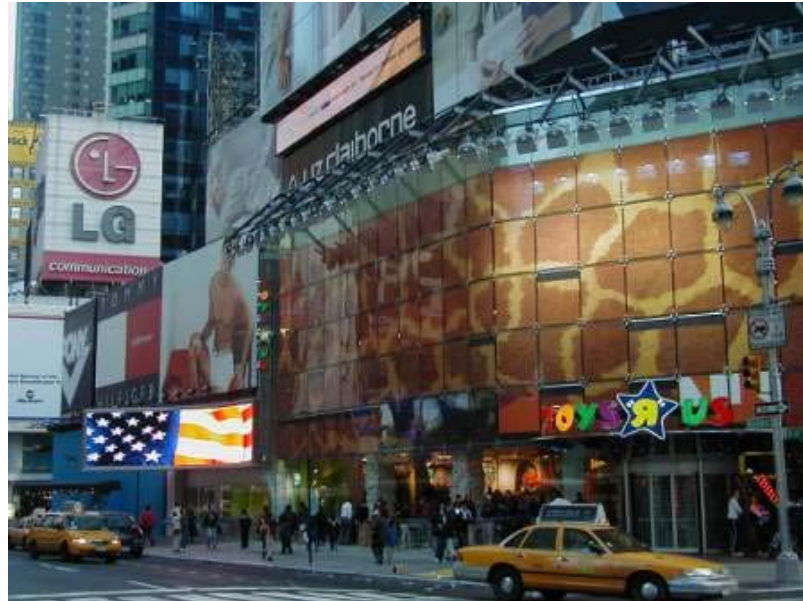
Şekil 3.24 Binanın dış cephe görünümü [21]
