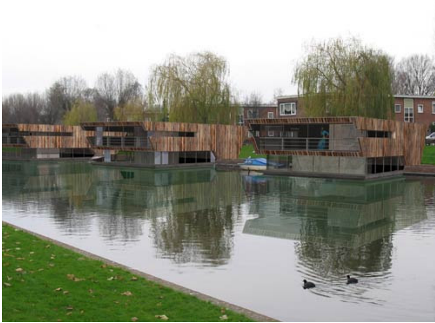
řekil 2.3.14 Hollanda'da bir yüzen mahalle projesi ( www.yapi.com.tr )
