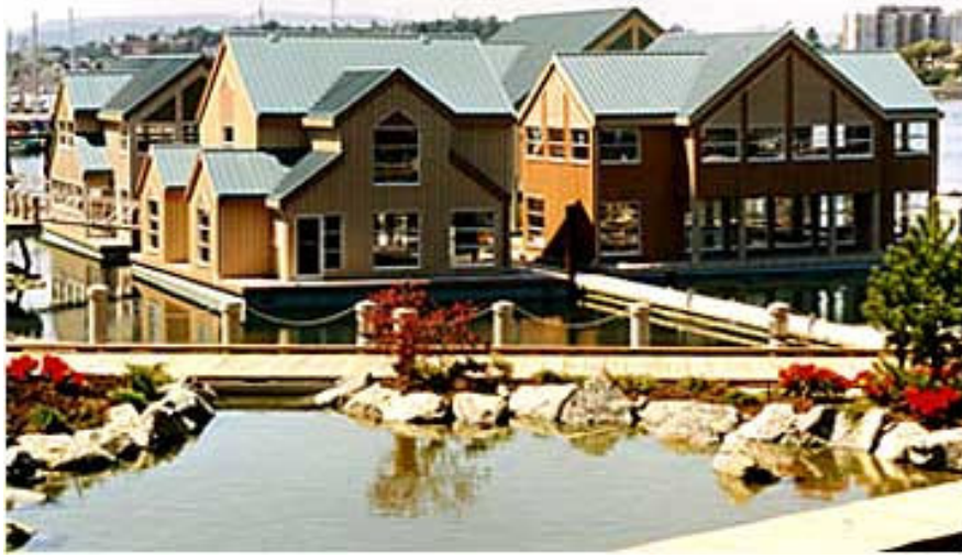
Şekil 2.3.2 Kanada’da dört ve iki katlı ticari binalardan oluşan bir grup. İlk önce Victoria Harbour’daki Coast Otel’e bitişik yerleştirildi, daha sonra Campbell nehrine taşındı. İçerisinde ticari ofisler, restoranlar, tekne kiralama vb.imkanlara sahip. (www.cta.bc.ca)
