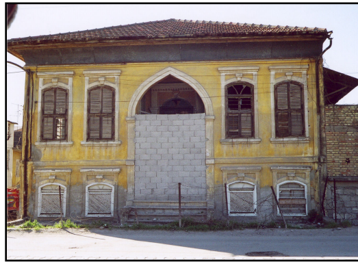
Şekil 3.14 Türkocağı mahallesinden sivil mimari örneği
