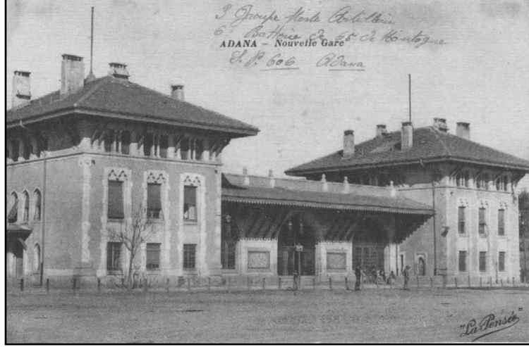
Şekil 3.44 Adana İstasyon Binası ( http://www.adana-bld.gov.tr )
