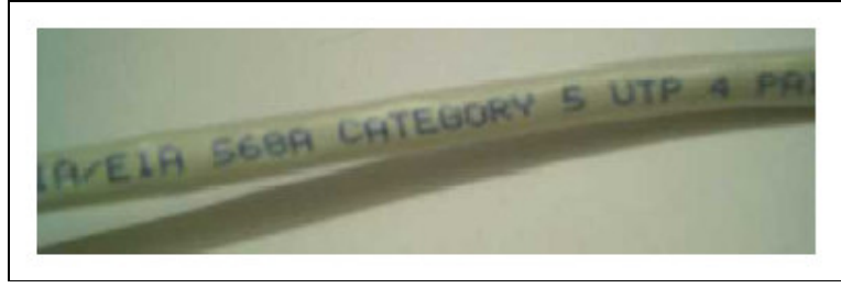
Şekil 4.9 Kablonun üzerindeki yazılar
