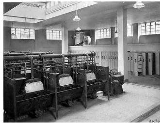
Şekil 3.119 Quarry Hill konutları çamaşırhane tesisi (www.leeds.gov.uk).
