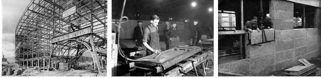
Şekil 3.117 Quarry Hill konutlarının inşaat aşaması (www.leeds.gov.uk).
