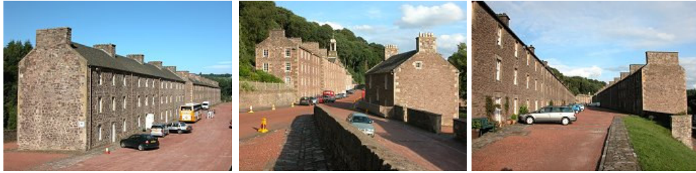
Şekil 2.22 New Lanark yerleşmesi (www.undiscoveredscotland.co.uk).
