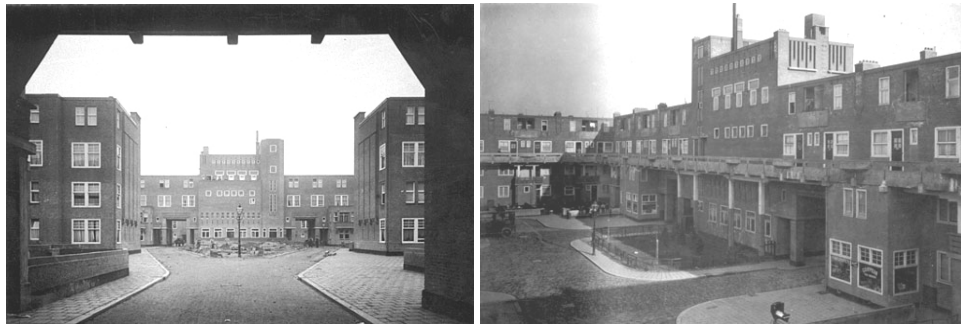
Şekil 3.75 Avluya giriş ve merkezdeki dükkanlardan bir görünüm (www.super8.nl).
