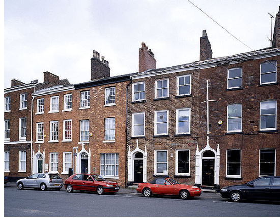
Şekil 2.19 1794 yılında inşa edilmiş Manchester evleri ( www.lookingatbuildings.org.uk ).
