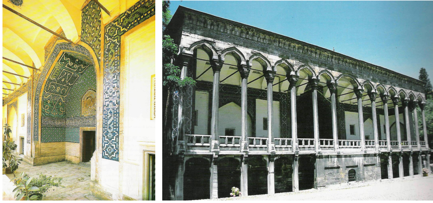
Şekil 3.19 İstanbul Topkapı Sarayı Çinili Köşk ve Çinili Köşk giriş eyvanı (Aslanapa, 2004)
