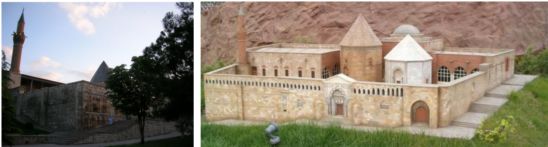
Şekil 3.9 Konya Alaaddin Camii görünüş ve maketi [5]
