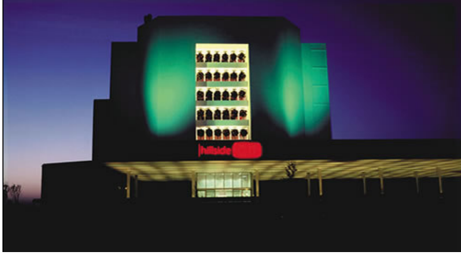
Şekil 5.24 Hillside Su Otelii dış görünüş [33]
