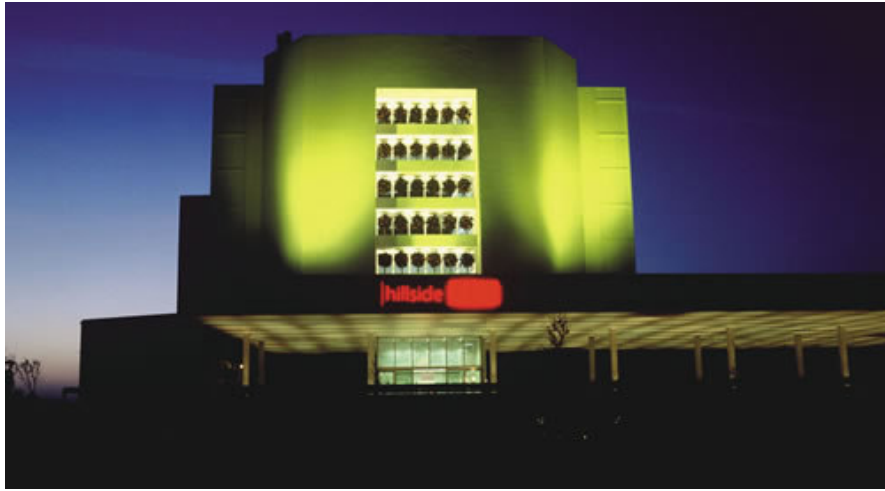
Şekil 5.25 Hillside Su Otelii dış görünüş [33]
