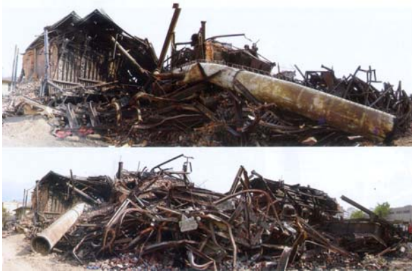
Şekil 6-1 Yıkımdan sonra Ankara Havagazı Fabrikası
