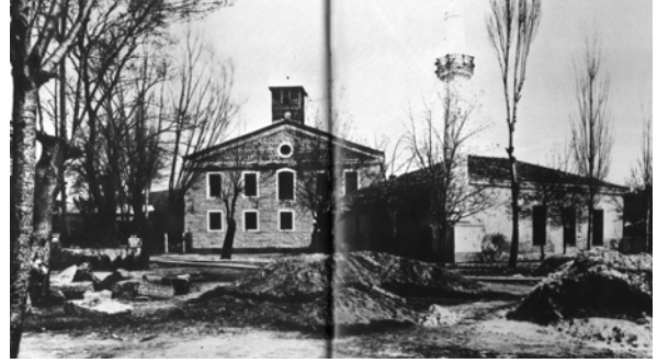
Şekil 5-7 Beykoz Sümerbank Deri ve Kundura Fabrikası; 20. yüzyıl başlarında onarılan cami ve perdahane Küçükerman, 1988, Beykoz Fabrikası, s.162-163
