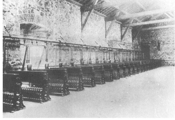
Şekil 4-17 19. yy sonlarında Beykoz Paşabahçe’deki Osmanlı İspermeçet Mumu Fabrikası; mum dökme makineleri Küçükerman, 1988, Beykoz Fabrikası, s.105
