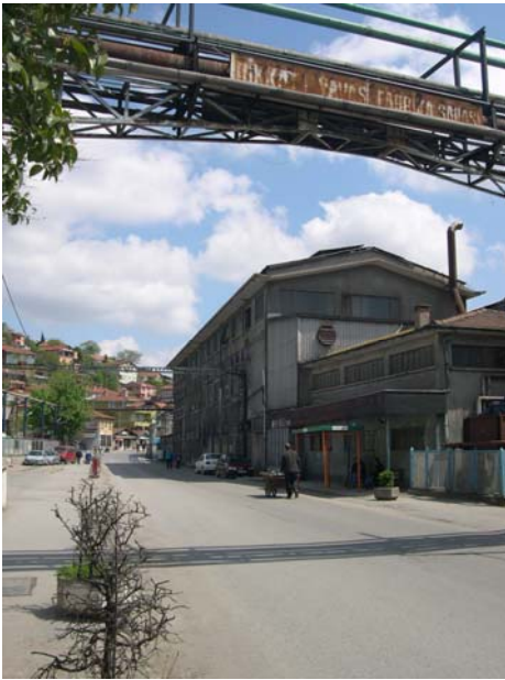
Şekil 4-26 Paşabahçe Şişe Cam Fabrikası, 2005
