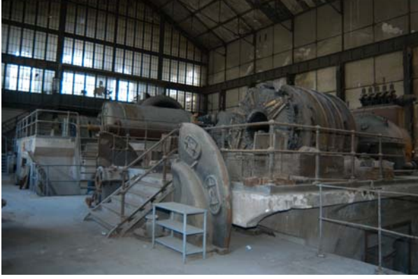
Şekil 2-3 Silaharağa Santrali Arredamento Mimarlık, 2004/07, s.106
