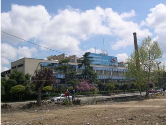
Şekil 4-24 Paşabahçe Şişe Cam Fabrikası, 2005
