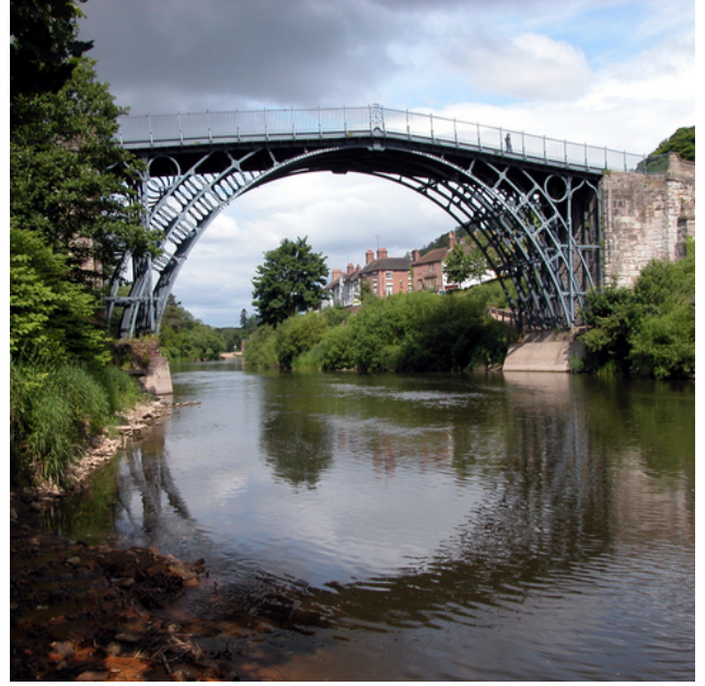
Şekil 2-9 Sanayi devriminin sembolü sayılan tarihteki ilk çelik köprü Ironbridge, İngiltere. Endüstriyel yöntemlerle üretilen bu tür yapılar endüstri arkeolojisi anıtıdır. www.erih.net
