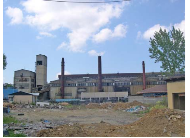
Şekil 4-25 Paşabahçe Şişe Cam Fabrikası, 2005
