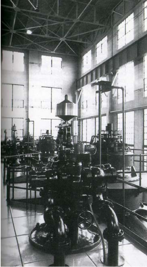
Şekil 2-1 ABD Batı Virginia, Morgantown’da su türbinleriyle çalışan jeneratörler, 1913. (Silahtarađa Santrali ile çağdaş, koruma altında) Arredamento Mimarlık, 1998/04, s.94
