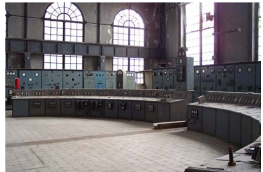
Şekil 3-136 Silahtarağa Elektrik Santrali www.mimarlik.bilgi.edu.tr
