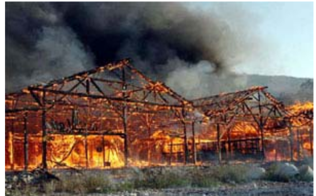
Şekil 6-2 Bursa Sümerbank Merinos Fabrikası Depoları yangını
