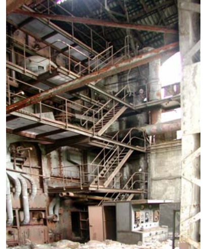
Şekil 3-134 Silahtarağa Elektrik Santrali www.mimarlik.bilgi.edu.tr
