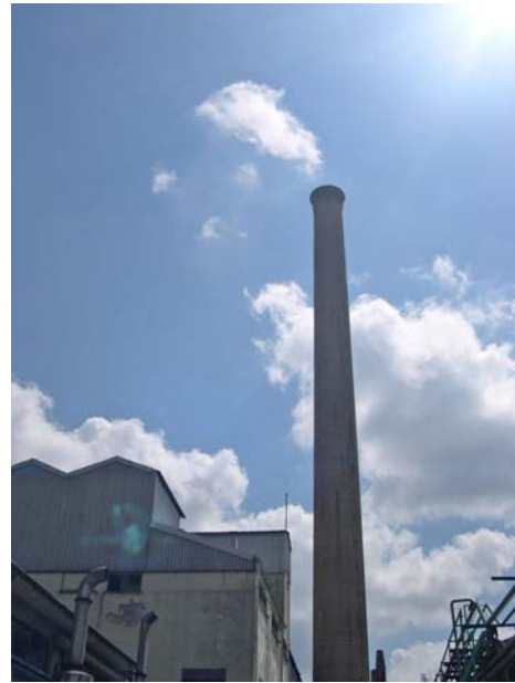
Şekil 4-27 Paşabahçe Şişe Cam Fabrikası, 2005
