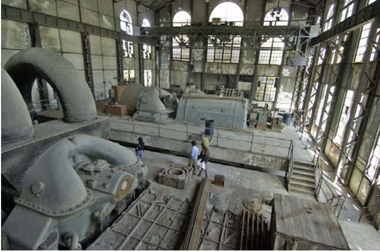
Şekil 3-133 Silahtarağa Elektrik Santrali www.mimarlik.bilgi.edu.tr
