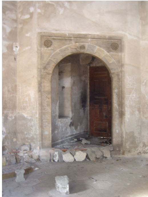
Fot. 5.24 Tevhidhaneye girişi sağlayan kemerli geçiş, 2004.
