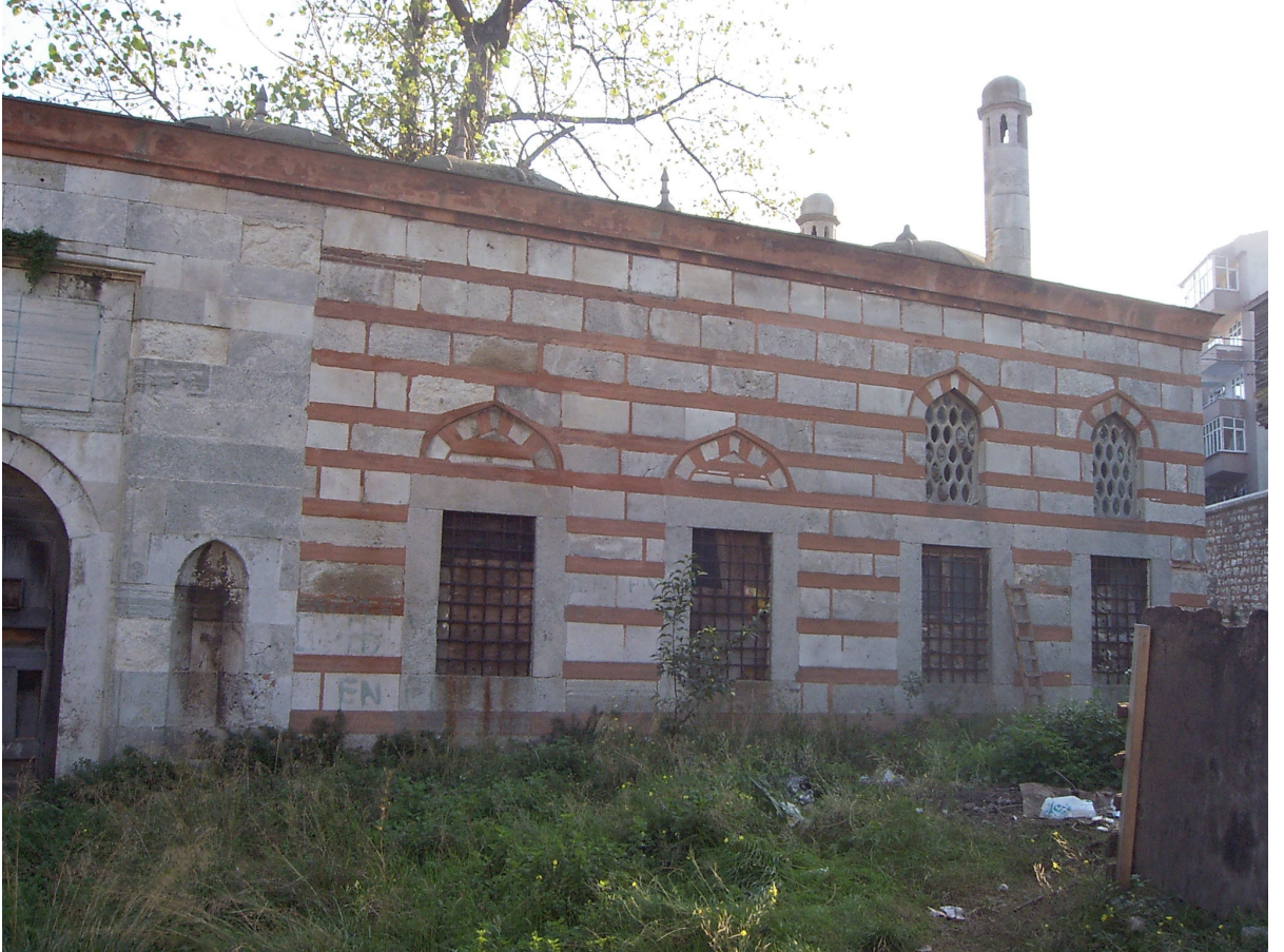
Fot.5.4 Kuzey cephesinde yer alan pencere ve revzenler, 2004.
