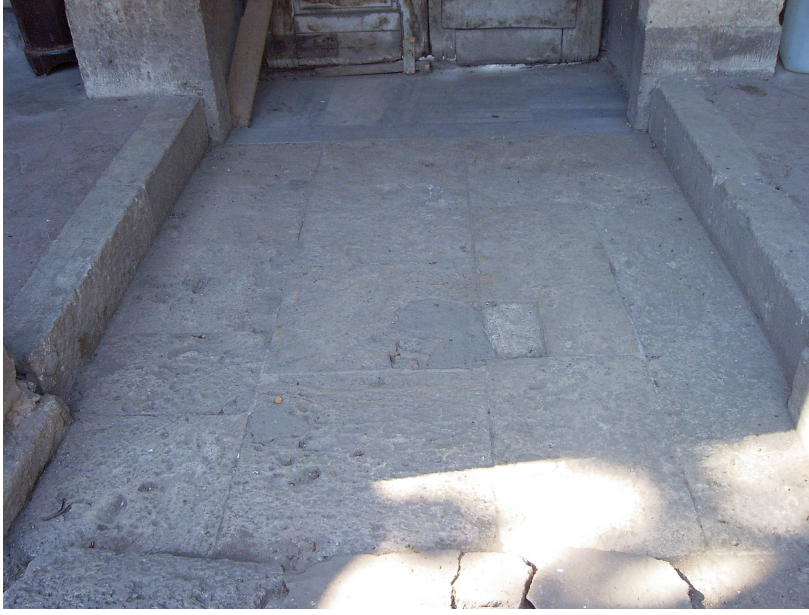
Fot. 5.8 Revaklı avlu giriş kapısı döşemesi, 2004.
