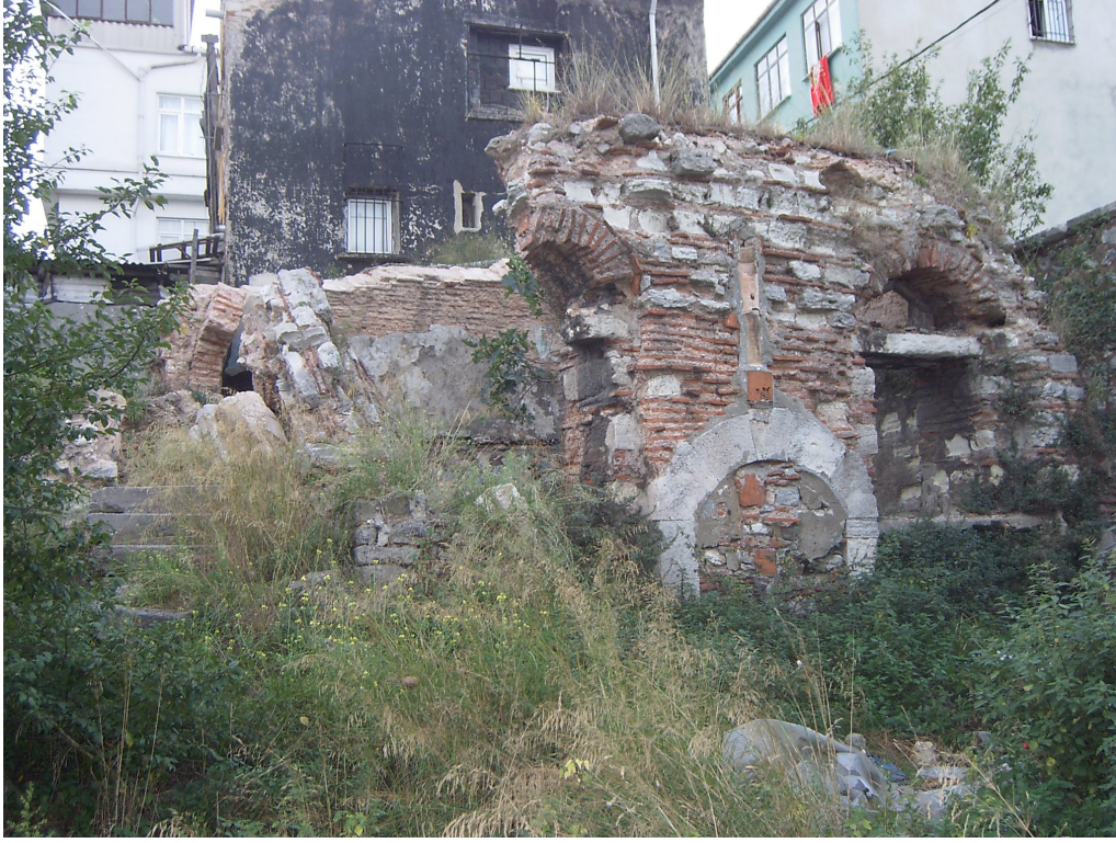
Fot. 5.46 Mutfak kuzey cephesi pencere ve kapısı, 2005.
