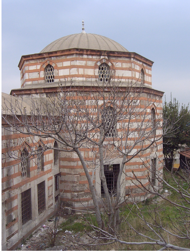
Fot. 5.27 Tevhidhaneye batı cephesinden bakış, 2004.
