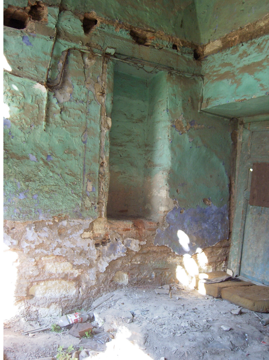
Fot.5.13 Z4 duvarda niş, 2005.
