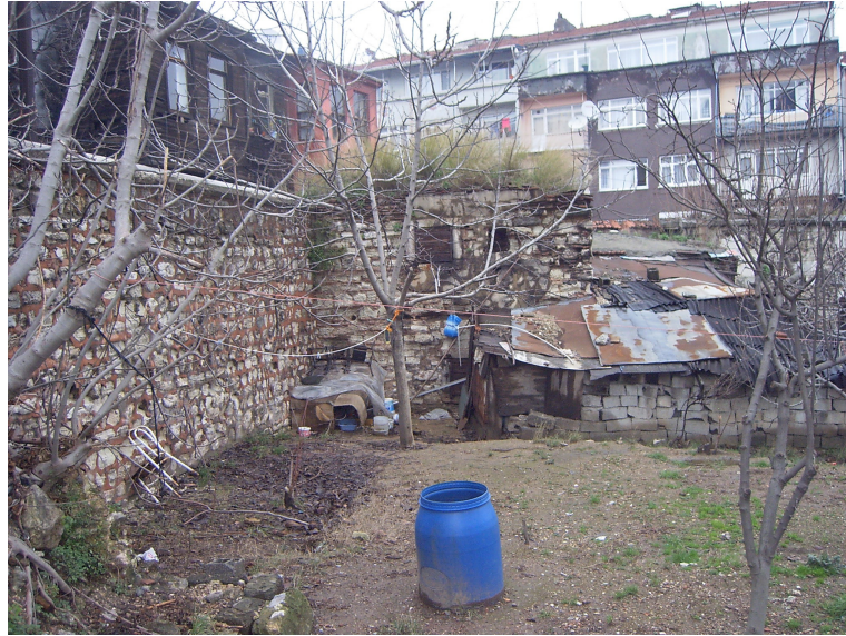
Fot. 5.56 Su haznesi güney cephesi, 2004.
