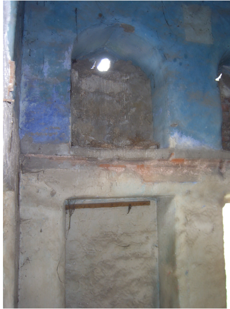
Fot. 5.17 Z9 hücresinin iptal edilen güney pencereleri, 2005.
