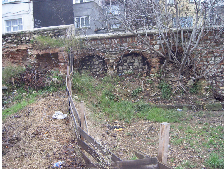
Fot. 5.51 Tuvalet mekanları, 2004.
