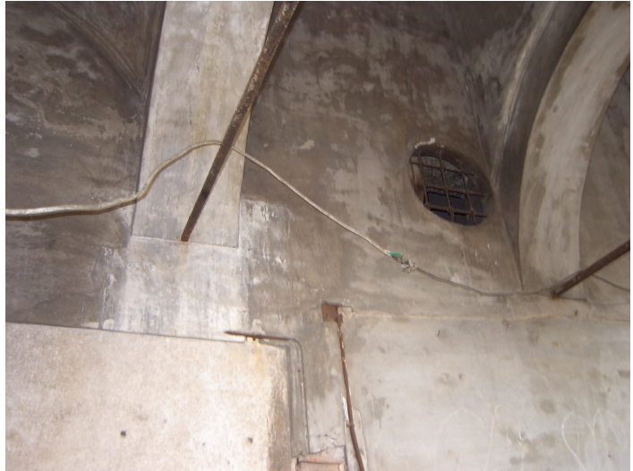
Fot. 5.32 Avlu cephesinden çilehane penceresi, 2004.
