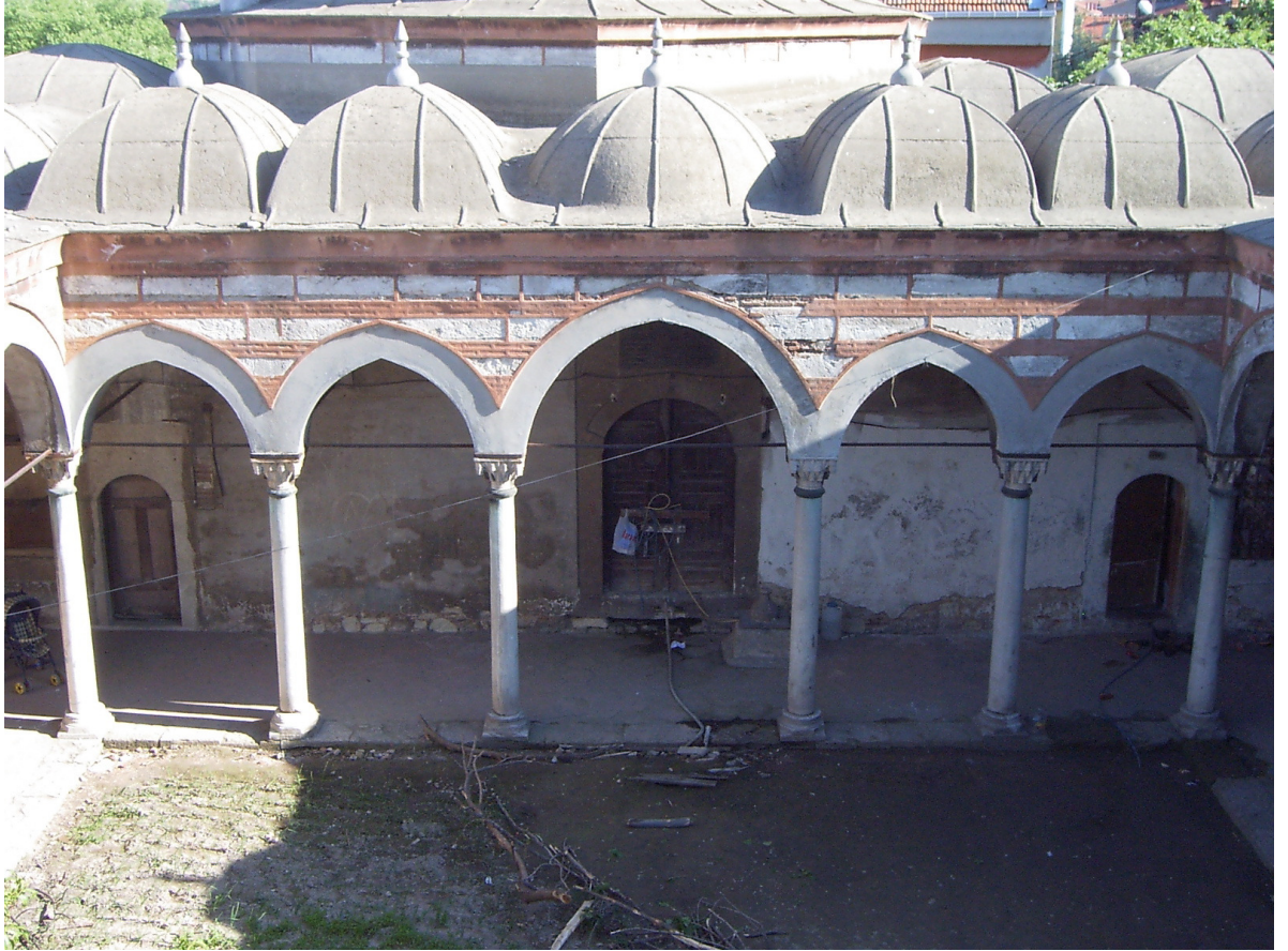
Fot. 5.40 Revaklı avlu güney cephesi, 2005.
