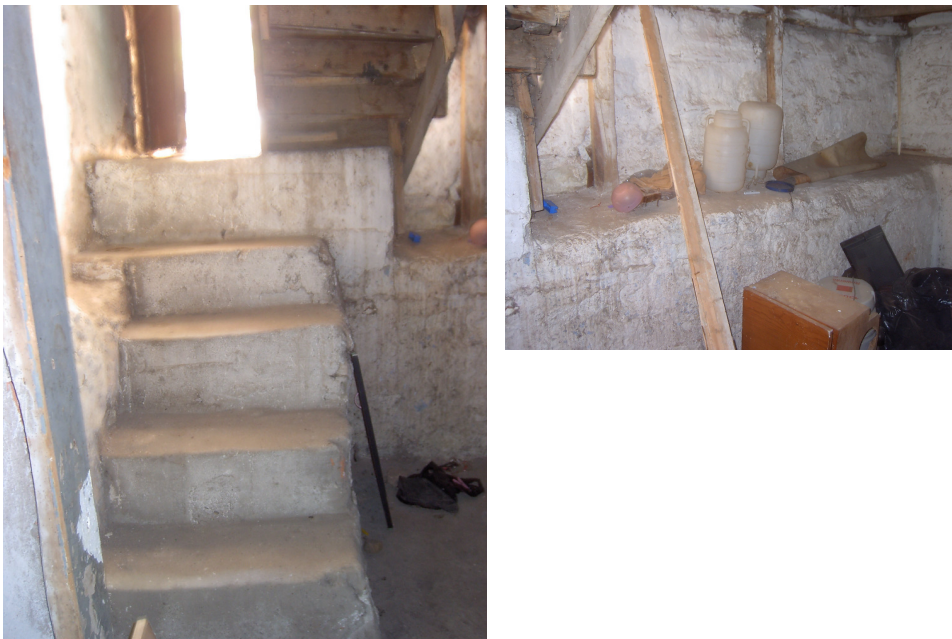
Fot. 5.34 Z12 hücrelerine inen merdivenler ve istinat duvarı, 2004.
