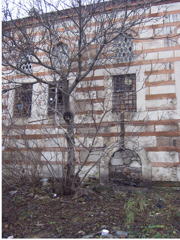
Fot. 5.21 Doğu cephesinde yan giriş kapısı, 2004.
