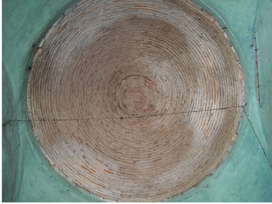
Fot. 5.43 Z4 Derviş hücresinin tuğla kubbesi ve pandantifleri, 2004.
