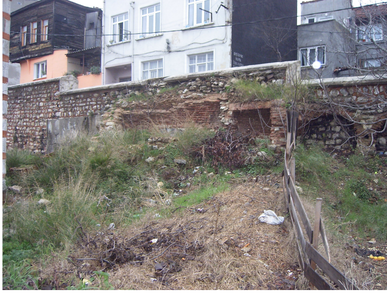
Fot. 5.50 Hamam güney cephesinde yer alan bölüm, 2004.
