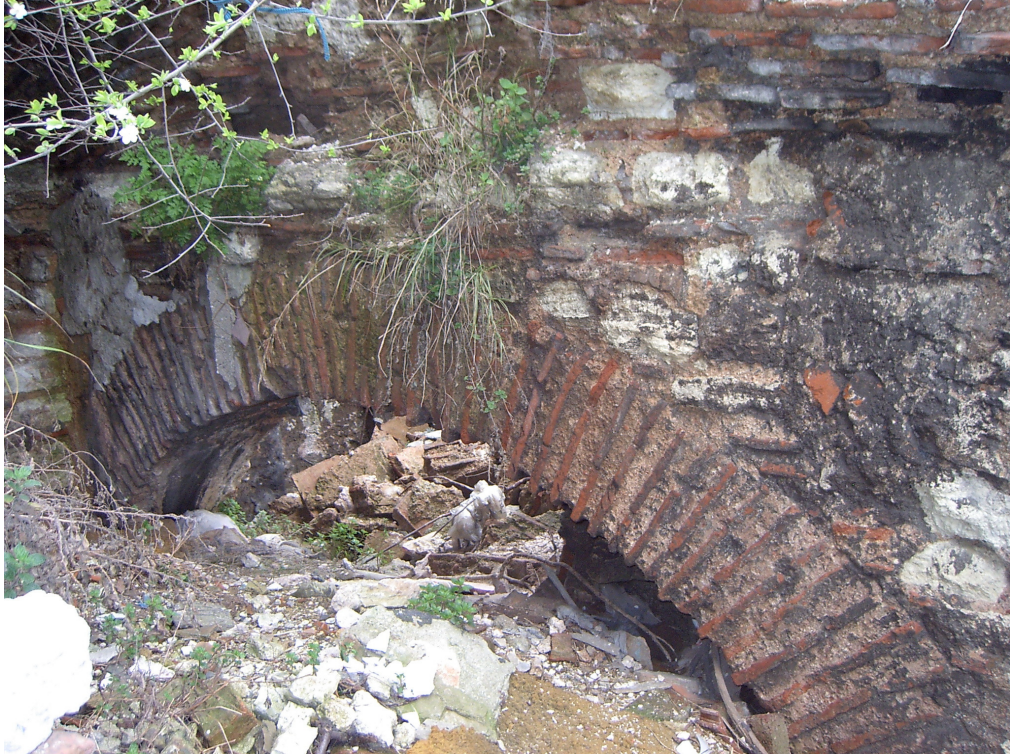
Fot. 5.47 Batı duvarında yer alan basık ve geniş kemer, 2004.
