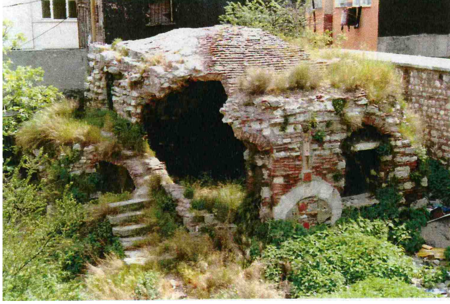
Fot. 5.48 Mutfak üst örtüsü, (Nefçi, 1995).
