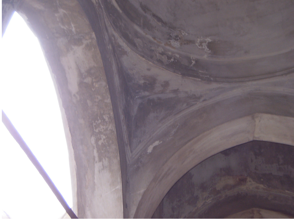
Fot. 5.41 Revaklı avluda tevhidhane önündeki kubbe köşeleri, 2004.
