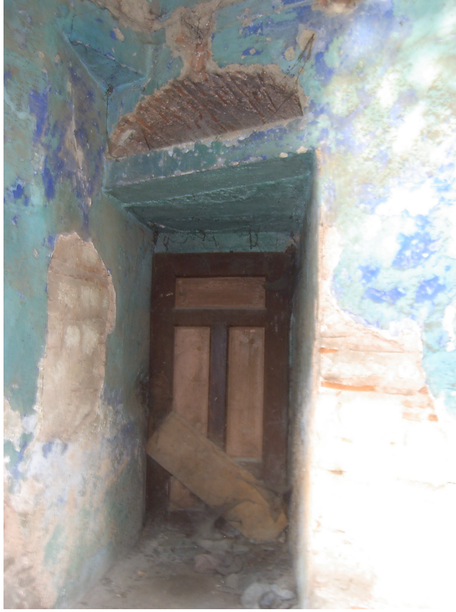
Fot. 5.45 Z5 Derviş Hücresinde kapı önündeki beşik tonoz, 2004.
