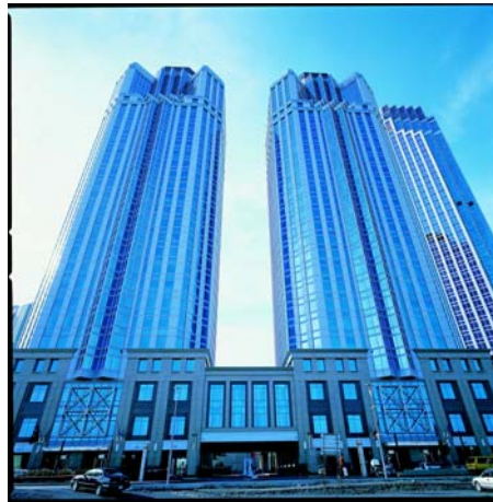
Şekil 5.20 İş Bankası Kuleleri giriş cephesi
