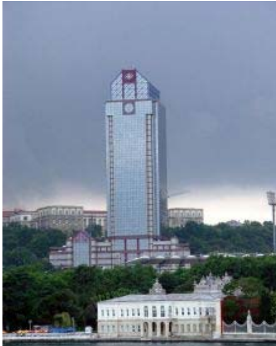
Şekil 5.8 Süzer Plaza'nın boğazdan görünümü
