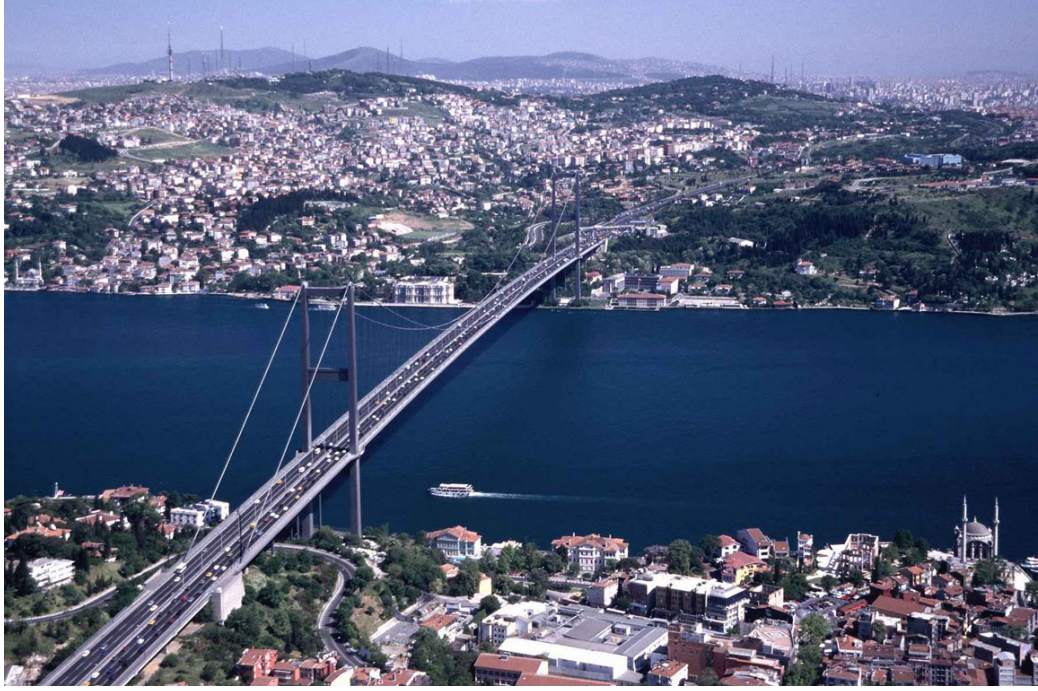
Şekil 4.7 İstanbul-Boğaziçi Köprüsü ve asya yakası
