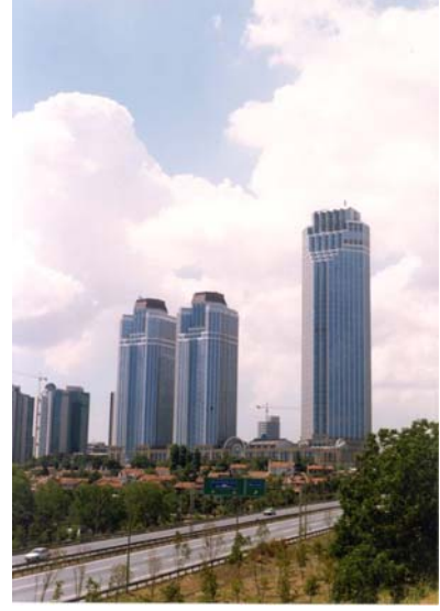
Şekil 5.14 İş Bankası Kuleleri
