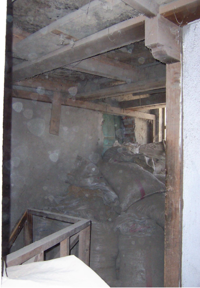
Foto Ek 1.262 Şamlılar Çeltik Fabrikası, 1-03 Üretim2 mekanında M2 merdiveni çıkışı ve 1-05 mekanı duvarı, Nisan 2004
