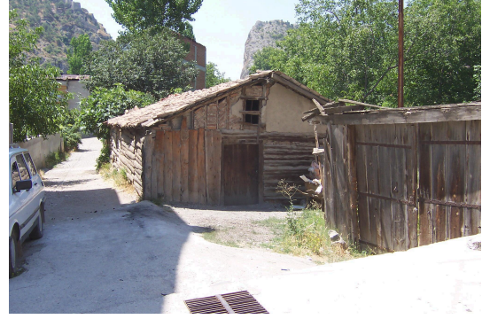
Foto Ek 1.174 Şamlılar Çeltik Fabrikası güneydoğu cephesi önünden geçerek Kolaz çayı kenarındaki bahçelere giden servis yolu ve 15 nolu parsel üzerindeki kümes yapısı, Temmuz 2005
