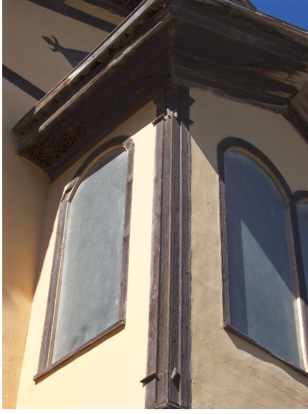
Foto Ek 1.181 Şamlılar Çeltik Fabrikası, güneydoğu cephesi çıkma sol yan görünüşü, Ekim 2003
