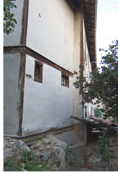
Foto Ek 1.219 Şamlılar Çeltik Fabrikası, güneybatı cephesi, yedinci modülde 1-06 ve 2-03 mekanları duvarı, Ekim 2003
