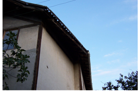
Foto Ek 1.220 Şamlılar Çeltik Fabrikası, güneybatı-kuzeybatı çatı saçağı, Ekim 2003
