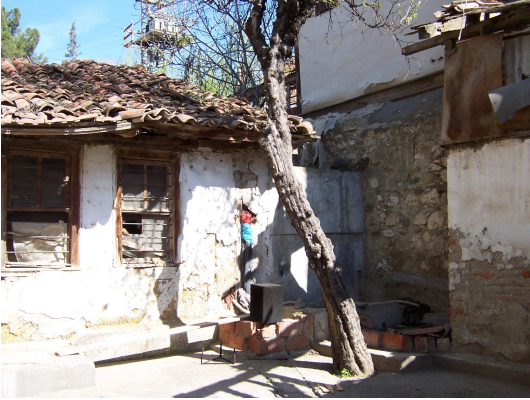
Foto Ek 1.218 Şamlılar Çeltik Fabrikası, güneybatı cephesi taş duvar önünde 12 nolu parsele ait hımış ek yapı ve fabrika ile arasındaki betonarme perde duvar, Nisan 2004
