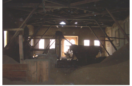
Foto Ek 1.284 Şamlılar Çeltik Fabrikası, 2-01 Üretim 3 mahalli, güneydoğu yönüne bakış, Nisan 2004
