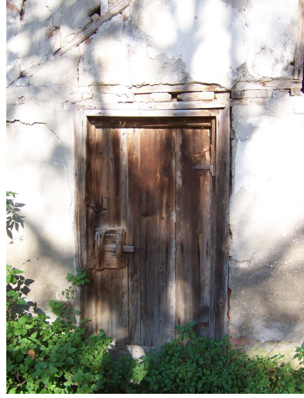
Foto Ek 1.49 Boyabat, Şamlıların Değirmeni, özgün ahır yapısının ahşap giriş kapısı, Eylül 2004
