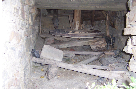
Foto Ek 1.122 Ekinören Köyü, Aşağı Değirmen, domuzluk mahalli ve su çarkı, cepheden görünüm, Temmuz 2005
