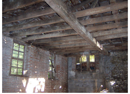
Foto Ek 1.39 Boyabat, Şamlıların Değirmeni, çatı altındaki ahşap kirişlemeler, Eylül 2004
