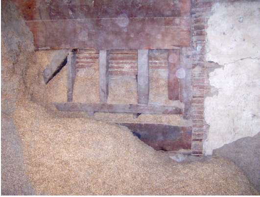
Foto Ek 1.307 Şamlılar Çeltik Fabrikası, 2-04 mekanı, güneydoğu yönünde duvar üzerindeki açmada görülen duvar strüktürü, Nisan 2004
