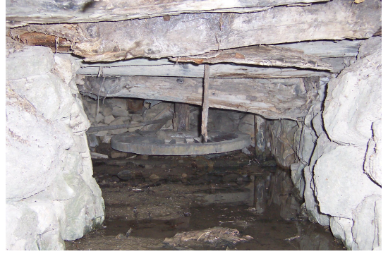
Foto Ek 1.103 Ekinören Köyü, Koca Mehmet'in Değirmeni (Şerafettin Gökçe Değirmeni), domuzluk mahalli ve su çarkı, Temmuz 2005
