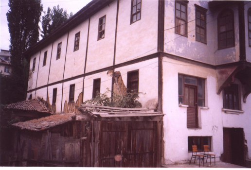
Foto Ek 1.166 Şamlılar Çeltik Fabrikası, güneybatı ve güneydoğu cepheleri, 1980'li yıllar (Hüseyin Yayla)
