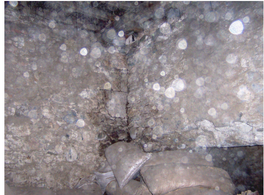
Foto Ek 1.257 Şamlılar Çeltik Fabrikası, Z-09 mekanı kuzeydoğu yönü, Nisan 2004
