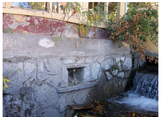
Foto Ek 1.199 Şamlılar Çeltik Fabrikası, kuzeydoğu cephesi, çark yerinde temel seviyesini oluşturan taş duvar, Ekim 2003
