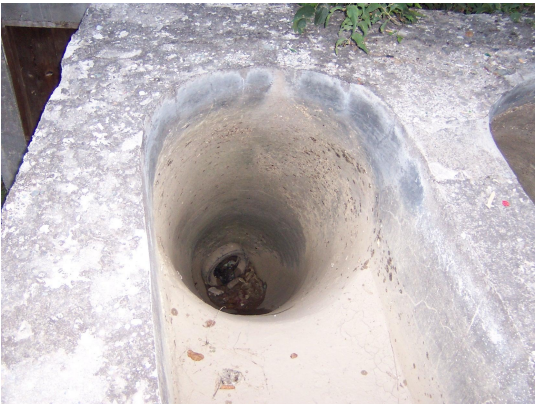
Foto Ek 1.20 Boyabat, Şamlıların Değirmeni, arklardan değirmene inen dikey betonarme oluk, Eylül 2004
