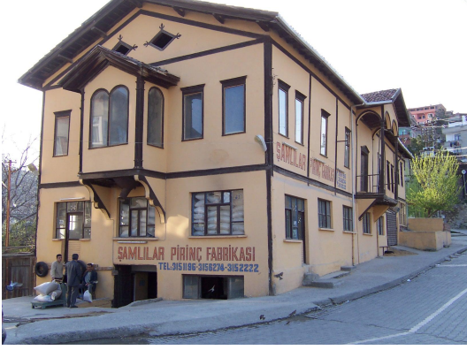
Foto Ek 1.170 Şamlılar Çeltik Fabrikası, güneydoğu ve kuzeydoğu cepheleri, Nisan 2004
