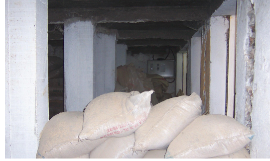
Foto Ek 1.230 Şamlılar Çeltik Fabrikası, Z- 03 depo mahalli, Temmuz 2005
