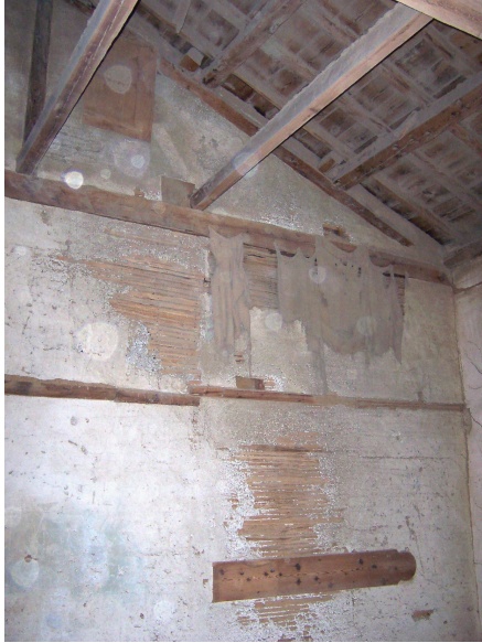
Foto Ek 1.311 Şamlılar Çeltik Fabrikası, 2-01 mahalli, kuzeybatı yönüne bakış, Nisan 2004
