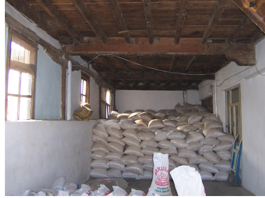
Foto Ek 1.270 Şamlılar Çeltik Fabrikası, 1-02 Paketleme+Depo mekanı, güneydoğu yönünden görünüm, Nisan 2004
