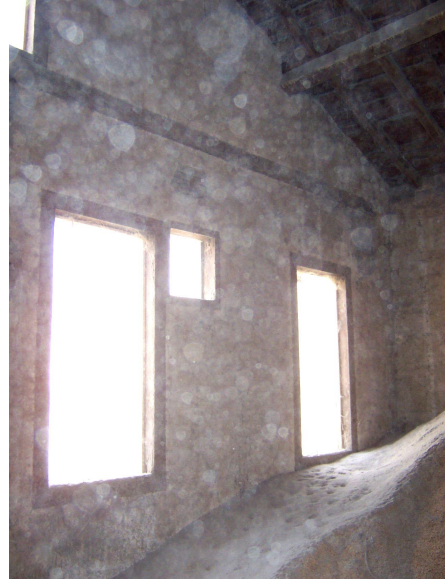
Foto Ek 1.304 Şamlılar Çeltik Fabrikası, 2-04 mekanı, kuzeybatı cephesi, Nisan 2004
