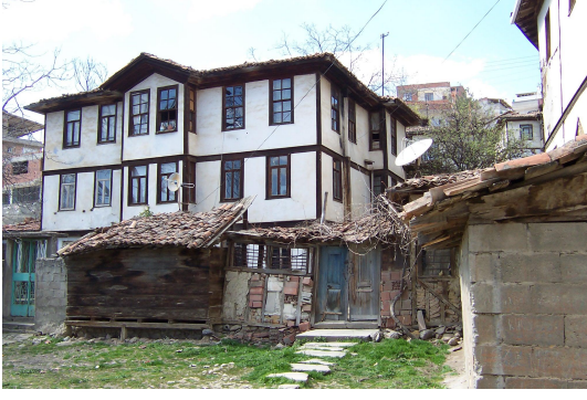
Foto Ek 1.222 Şamlılar Çeltik Fabrikası, güneybatı yönünde 12 nolu parsel üzerindeki konut yapısı ve sonradan eklenmiş iç bahçe duvarı, Nisan 2004
