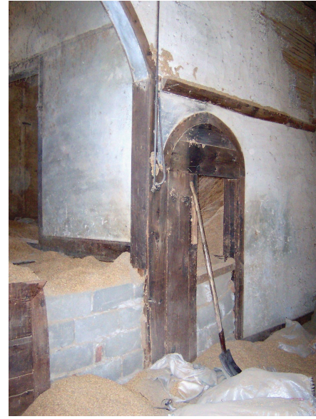
Foto Ek 1.299 Şamlılar Çeltik Fabrikası, 2-01 mahalli, kuzeybatı yönünde 2-03 ve 2-04 mekanlarının döşeme kotuna kadar örülmüş briket duvar, Nisan 2004
