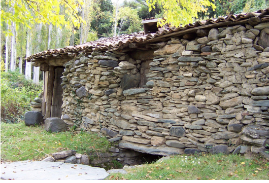
Foto Ek 1.64 Gazidere Tabaklısı Köyü, Ahmet Bican Değirmeni, giriş cephesi, Ekim 2003
