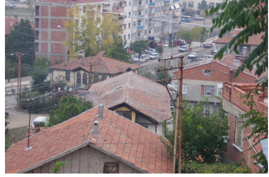
Foto Ek 1.173 Şamlılar Çeltik Fabrikası, çatısı ve yakın çevresi, Ekim 2003
