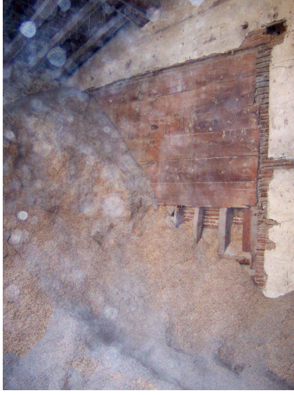
Foto Ek 1.306 Şamlılar Çeltik Fabrikası, 2-04 mekanı, güneydoğu yönündeki duvar üzerinde görülen açma, Nisan 2004
