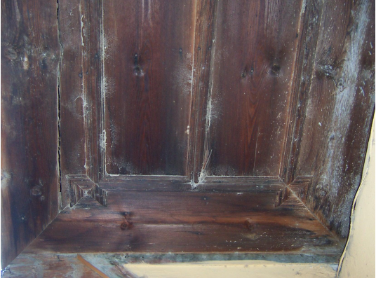
Foto Ek 1.194 Şamlılar Çeltik Fabrikası, kuzeydoğu cephesi, balkon altı tavan kaplaması, Ekim 2003
