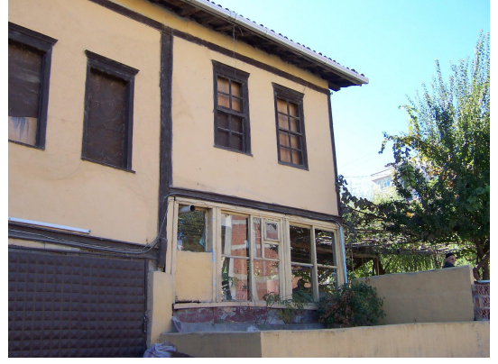
Foto Ek 1.197 Şamlılar Çeltik Fabrikası, kuzeydoğu cephesi, çark yeri ve 1-06 ile 2- 04 mekanları özgün pencereleri, Ekim 2003
