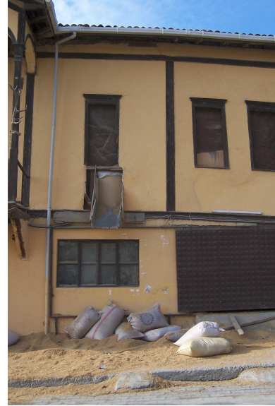
Foto Ek 1.188 Şamlılar Çeltik Fabrikası, kuzeydoğu cephesi, beşinci ve altıncı modüller, Ekim 2003
