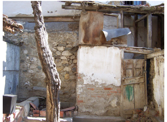
Foto Ek 1.216 Şamlılar Çeltik Fabrikası, güneybatı cephesi taş duvar önünde 12 nolu parselde ait tuğla ek yapı, Nisan 2004
