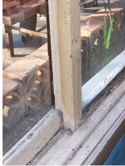
Foto Ek 1.280 Şamlılar Çeltik Fabrikası, 1-06 Kahvehane, kuzeybatı cephesinde özgün yatay sürme pencere, iç detay, Nisan 2004
