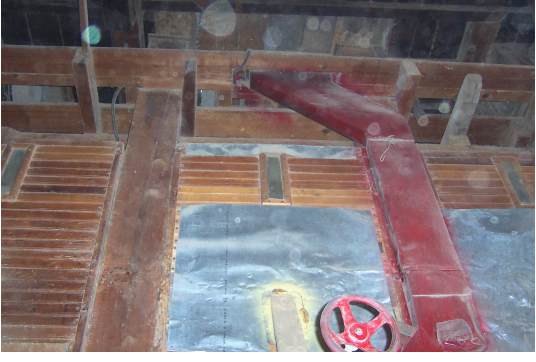
Foto Ek 1.242 Şamlılar Çeltik Fabrikası, Z-04 Üretim 1 mahallindeki parlatma taşını birinci kattaki ambara bağlayan kanallar, Temmuz 2005
