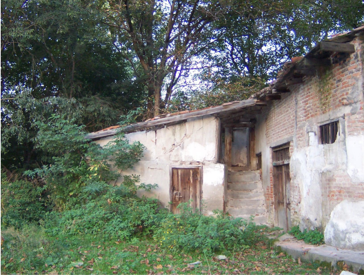
Foto Ek 1.48 Boyabat, Şamlıların Değirmeni, kuzeydoğu köşesindeki ahır yapısı, Eylül 2004
