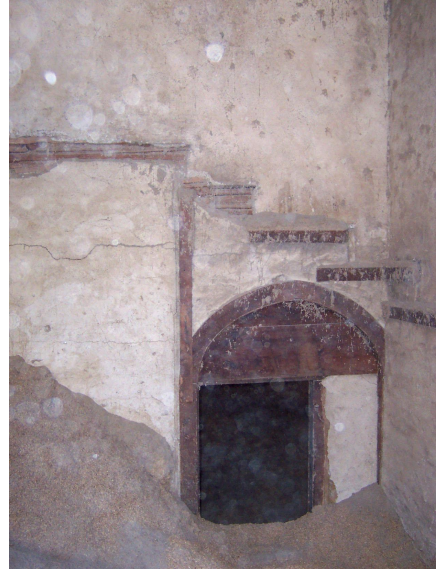
Foto Ek 1.308 Şamlılar Çeltik Fabrikası, 2-04 mekanı, güneybatı ve güneydoğu yönünde duvarlarda görülen merdiven izi, Nisan 2004.
