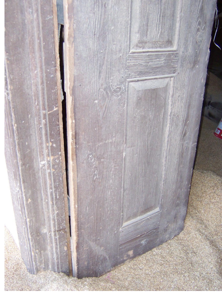
Foto Ek 1.295 Şamlılar Çeltik Fabrikası, 2-01 mahalli, kuzeydoğu cephesinde balkona açılan ahşap kapı dış görünüşü, Nisan 2004
