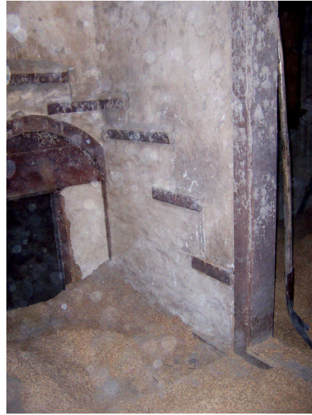
Foto Ek 1.309 Şamlılar Çeltik Fabrikası, 2-04 mekanı, güneybatı ve güneydoğu yönünde duvarlarda görülen merdiven izi, Nisan 2004
