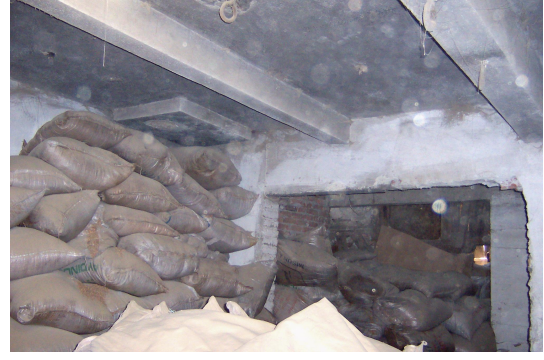
Foto Ek 1.249 Şamlılar Çeltik Fabrikası, Z-05 Atelye mekanı ve betonarme tavanı, Temmuz 2005
