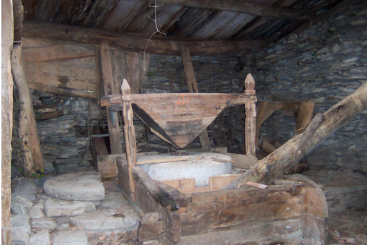
Foto Ek 1.58 Gazidere Tabaklısı Köyü, Ahmet Eskici Değirmeni, iç görünüm, Ekim 2003
