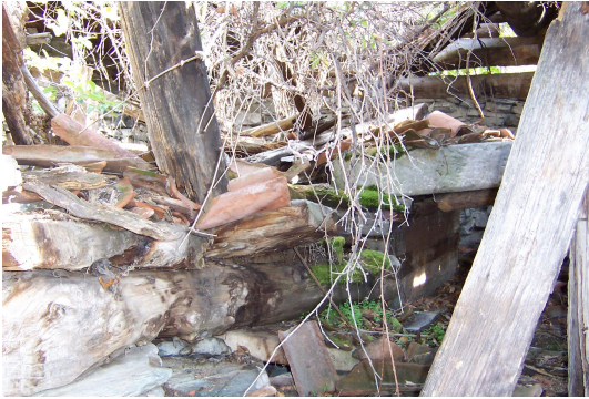
Foto Ek 1.89 Gazidere Fahra Mahallesi, Hüseyin Ulu Değirmeni yıkıntısı, Ekim 2003
