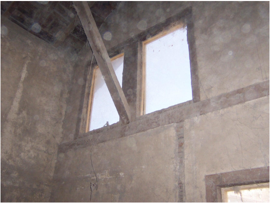
Foto Ek 1.302 Şamlılar Çeltik Fabrikası, 2-04 mekanı, kuzeybatı cephesi üst pencereleri ve çatı destek tahtası, Nisan 2004
