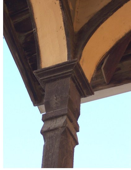
Foto Ek 1.192 Şamlılar Çeltik Fabrikası, kuzeydoğu cephesi, balkon ahşap dikmeleri başlık detayı, Ekim 2003
