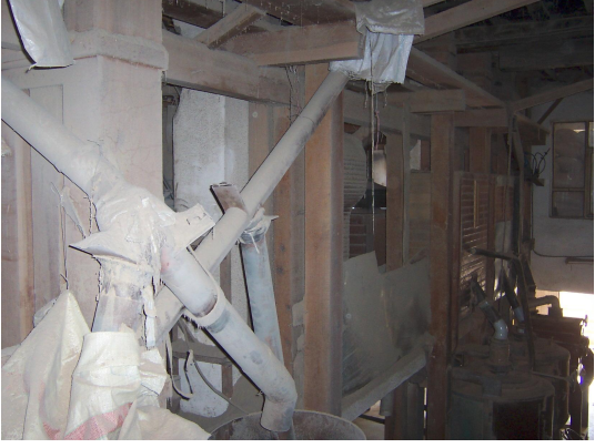
Foto Ek 1.263 Şamlılar Çeltik Fabrikası, 1-04 Atelye mekanı önünden galeri boşluğuna ve 1-03 Üretim 3 mahalline bakış, Nisan 2004
