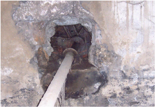
Foto Ek 1.260 Şamlılar Çeltik Fabrikası, Z-10 mekanı içinden milin çarka bağlandığı kasnağın görünümü, Nisan 2004
