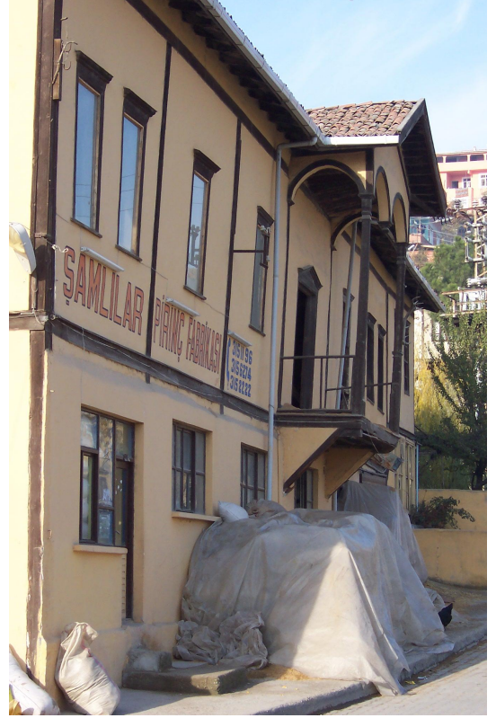
Foto Ek 1.184 Şamlılar Çeltik Fabrikası, Eski Sinop Yolu üzerinden kuzeydoğu cephesi görünümü, Ekim 2003
