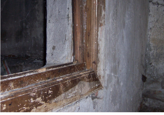
Foto Ek 1.36 Boyabat, Şamlıların Değirmeni, değirmenci odasının özgün giyotin penceresi detayı, Eylül 2004
