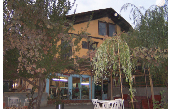
Foto Ek 1.204 Şamlılar Çeltik Fabrikası, kuzeybatı cephesi, 1-06 kahvehane mekanına giriş, Ekim 2003
