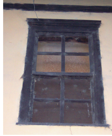
Foto Ek 1.198 Şamlılar Çeltik Fabrikası, kuzeydoğu cephesi, 2-04 mekanına ait özgün giyotin doğrama, Ekim 2003
