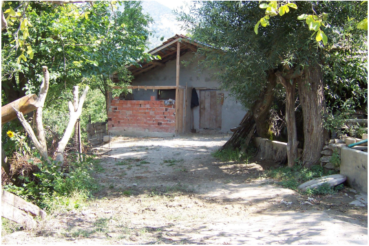
Foto Ek 1.113 Ekinören Köyü, Koca Mehmet'in Değirmeni (Şerafettin Gökçe Değirmeni), değirmene su taşıyan germe oluklar sökülmüş, Temmuz 2005
