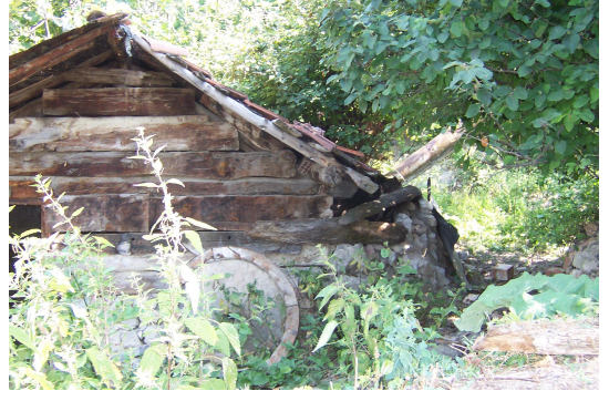
Foto Ek 1.102 Ekinören Köyü, Koca Mehmet'in Değirmeni (Şerafettin Gökçe Değirmeni), güneydoğu cephesi ve germe oluk, Temmuz 2005
