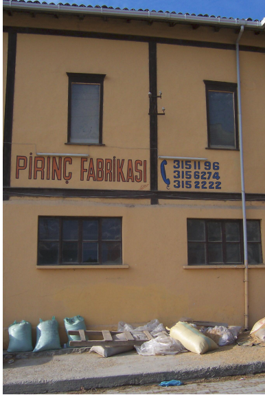
Foto Ek 1.186 Şamlılar Çeltik Fabrikası, kuzeydoğu cephesi, ikinci ve üçüncü modüller, Ekim 2003
