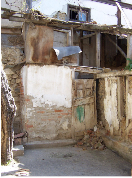
Foto Ek 1.217 Şamlılar Çeltik Fabrikası, güneybatı cephesi taş duvar önünde 12 nolu parsele ait tuğla ek yapı ve fabrikanın penceresini kapatan çatısı, Nisan 2004
