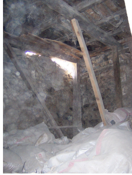
Foto Ek 1.255 Şamlılar Çeltik Fabrikası, Z-09 mekanı güneybatı yönü, Nisan 2004
