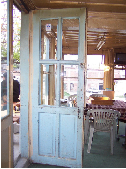
Foto Ek 1.281 Şamlılar Çeltik Fabrikası, 1-06 Kahvehane, kuzeybatı cephesine açılan ahşap giriş kapısı, Nisan 2004
