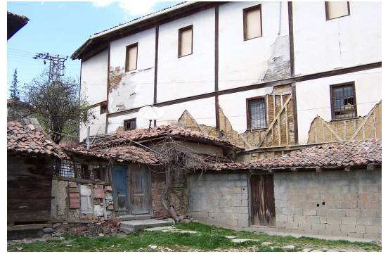
Foto Ek 1.210 Şamlılar Çeltik Fabrikası, güneybatı cephesi ve önündeki 12 nolu parselde ait müşterimatlar, 12 nolu parsel üzerinden görünüm, Ekim 2003
