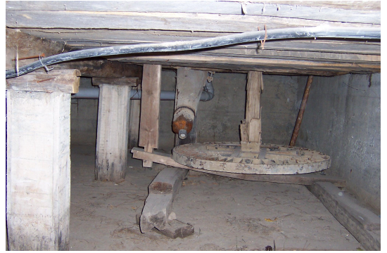
Foto Ek 1.127 Kastamonu Mimar Vedat Tek Anı ve Restorasyon Merkezi, su değirmeni örneğine ait domuzluk mahalli, Ekim 2003
