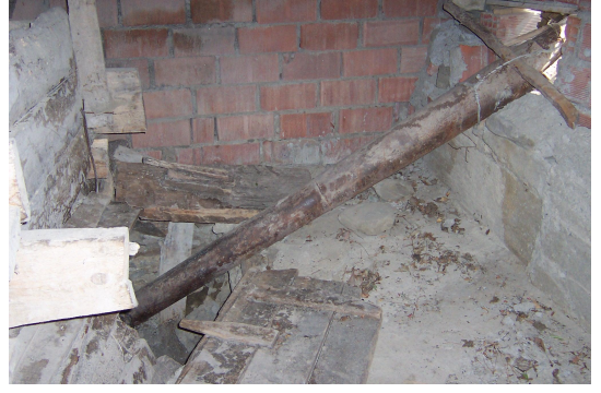
Foto Ek 1.120 Ekinören Köyü, Aşağı Değirmen, domuzluk mahalline su taşıyan demir oluk, Temmuz 2005
