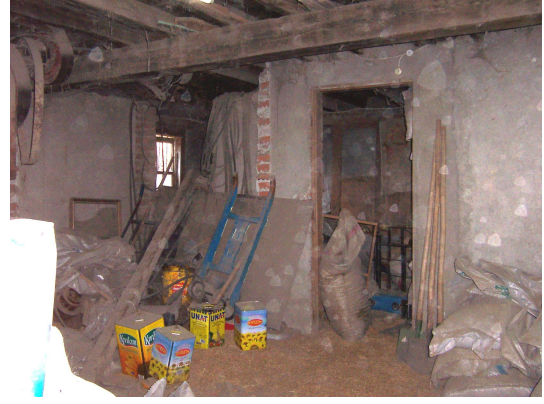
Foto Ek 1.273 Şamlılar Çeltik Fabrikası, 1-04 Atelye mekanı, 1-05 mekanına bakış, Nisan 2004
