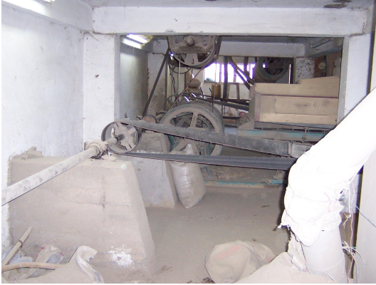
Foto Ek 1.233 Şamlılar Çeltik Fabrikası, Z-04 Üretim 1 mahalli ve makinelere bağlı mil, Nisan 2004
