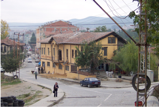
Foto Ek 1.171 Şamlılar Çeltik Fabrikası, Eski Sinop Yolu üzerinden görünüm, Ekim 2003
