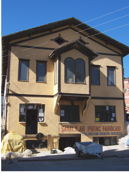
Foto Ek 1.176 Şamlılar Çeltik Fabrikası, güneydoğu cephesi, Ekim 2003
