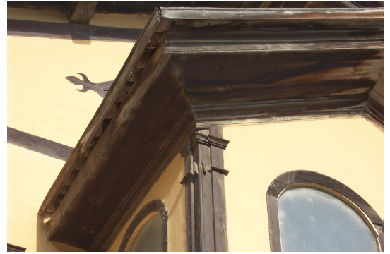
Foto Ek 1.180 Şamlılar Çeltik Fabrikası, güneydoğu cephesi çıkma saçağı detayı, Ekim 2003
