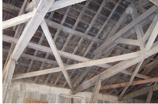
Foto Ek 1.313 Şamlılar Çeltik Fabrikası, 2-01 Üretim 3 mahallinden çatı detayı, Nisan 2004.
