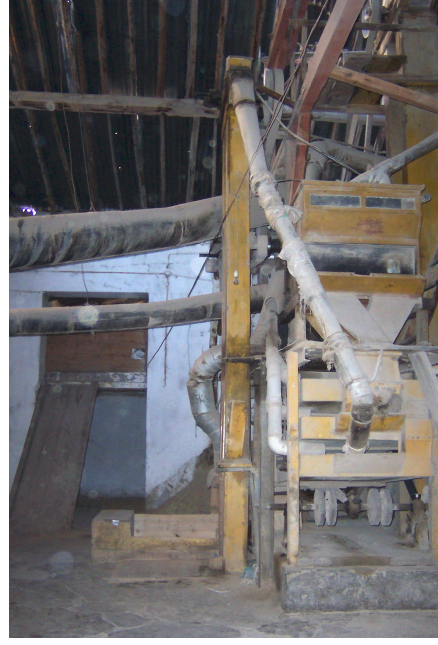
Foto Ek 1.143 Tosya, Bektaş Çeltik Fabrikası, çeltiğin sisteme verildiği "boğaz" kısmı, asansör ve elek makinesi ile arkada ürün girişinin yapıldığı kapı, Kasım 2005
