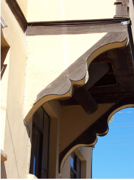
Foto Ek 1.182 Şamlılar Çeltik Fabrikası, güneydoğu cephesi çıkma konsolu görünüşü, Ekim 2003
