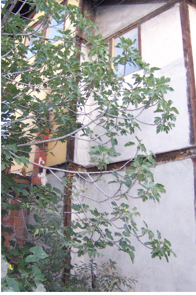
Foto Ek 1.206 Şamlılar Çeltik Fabrikası, kuzeybatı cephesi, 1-06 ve 2-03 mekanları duvarı, Ekim 2003
