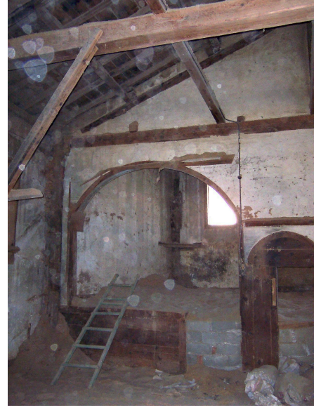
Foto Ek 1.298 Şamlılar Çeltik Fabrikası, 2-01 mahalli, kuzeybatı yönünde 2-03 mekanına açılan kemerli geçiş, Nisan 2004
