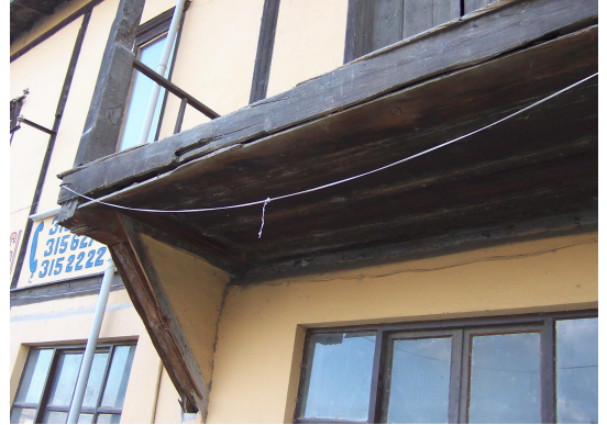
Foto Ek 1.193 Şamlılar Çeltik Fabrikası, kuzeydoğu cephesi, balkon döşeme detayı, Ekim 2003
