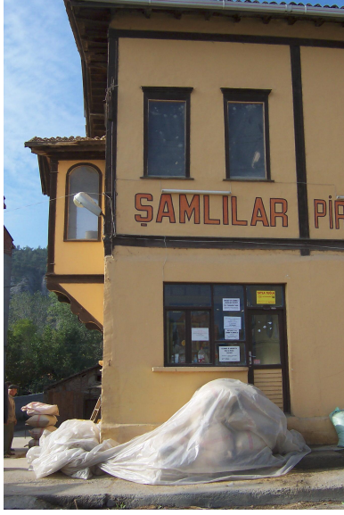
Foto Ek 1.185 Şamlılar Çeltik Fabrikası, kuzeydoğu cephesi, birinci modül, Ekim 2003
