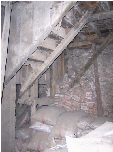
Foto Ek 1.254 Şamlılar Çeltik Fabrikası, Z-09 mekânından 1-06 mekânına çıkan ve üstü kapatılmış merdiven, Nisan 2004
