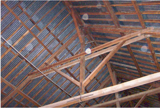
Foto Ek 1.136 Tosya, Bektaş Çeltik Fabrikası, ambar yapısının özgün ahşap çatı strüktürü, Kasım 2005
