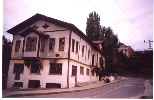
Foto Ek 1.163 Şamlılar Çeltik Fabrikası, güneydoğu ve kuzeydoğu cepheleri, 1980'li yıllar (Hüseyin Yayla)
