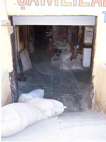
Foto Ek 1.177 Şamlılar Çeltik Fabrikası, güneydoğu cephesi giriş kapısı, beton merdiven ve rampa, Ekim 2003
