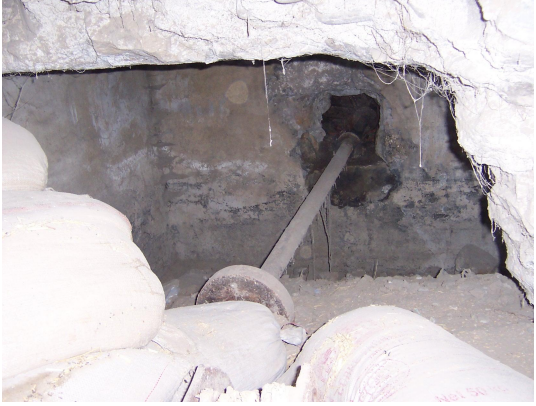
Foto Ek 1.259 Şamlılar Çeltik Fabrikası, Z-09 ile Z-10 mekanları arasındaki taş duvarda açılmış boşluk ve Z-10 içindeki çarka bağlanan metal mil, Nisan 2004
