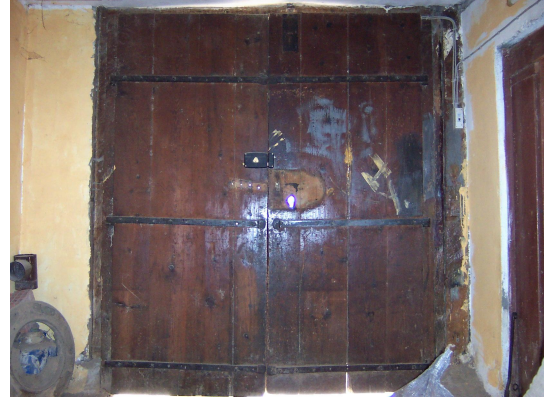
Foto Ek 1.224 Şamlılar Çeltik Fabrikası, güneydoğu cephesine açılan çift kanatlı ahşap kapı, Z-01 giriş holünden görünüm, Ekim 2003
