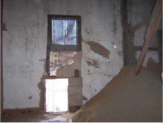
Foto Ek 1.293 Şamlılar Çeltik Fabrikası, 2-01 mahalli, kuzeydoğu cephesinde beşinci modüldeki değiştirilmiş pencere iç görünüşü, Nisan 2004
