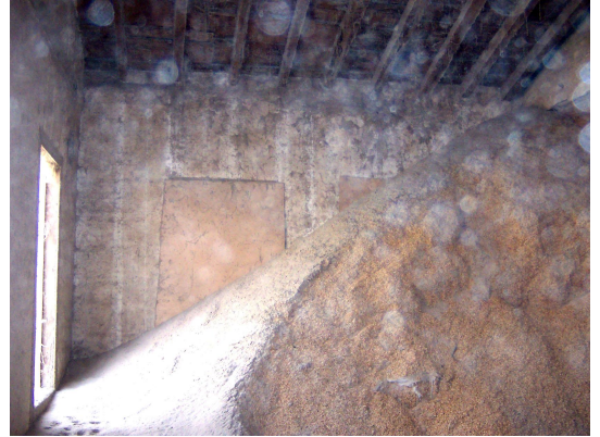
Foto Ek 1.305 Şamlılar Çeltik Fabrikası, 2-04 mekanı, kuzeydoğu cephesi, Nisan 2004
