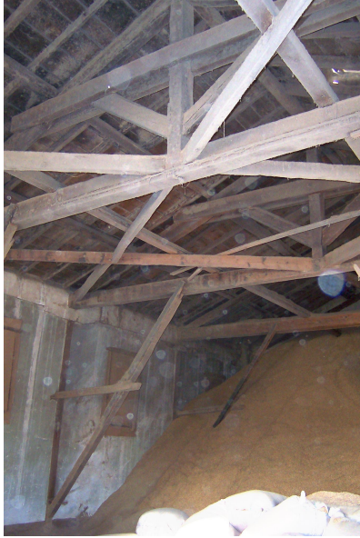
Foto Ek 1.297 Şamlılar Çeltik Fabrikası, 2-01 mahalli, kuzeybatı yönüne bakış, biriken çeltik kabukları yapıda 2-01, 2-03 ve 2-04 mekanları içinde biriktirilmekte, Ekim 2003
