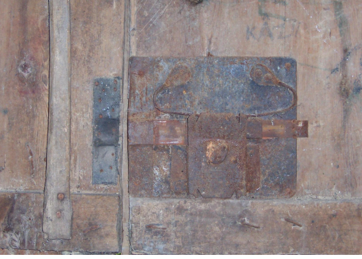
Foto Ek 1.25 Boyabat, Şamlıların Değirmeni, giriş kapısındaki özgün demir kilit, Eylül 2004
