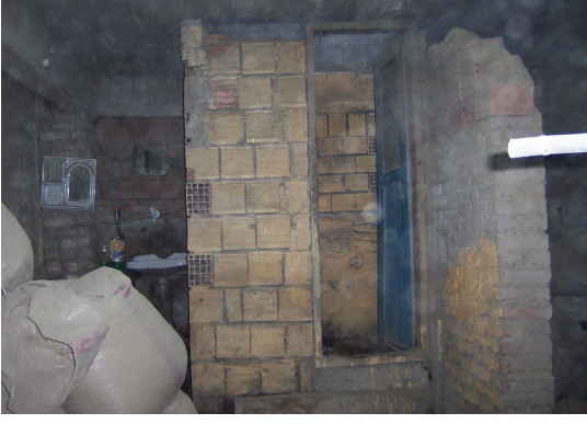
Foto Ek 1.252 Şamlılar Çeltik Fabrikası, Z-07 Depo mekanı kuzeydoğu yönü ve Z-08 WC mekanı, Nisan 2004
