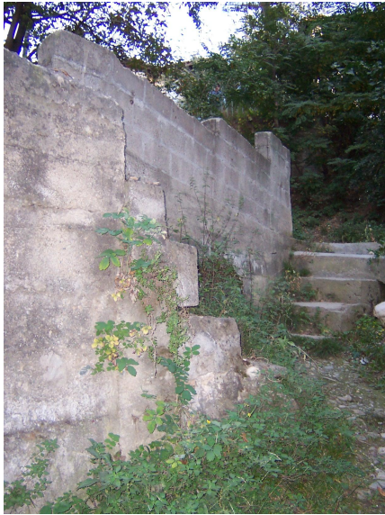
Foto Ek 1.14 Boyabat, Şamlıların Değirmeni, güney yönünde bulunan beton arkların platformuna çıkan merdivenler, Eylül 2004
