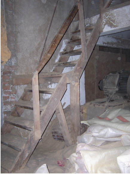
Foto Ek 1.248 Şamlılar Çeltik Fabrikası, zemin kat giriş holü sonundan 1-03 Üretim 2 mahalline çıkan ahşap merdiven, Nisan 2004
