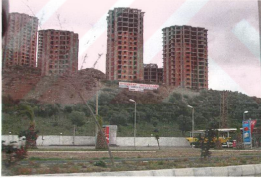
Şekil 3.8 Kuşadası'nda yapılmakta olan Uydukent Konut Yapı Kooperatifi'nin farklı bir açıdan görünüşü.
