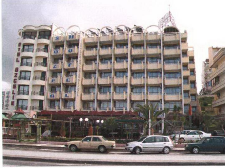
Şekil 3.1 Kuşadası'ndaki sahile paralel yerleşmiş otellere bir örnek.
