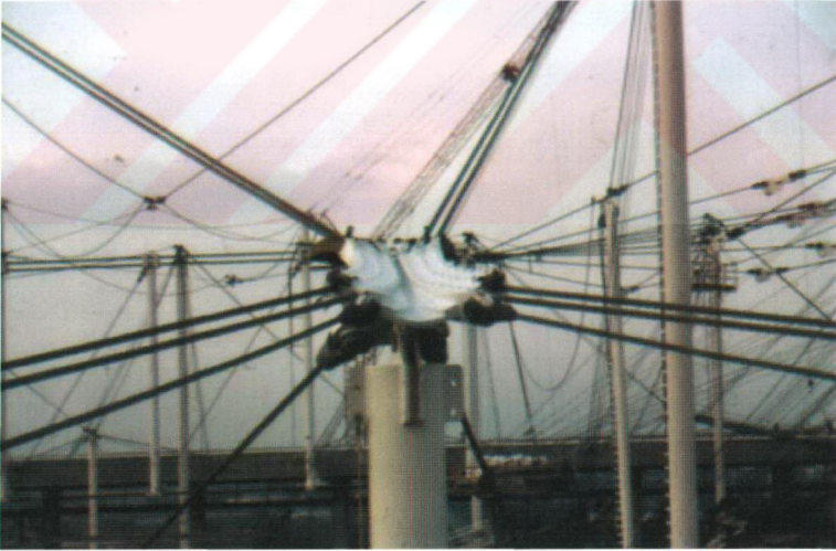
Şekil Ek 3.20 Kablo ve çubuk bağlantı detayı ( www.columbia.edu )
