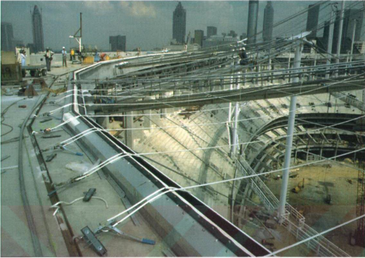
Şekil Ek 3.15 Kabloların mesnetlere bağlanması (www.columbia.edu)
