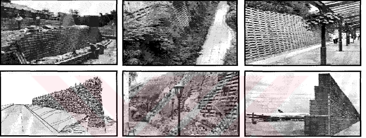
Şekil 4.50 Serbest ayakta duran bitkilerle çevrili kutu şeklinde gürültü duvarı (Farnham ve Beimborn, 1990; [58])
