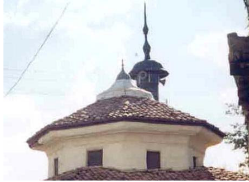
Şekil 4.24 Beyazid-i Bestami Camii
