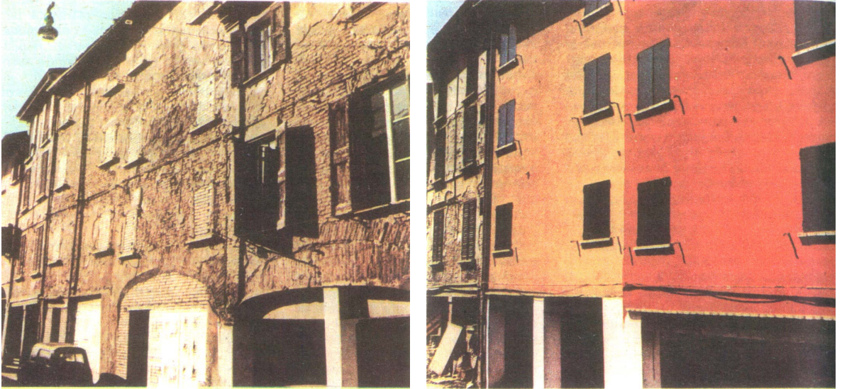
Şekil 3.5 Santa Codenina sokağındaki iki yapının onarım öncesi ve sonrası durumları (Mimarlık,1979)
