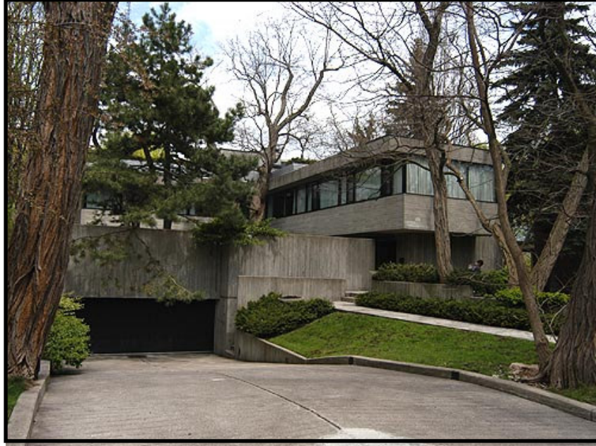
Şekil 3.10 Berkshire House, Toronto [5].
