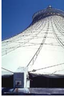
Şekil 3.18 Kablolu ağ sistemli çatı örtüsünün görünüşü [29]
