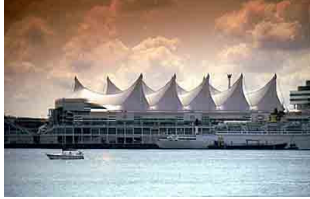
Şekil 3.16 Kanada’da bir sığınağın çatı örtüsü [28]
