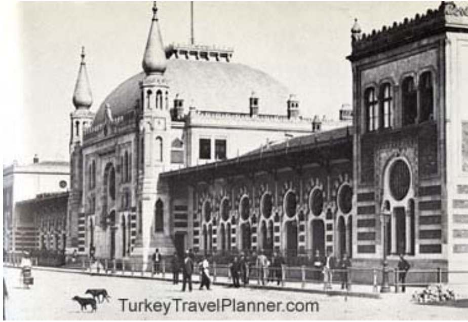
Şekil 3.3 Sirkeci Garı, deniz cephesi[4].
