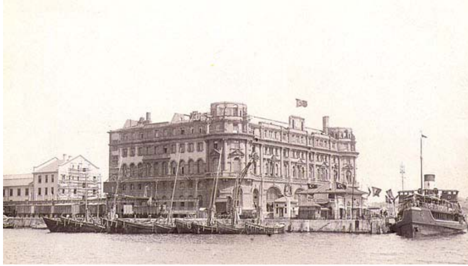
Şekil 3.14 Haydarpaşa Garı'nın patlamadan sonra uçan çatısı (Eyice,2004).
