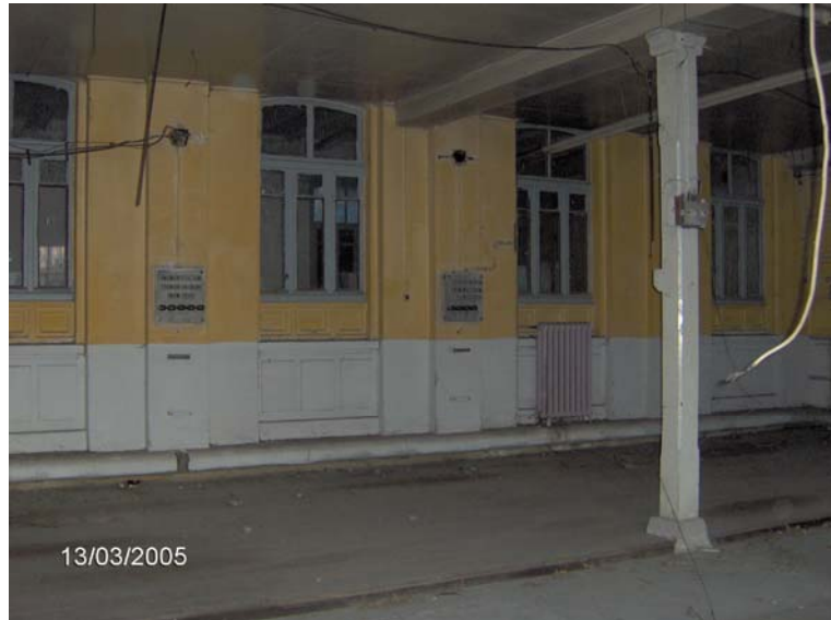
Şekil 4.104 Güneybatı cephesi zemin kat pencereleri.
