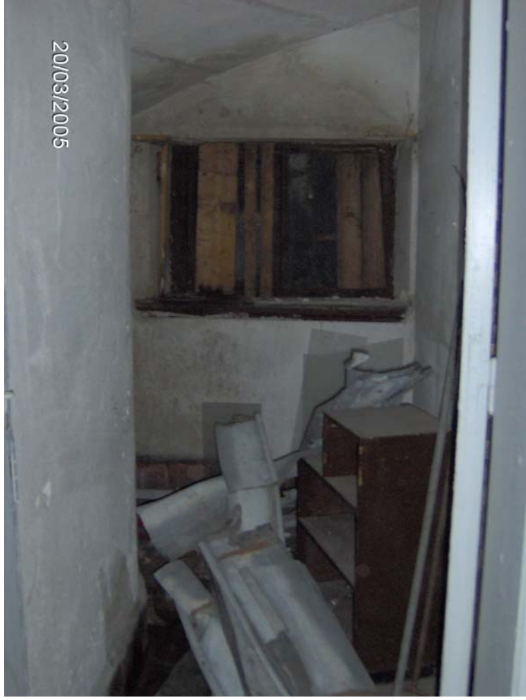
Şekil 4.62 Merdiven altındaki pencere boşluğu (Z01).
