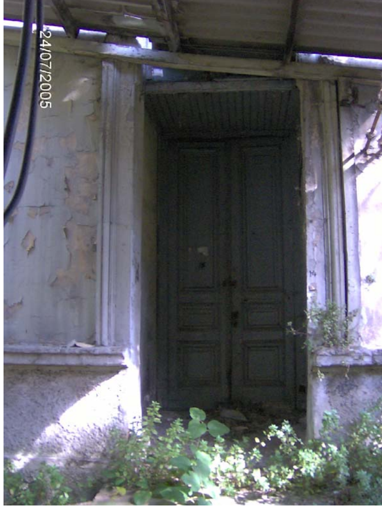
Şekil 4.37 Kuzeybatı cephesindeki muhdes giriş kapısı.
