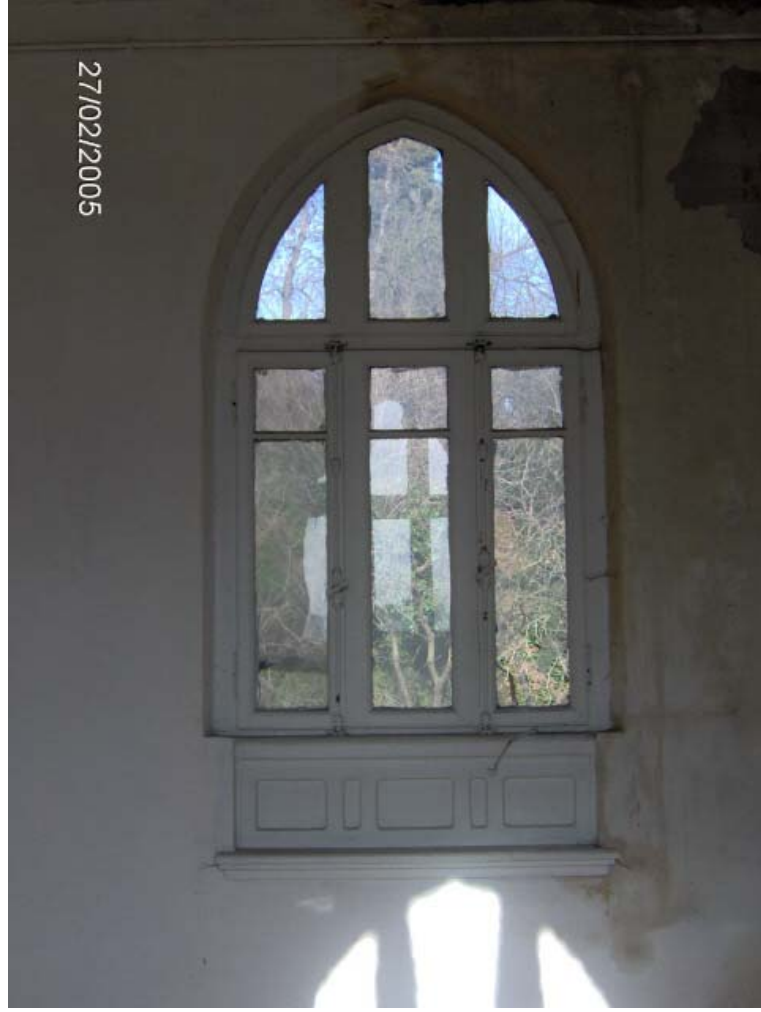
Şekil 4.91 1. kat B03 no'lu koğuştaki ahşap pencere (P6).
