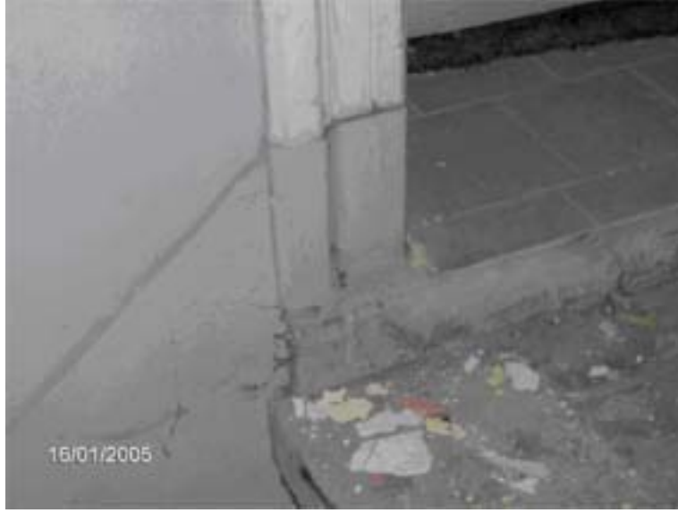
Şekil 4.130 B04 no'lu mekanın yükseltilmiş ve fayans kaplanmış yer döşemesi.
