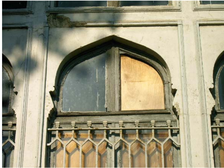
Şekil 4.46 Camlardaki eksiklikler kontrplak ile kapatılmıştır.
