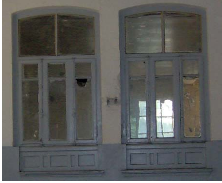
Şekil 4.83 Zemin kat Z02 no'lu koğuştaki ahşap pencere (P2).
