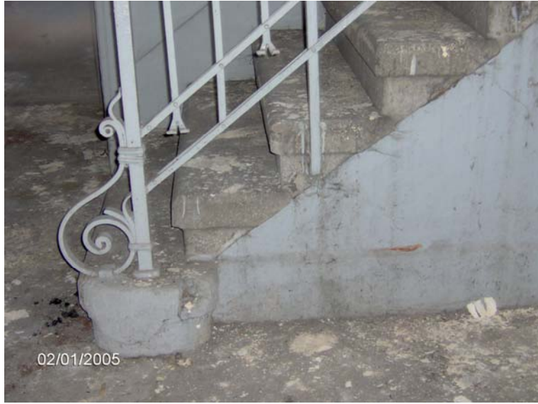
Şekil 4.84 Dökme mozaik basamaklar ve demir korkuluk (Z01).
