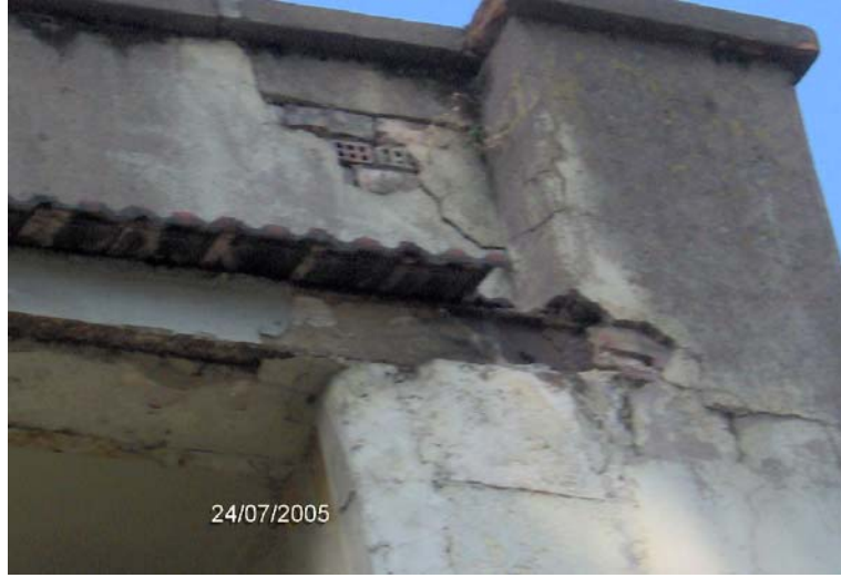
Şekil 4.34 Kapının üzerinde sonradan eklenen kiremitler.
