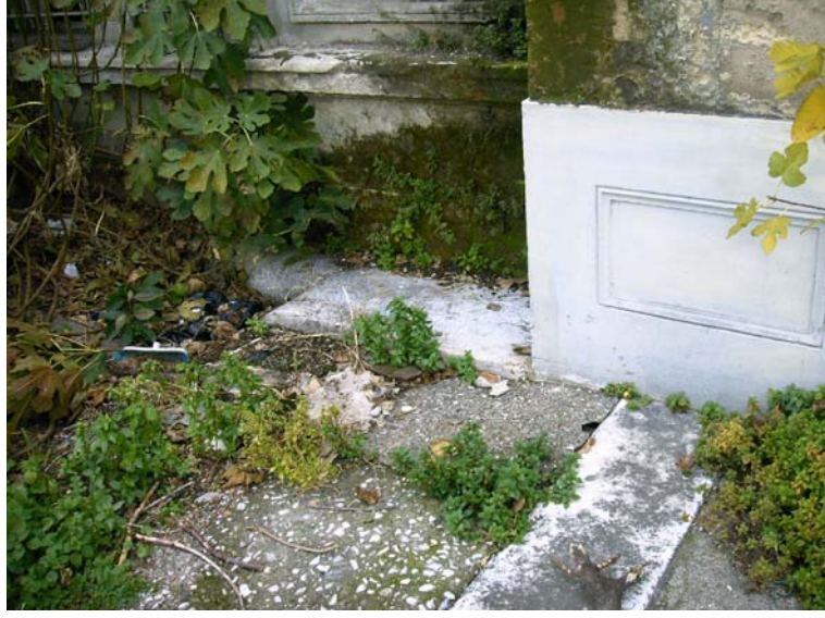
Şekil 4.33 Giriş bölümünün solunda beton dökülerek rampa yapılan kısım.
