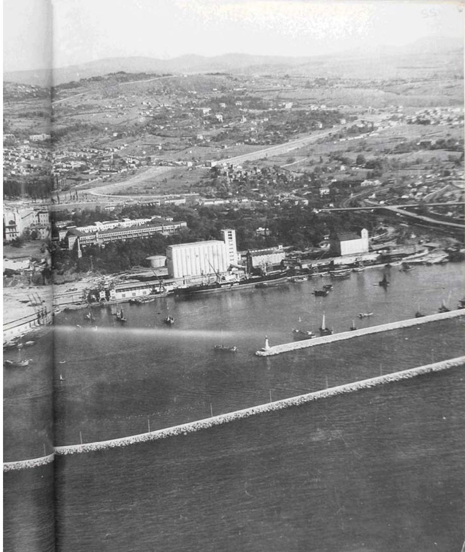
Şekil 3.5 Haydarpaşa'nın havadan görünümü (Şahenk,1996).
