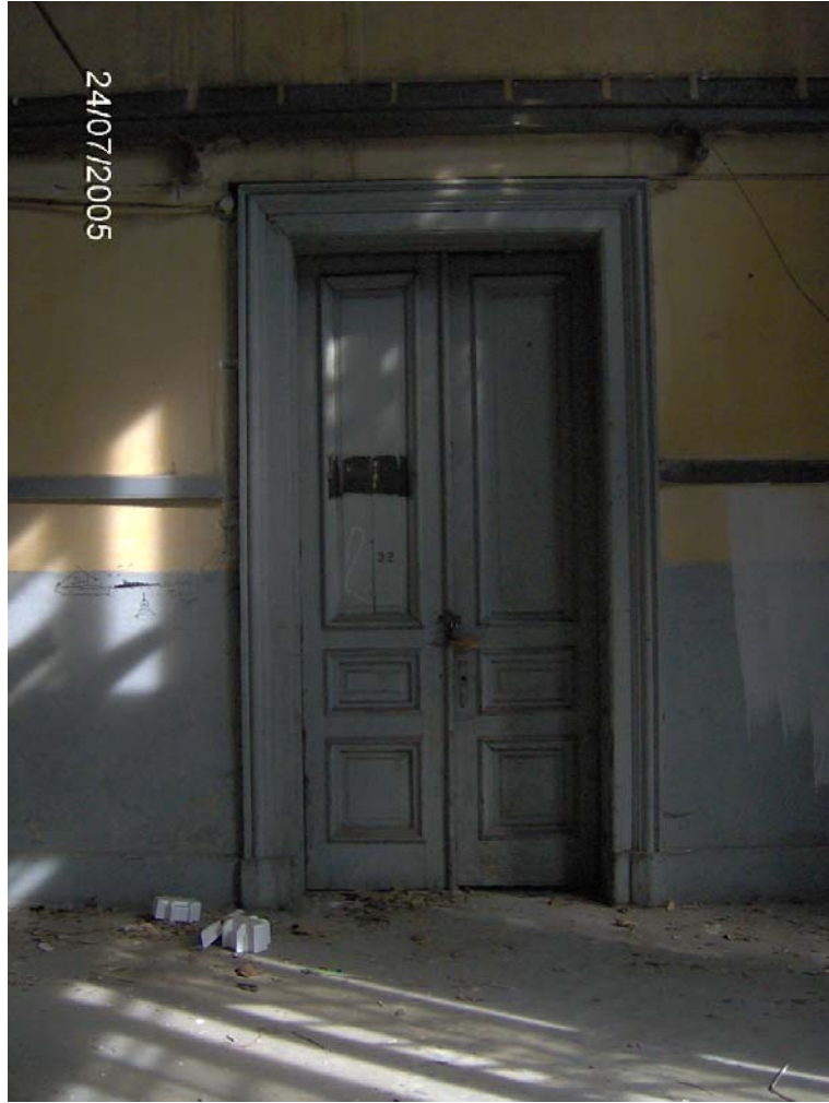
Şekil 4.14 Ahşap iç kapı (Z01).
