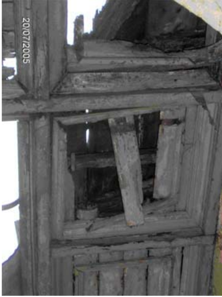
Şekil 4.127 Saçakta kopmalar.
