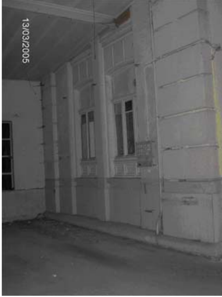
Şekil 4.110 Kuzeybatı cephesindeki zemin kat pencereleri.
