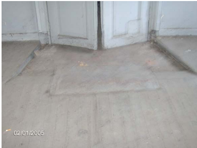
Şekil 4.79 Zemin kat Z02 no'lu koğuştaki ahşap döşeme (Z02).
