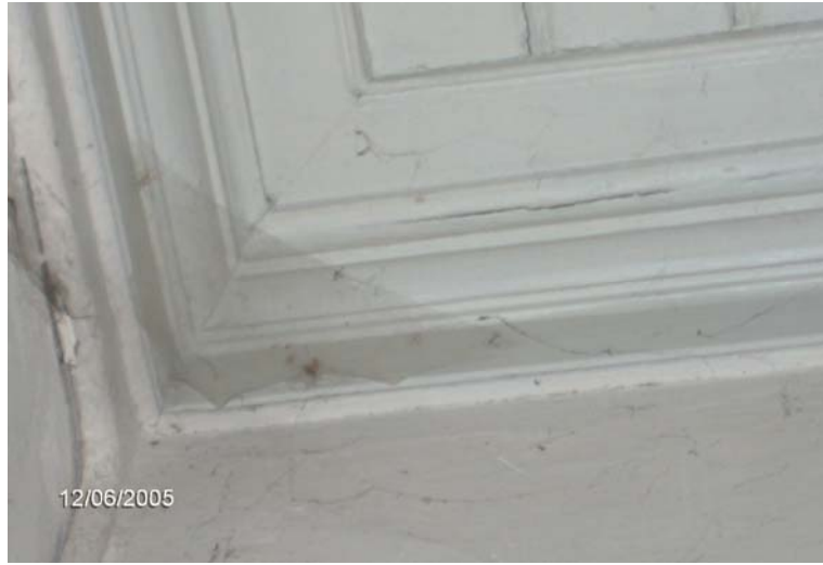
Şekil 4.94 1. katta bulunan koğuşun ahşap tavanı (B02).
