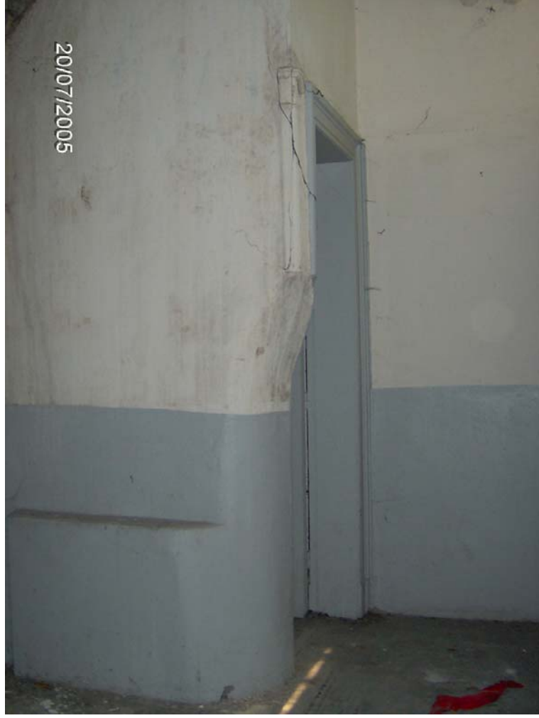
Şekil 4.61 Merdiven altı (Z01).
