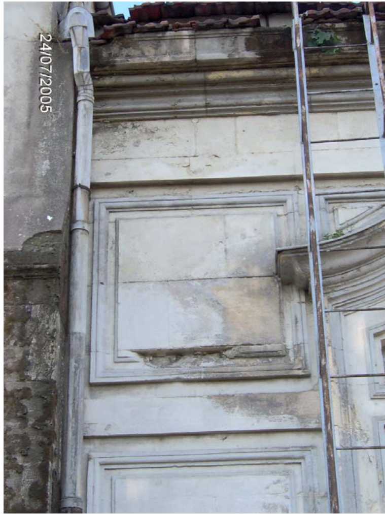
Şekil 4.43 Taş malzemede kopmalar.
