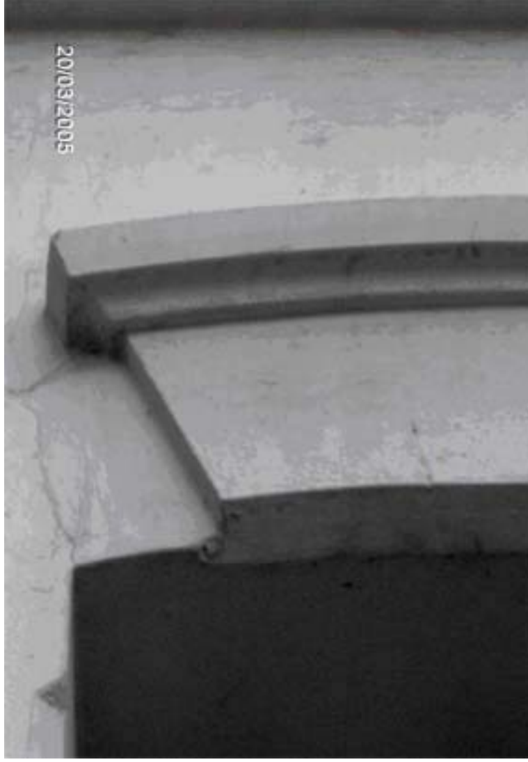
Şekil 4.109 Pencere üzerindeki kilit taşları.
