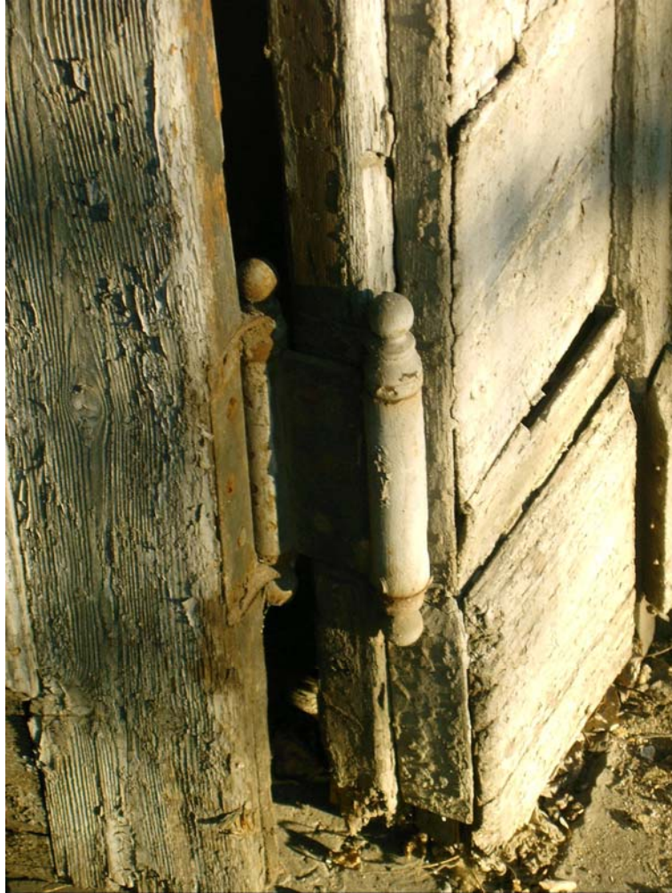
Şekil 4.16 Çarpma kapının dökme demir menteşesi.
