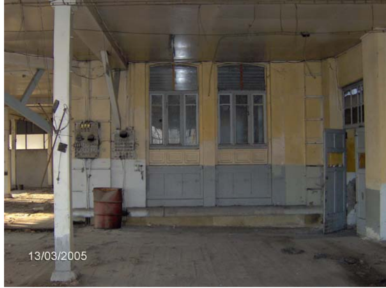
Şekil 4.105 Zemin kat güneydoğu cephesi.
