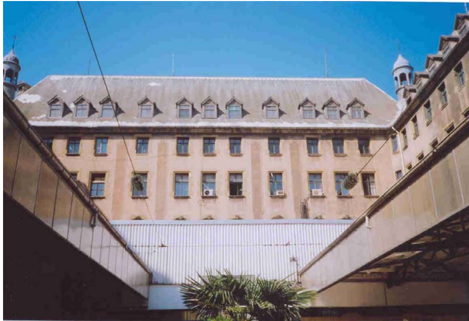
Şekil 3.17 Haydarpaşa Garı kuzey cephesi.
