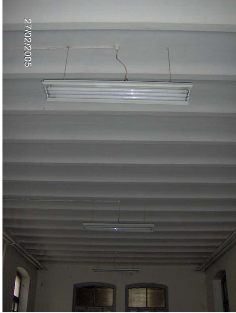
Şekil 4.77 Zemin kat Z02 no'lu koğuştaki volta döşeme (Z02).
