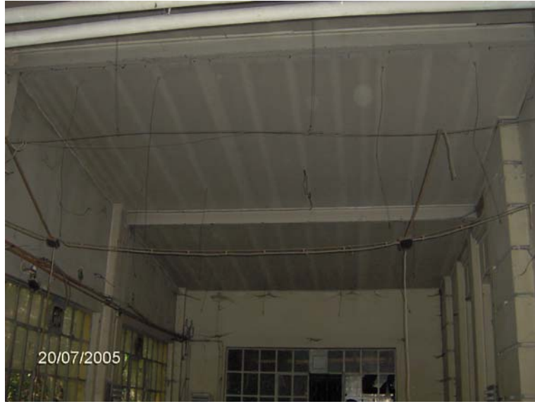
Şekil 4.97 Kuzeybatı cephesindeki ek yapının çelik kirişleri.
