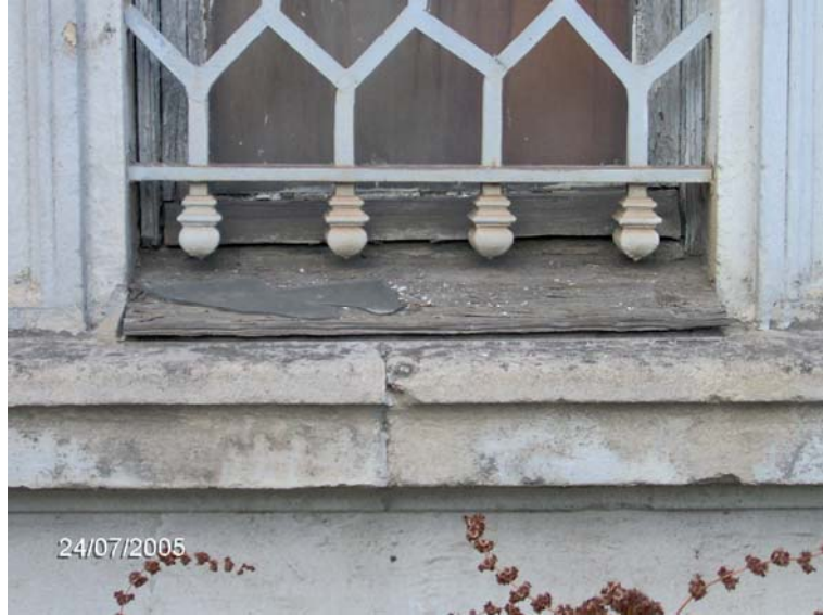
Şekil 4.12 Taş silme üzerinde ahşap denizlik.
