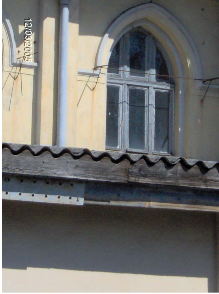
Şekil 4.98 Güneybatı cephesindeki ek yapının eternit çatı kaplaması.
