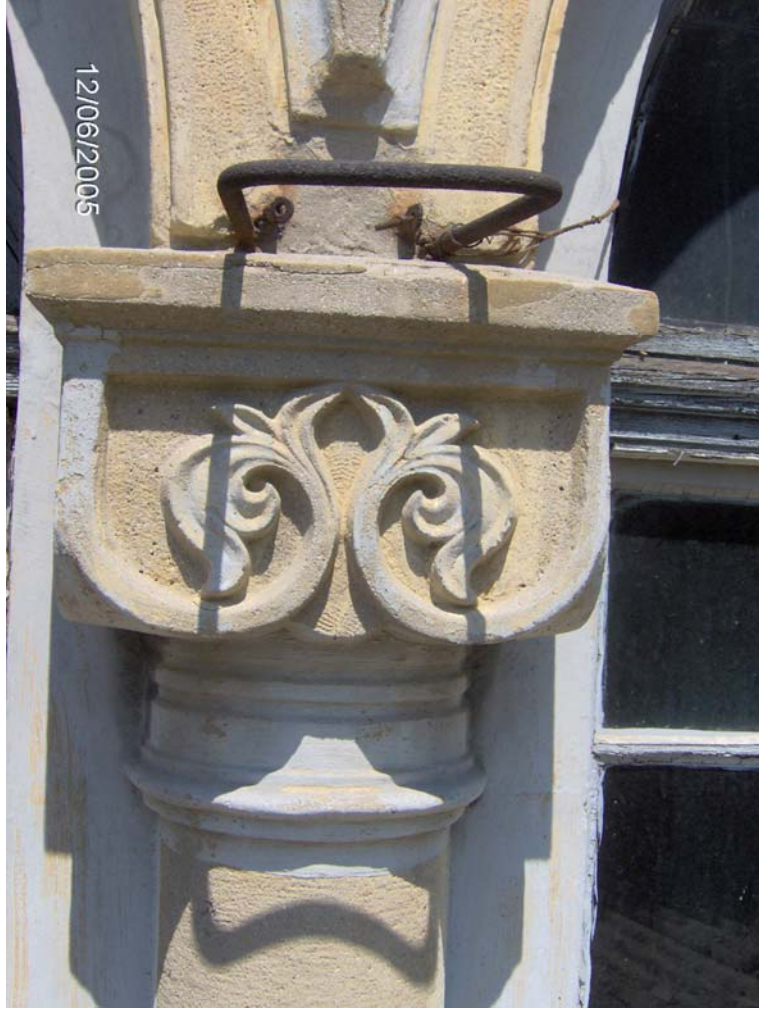
Şekil 4.102 Giriş bölümünü üzerindeki iki pencere arasındaki yuvarlak sütun.
