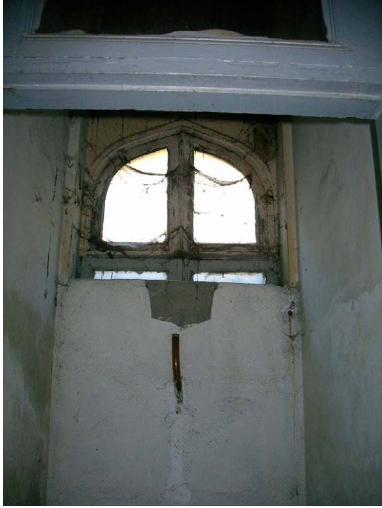
Şekil 4.31 Tuvalet yapımı için pencere önü duvarla doldurulmuş (Z06).
