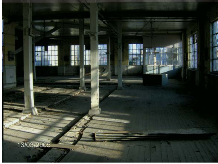
Şekil 4.75 Güneybatı cephesindeki ek yapı.
