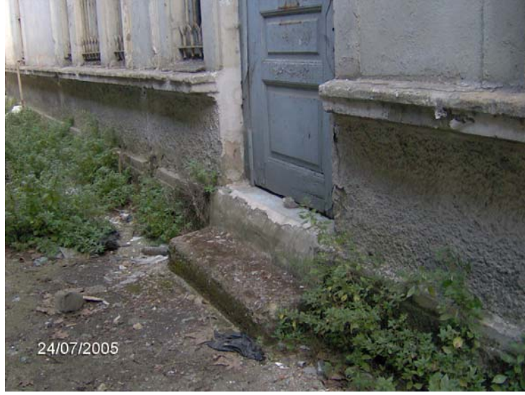
Şekil 4.40 Kuzeydoğu cephesindeki muhdes giriş kapısı ve muhdes basamaklar.
