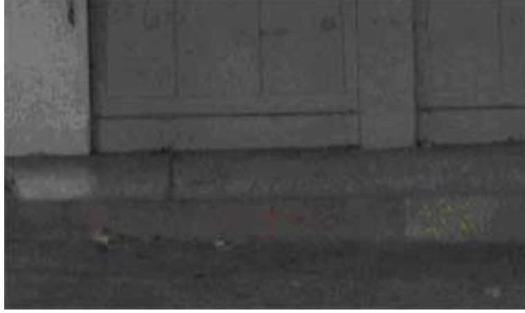
Şekil 4.116 Subasman seviyesindeki taş silme ve onun altında taş kaplama.
