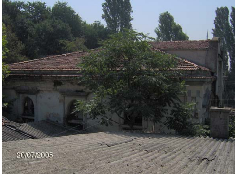
Şekil 4.10 Askeri Karakol binasının çatısı.
