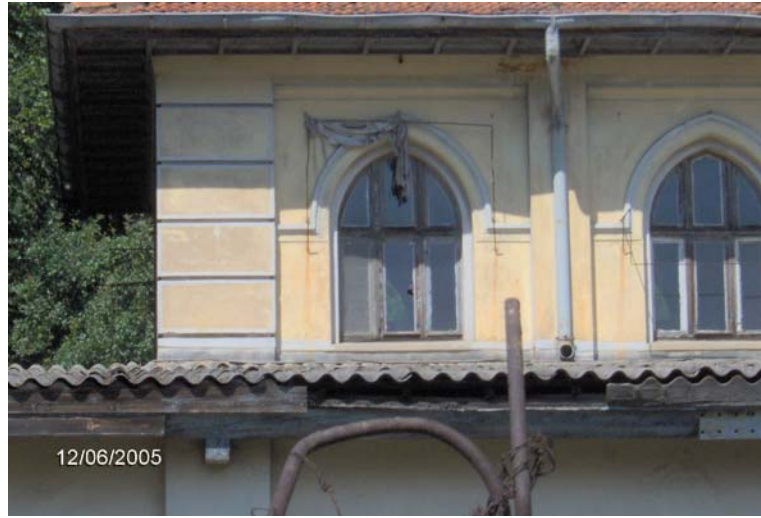
Şekil 4.103 Güneybatı cephesi 1. kat pencereleri.
