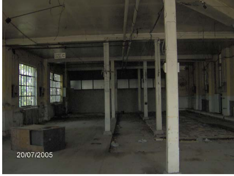
Şekil 4.96 Güneybatı cephesindeki ek yapının ahşap dikme ve kirişleri.
