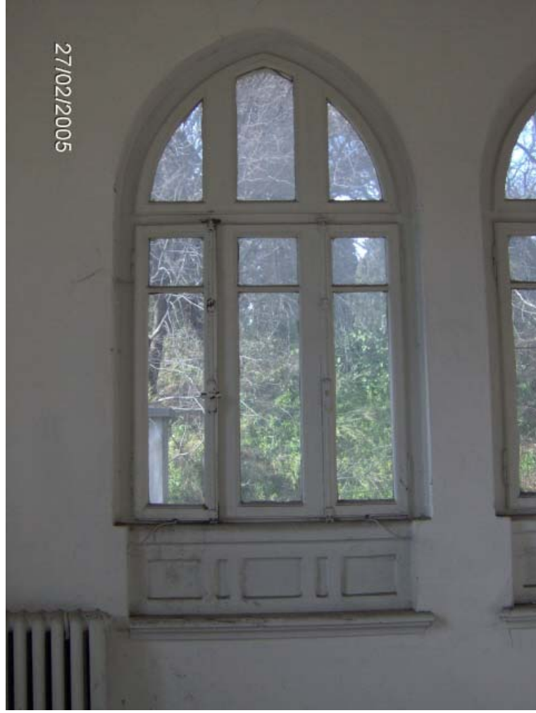
Şekil 4.89 1. kat B03 no'lu koğuştaki ahşap pencere (P5).
