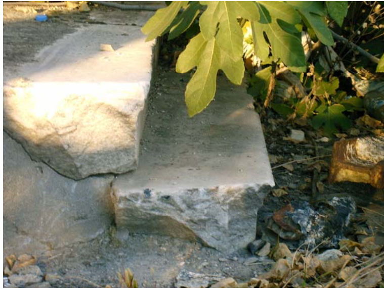
Şekil 4.50 Mermer basamakların köşelerinde kopmalar.
