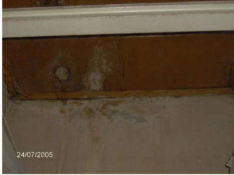
Şekil 4.51 Orta sofanın kontrplak ile oluşturulmuş tavanı (Z01).
