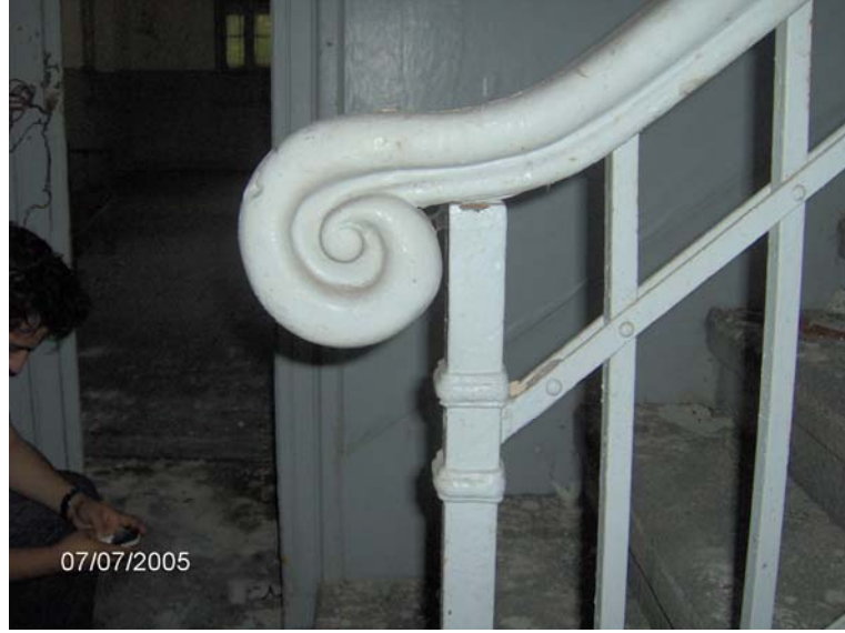
Şekil 4.85 Ahşap korkuluk tokmağı (Z01).
