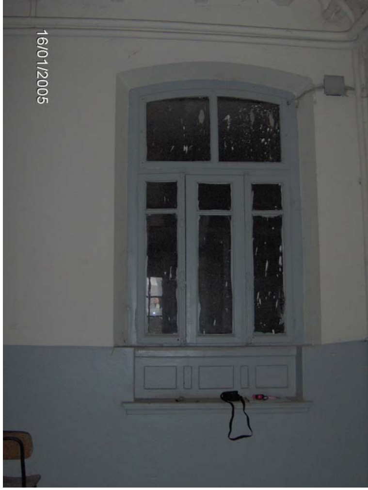
Şekil 4.82 Zemin kat Z02 no'lu koğuştaki ahşap pencere (P1).
