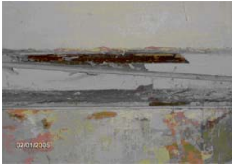
Şekil 4.131 Ahşap süpüreliliklerde yer yer çürüme (B01).
