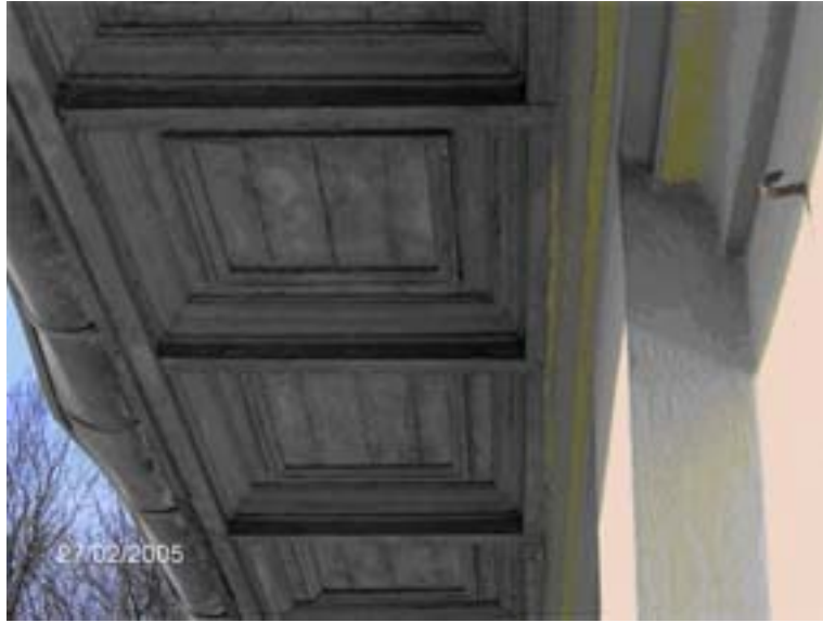
Şekil 4.117 Kafes bezemeden oluşan ahşap saçak.
