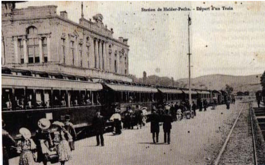
Şekil 3.8 İlk İstasyon Binası (Erkan,2004).
