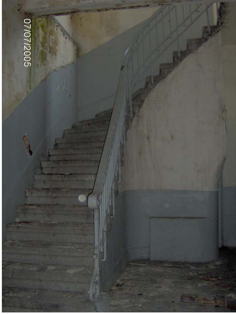
Şekil 4.60 Giriş holündeki merdivenler (Z01).
