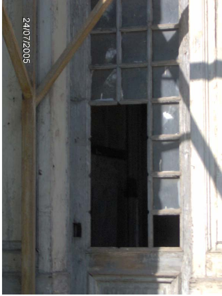
Şekil 4.48 Ahşap parçalarda eksiklikler ve ahşapta aşınma.
