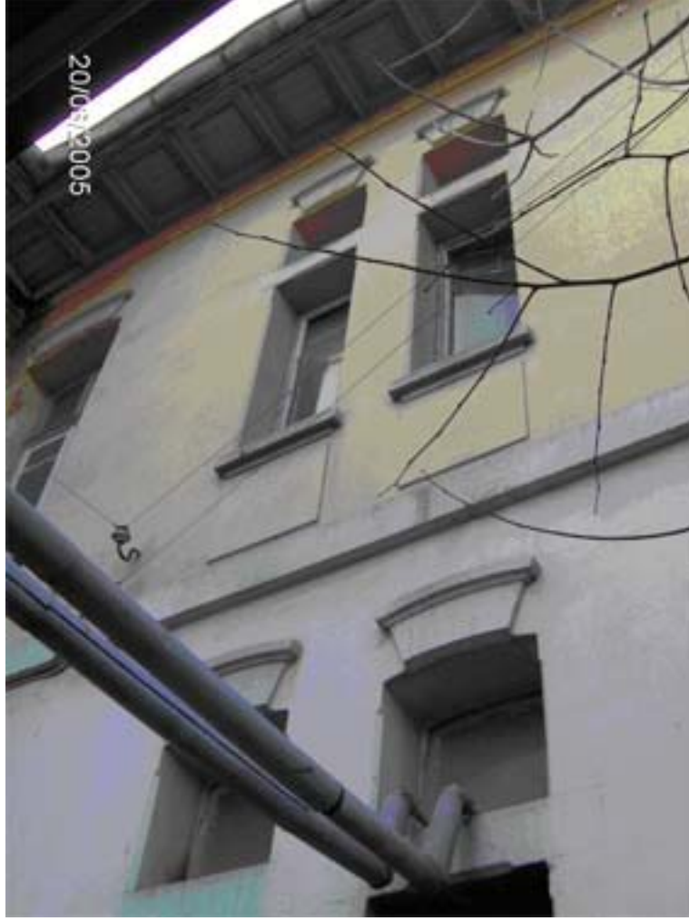
Şekil 4.108 Güneydoğu cephesinde çıkma yapan bölümün pencereleri.
