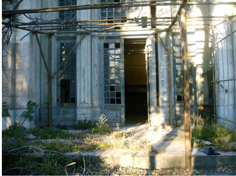
Şekil 4.1 Orta sofaya girişin sağlandığı ahşap çarpma kapı.
