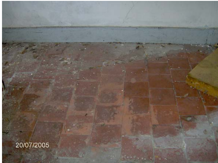
Şekil 4.88 1. kat orta sofadaki seramik döşeme ve ahşap süpürgelik (B01).
