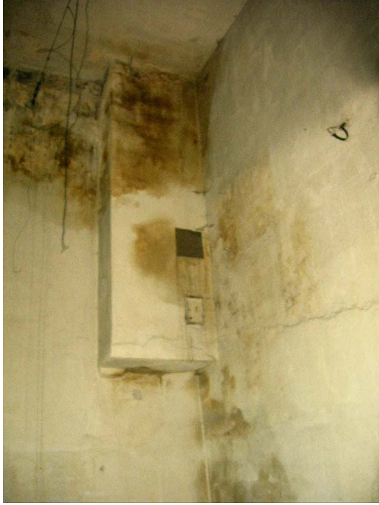
Şekil 4.53 Z04 no'lu mekanda yer alan baca duvarı.
