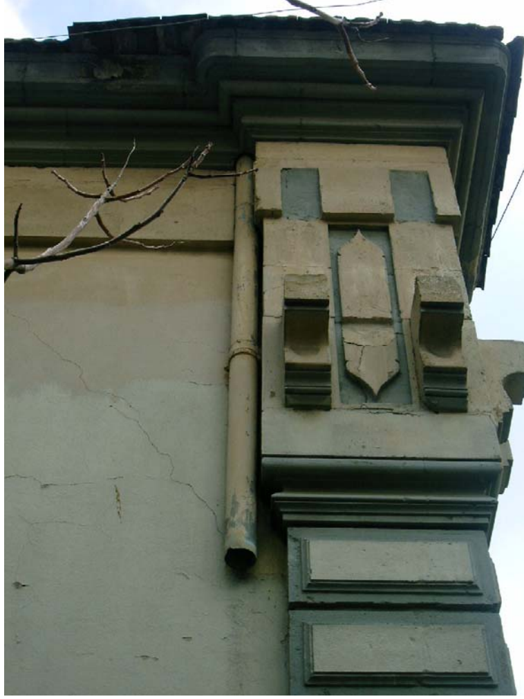
Şekil 4.32 Köşe saçaklarının oturduğu elemanlar.
