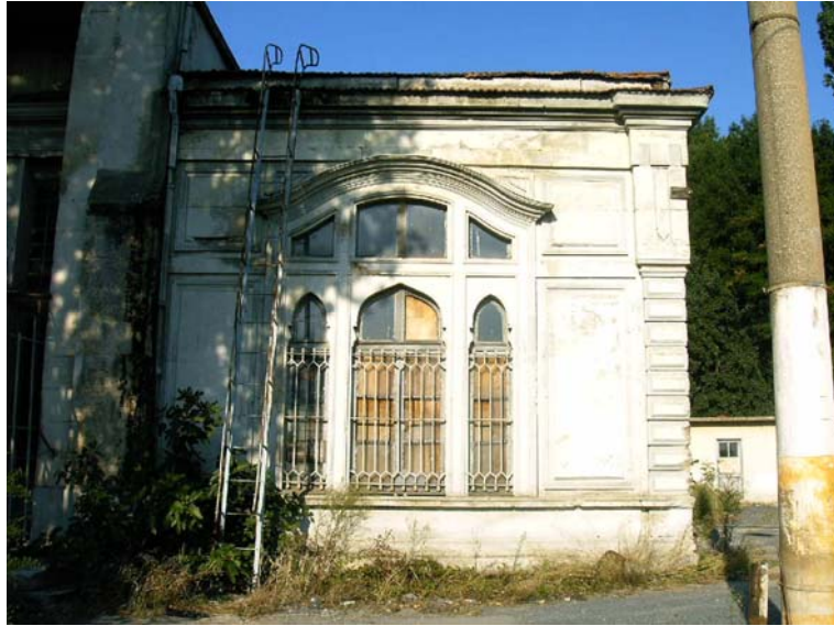
Şekil 4.22 Üçlü açıklıklı pencere düzeni.
