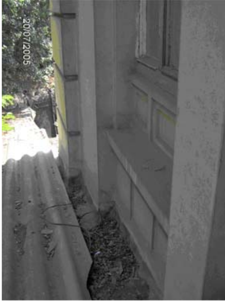
Şekil 4.123 Kuzeybatı cephesinin ek yapılar ile ilişkisi.
