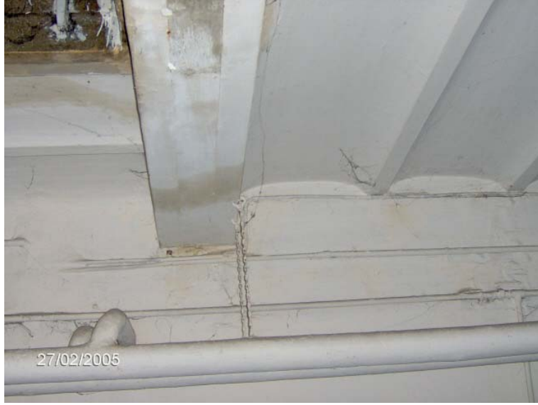
Şekil 4.78 Zemin giriş holündeki volta döşeme (Z01).
