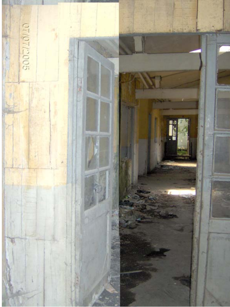
Şekil 4.76 Yapının güneydoğu cephesindeki ek yapılar.
