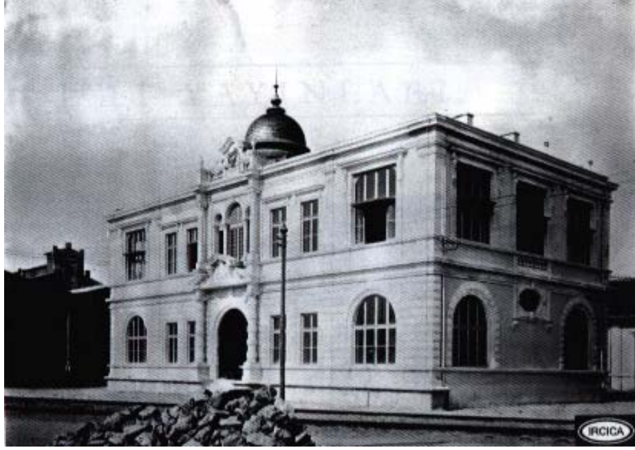
Şekil 3.25 Gümrük Binası (Erkan,2004).
