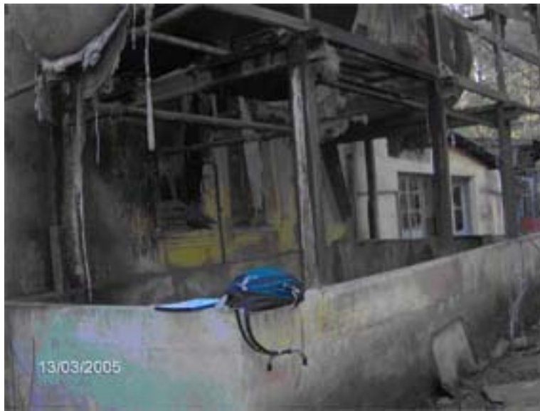
Şekil 4.115 Kuzeydoğu cephesindeki depo.
