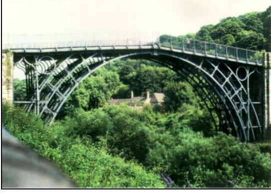
Şekil 4.4 a. İlk dökme demirden yapılmış köprü, Coalbrookdale Köprüsü, 1779, İngiltere b. Çelik ve cam kullanılarak yapılmış ilk prefabrikasyon bina, Crystal Palace, 1889, İngiltere
