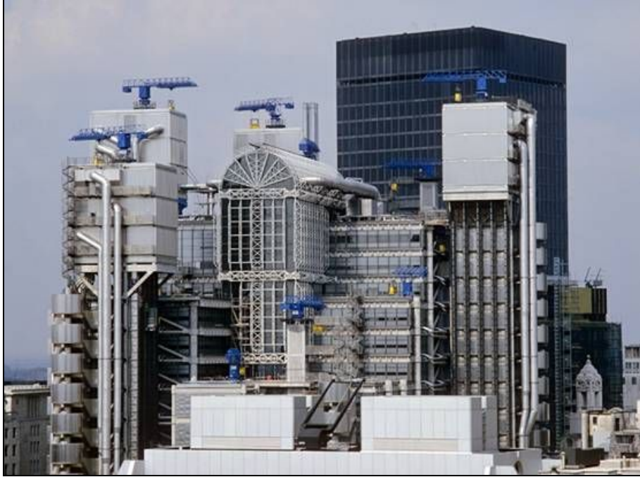
Şekil 3.30 Lloyd's Binası, Richard Rogers
