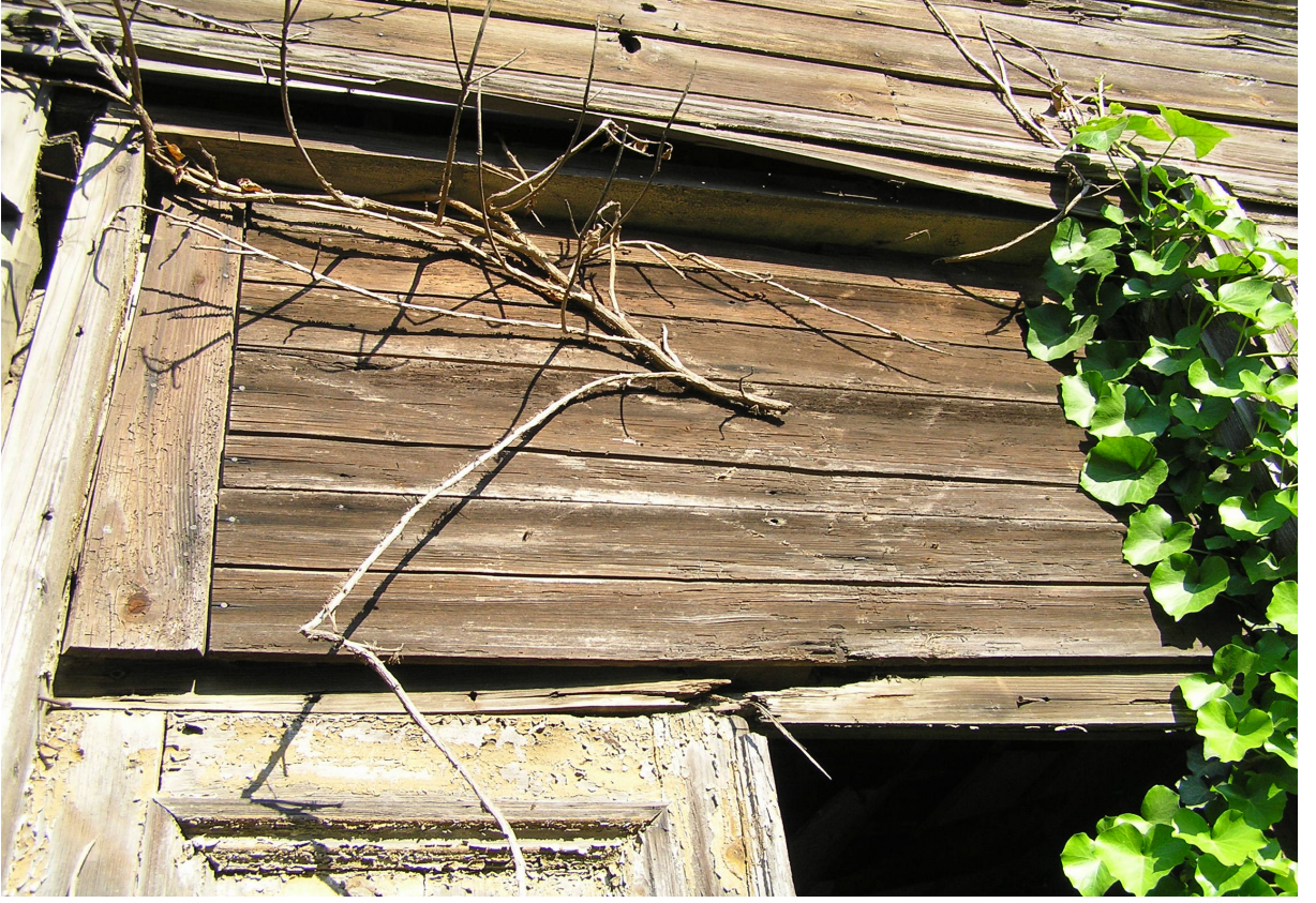
Resim 4.27 Giriş kapısının sökülen üst kısmına çakılan tahtaların durumu
