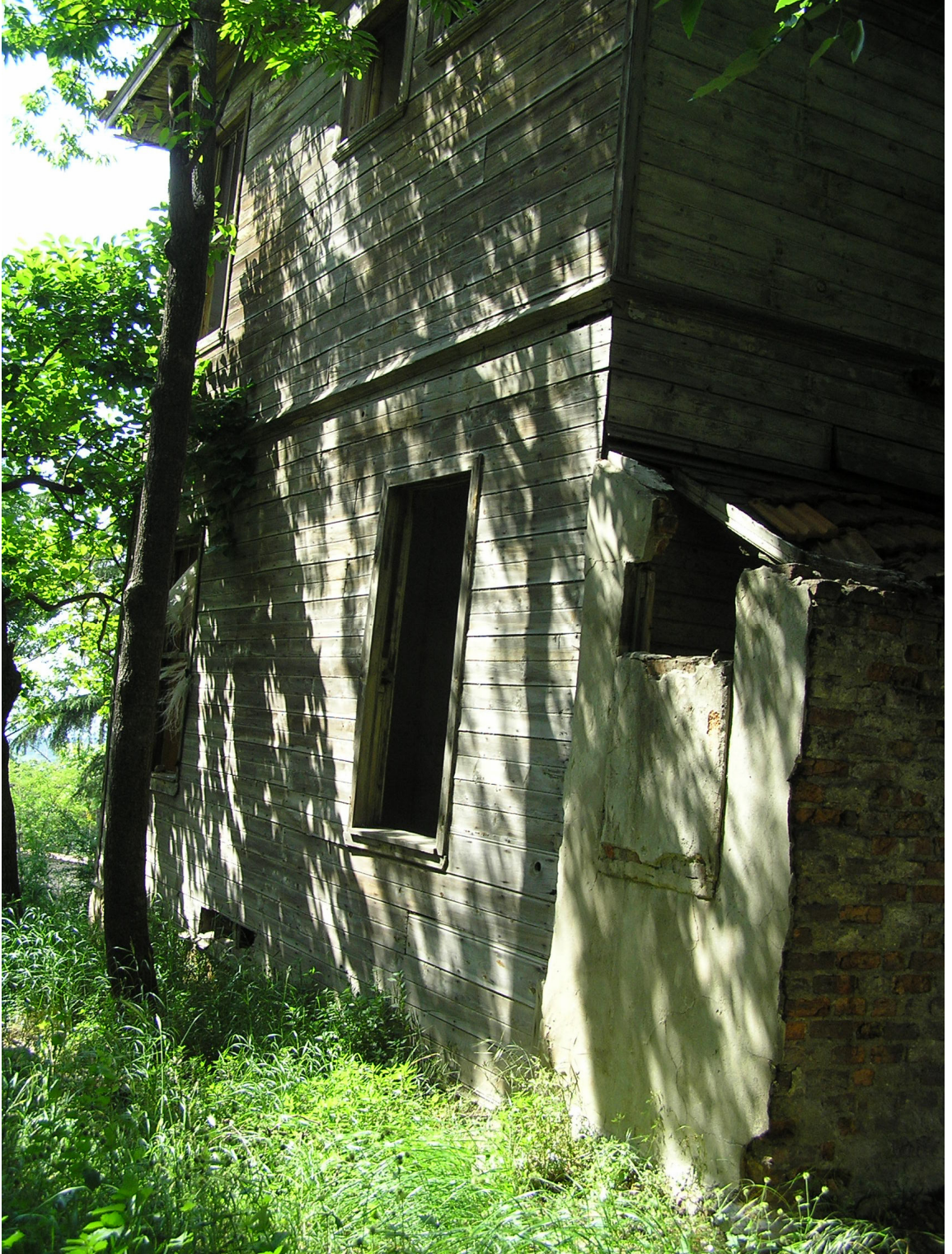
Resim 4.65 Sağ yan cephe görünüş
