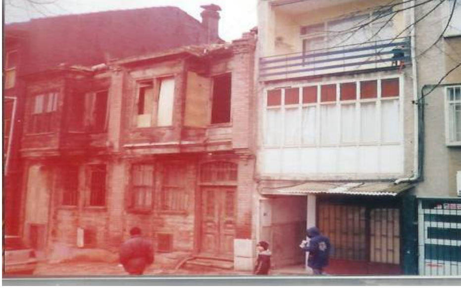
Resim 3.14 Bağlarbaşı-Allame Cad. No: 77 (Kapı boşluğu kapatılmış)
