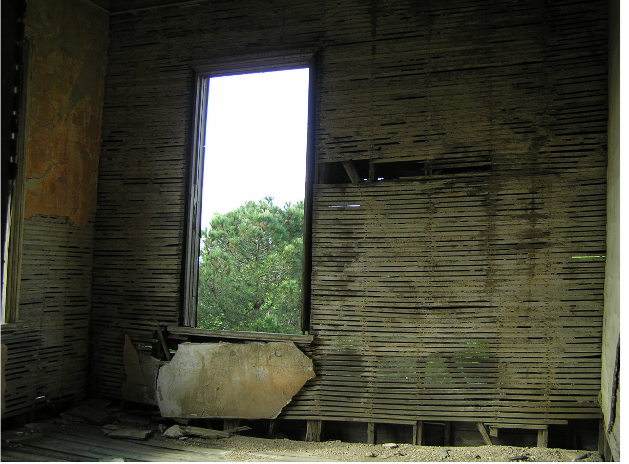
Resim 4.62 1K02 no'lu odadan sol yan bahçe tarafına bakan duvara bakış
