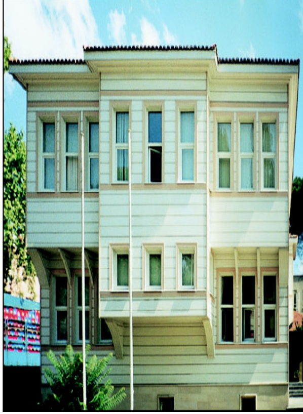
Resim 3.9 Restorasyon sonrası betonarme sisteme örnek (Altunizade Ord. Prof. Fahrettin Kerim Gökay Cad. No: 1)
