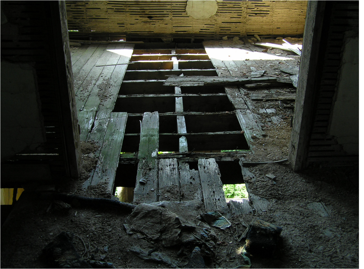
Resim 4.66 Ahşap döşeme kirişleri ve 125*12,5 cm ahşap döşeme kaplamaları
