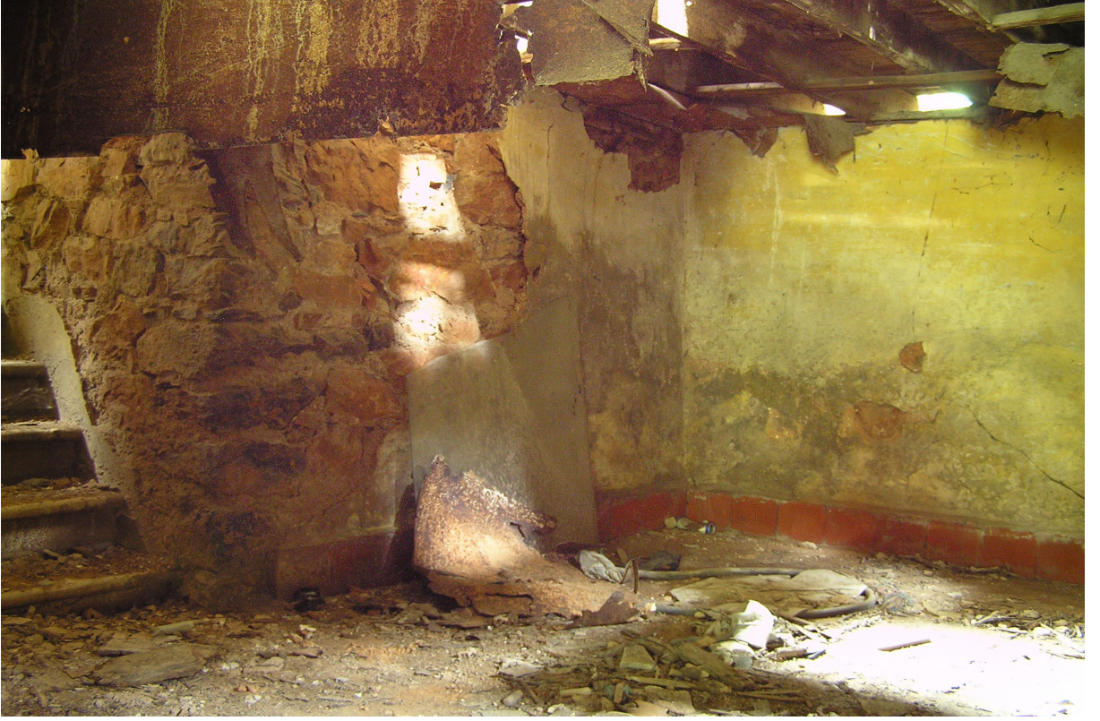
Resim 4.21 Yapıdaki kagir duvarların günümüzdeki sıva ve döşemelerin kaplama durumu
