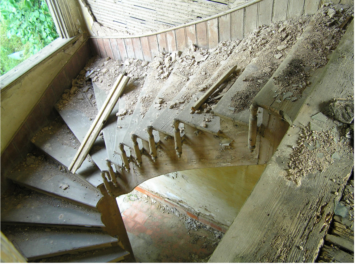
Resim 4.37 Ahşap merdiven korkuluklarının mevcut hali
