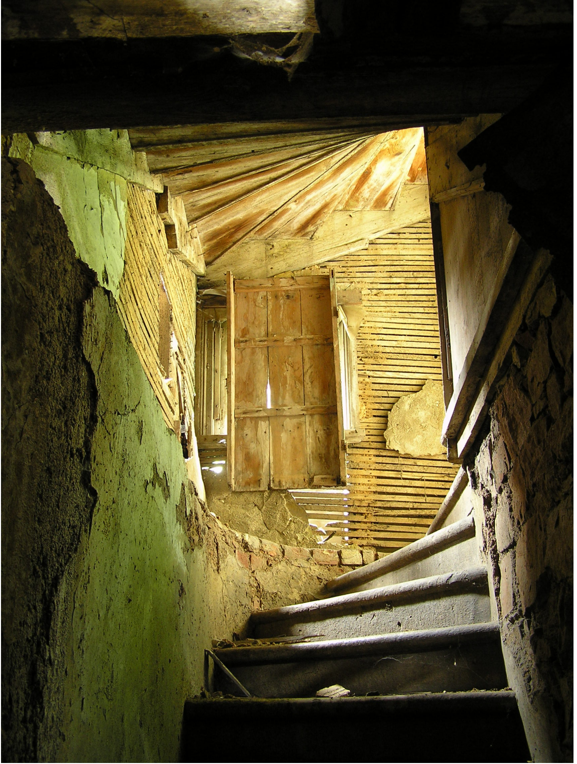
Resim 4.73 Bodrum kattan çıkış merdiven evindeki pencere boşluğunun mevcut durumu
