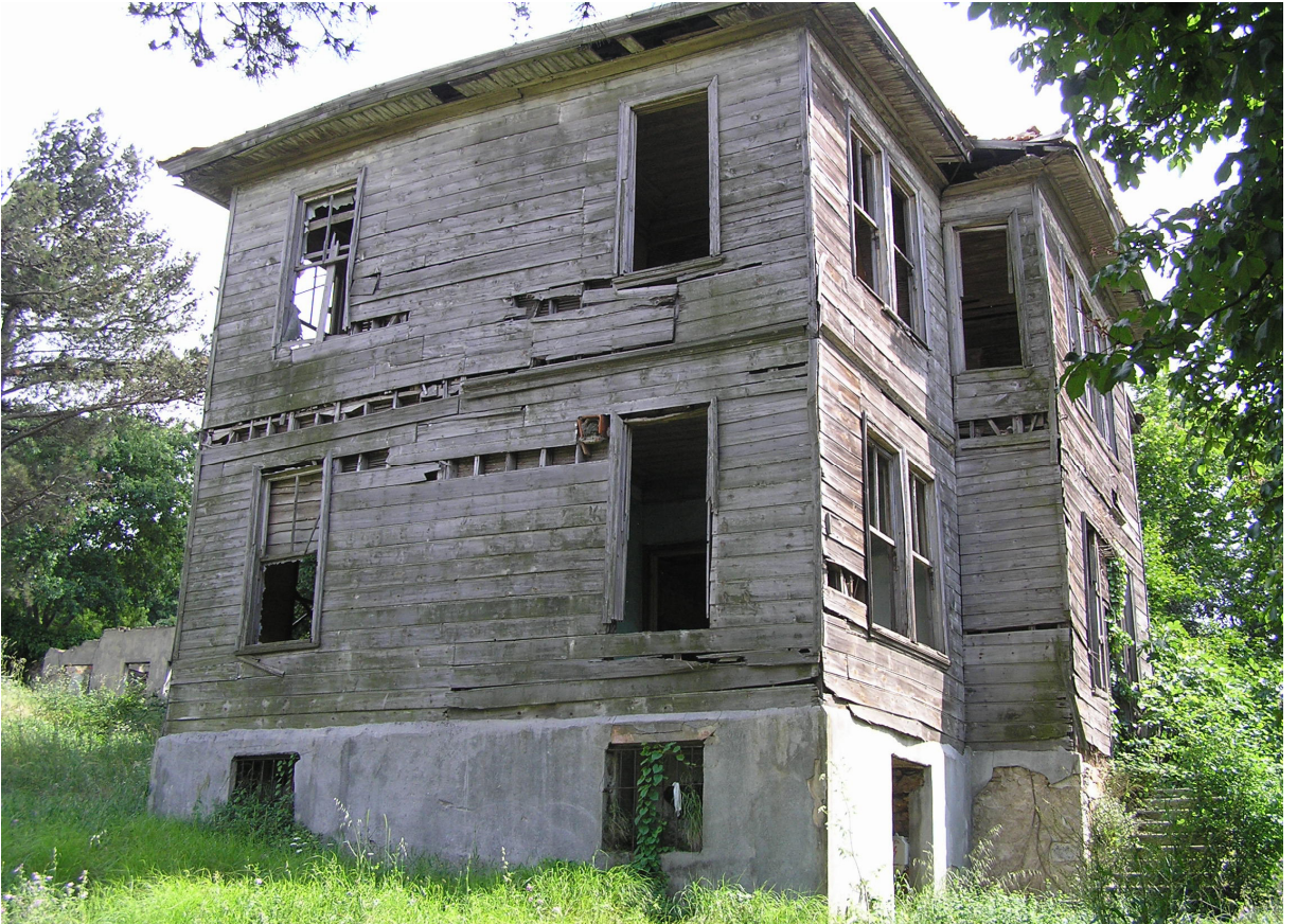
Resim 4.71 Sol yan cephe görünüş
