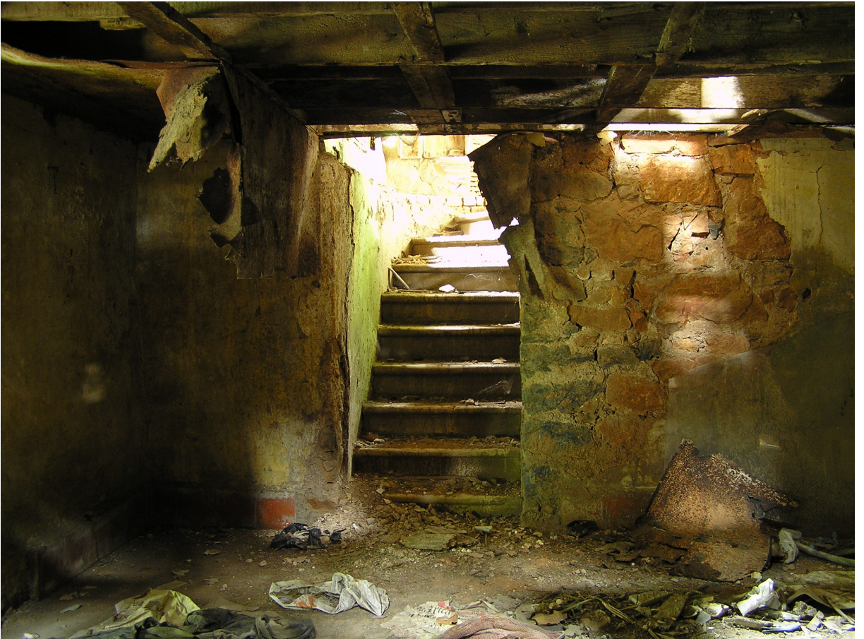
Resim 4.20 BK03 no'lu mekanın genel görünüşü
