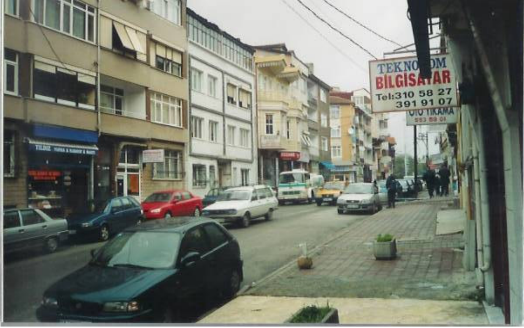
Resim 3.2 Çalışma alanından betonarme sisteme örnek (Bağlarbaşı Allame Cad No: 103-105)
