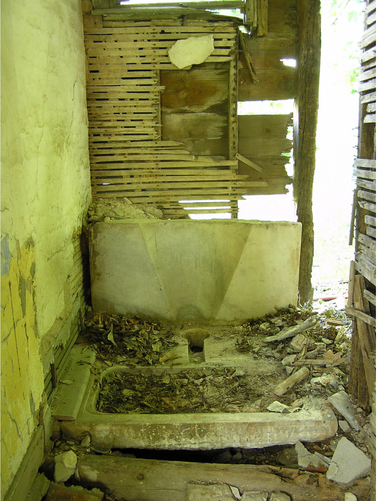
Resim 4.41 ZK05 no'lu oda wc mekanı
