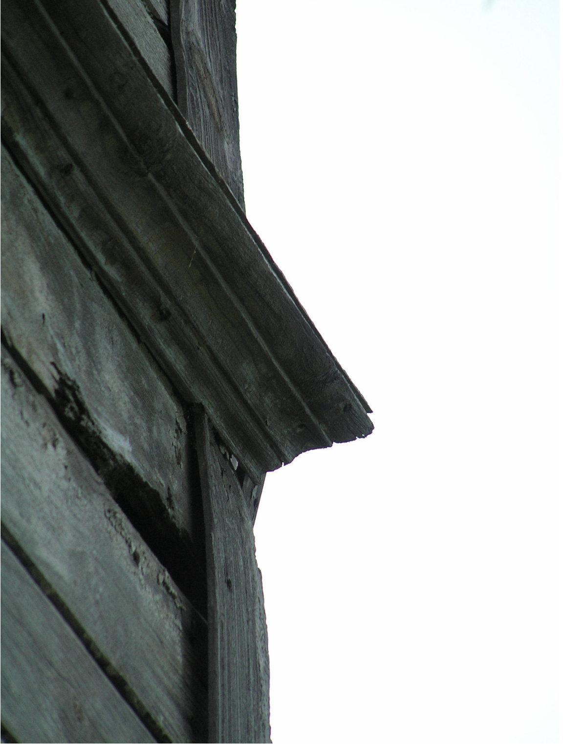
Resim 4.69 Kat silmesi detay görünüşü
