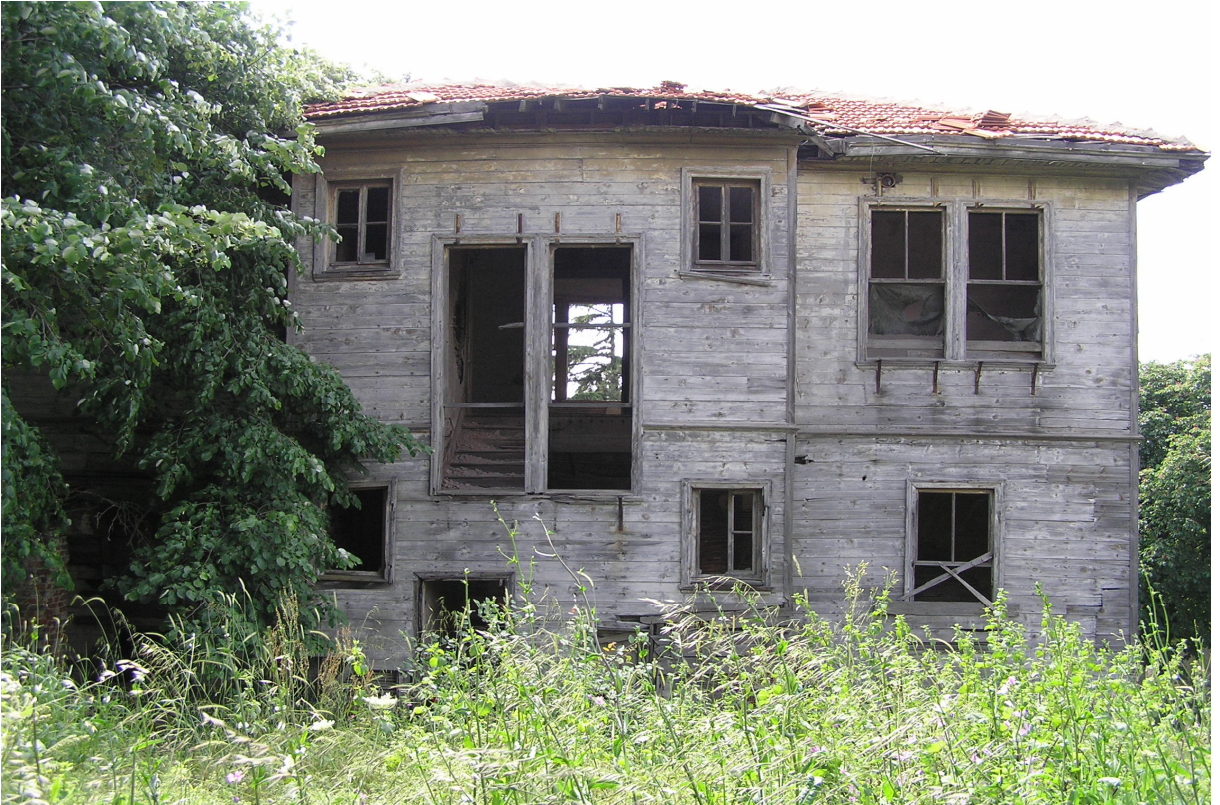
Resim 4.36 Merdiven evindeki 93/300cm'lik pencereler
