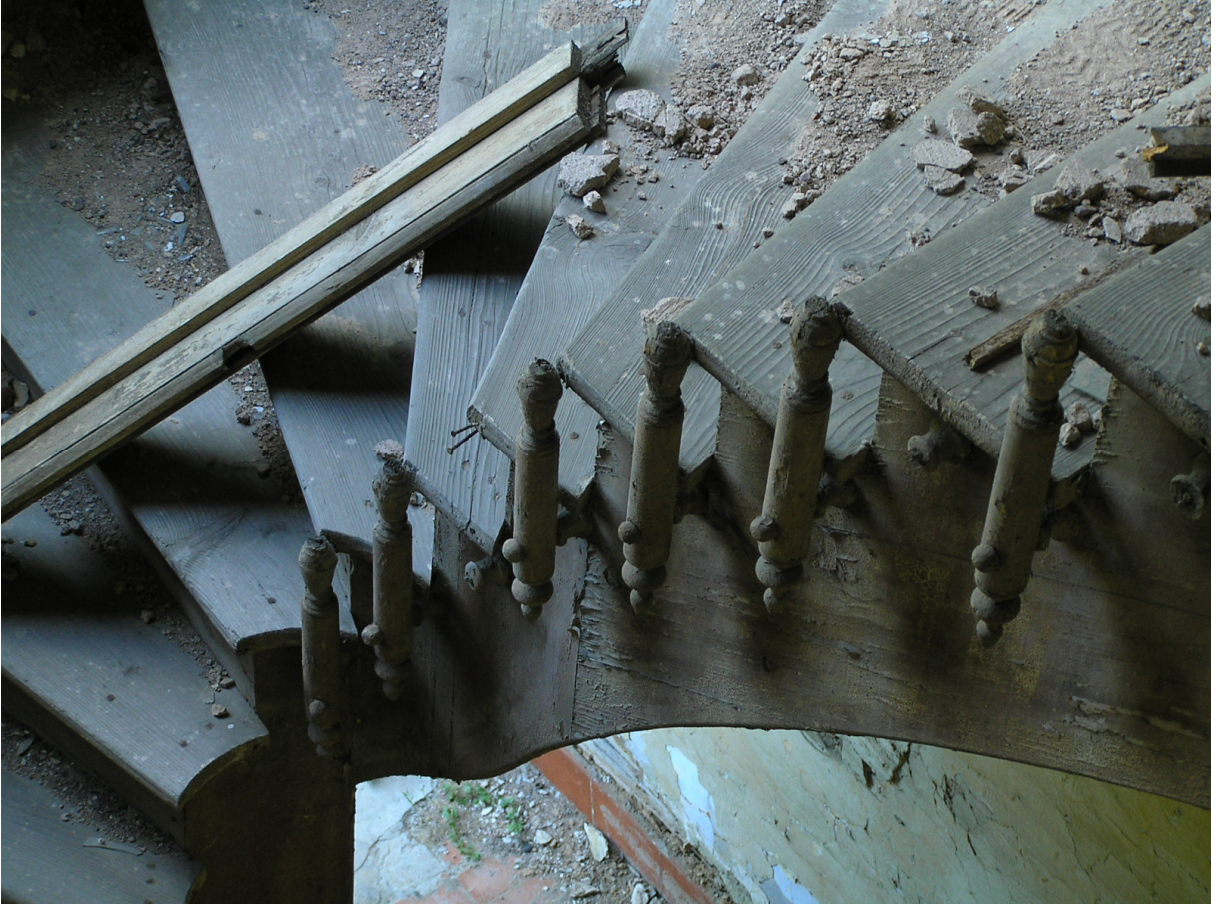
Resim 4.77 Merdiven ahşap korkuluğu
