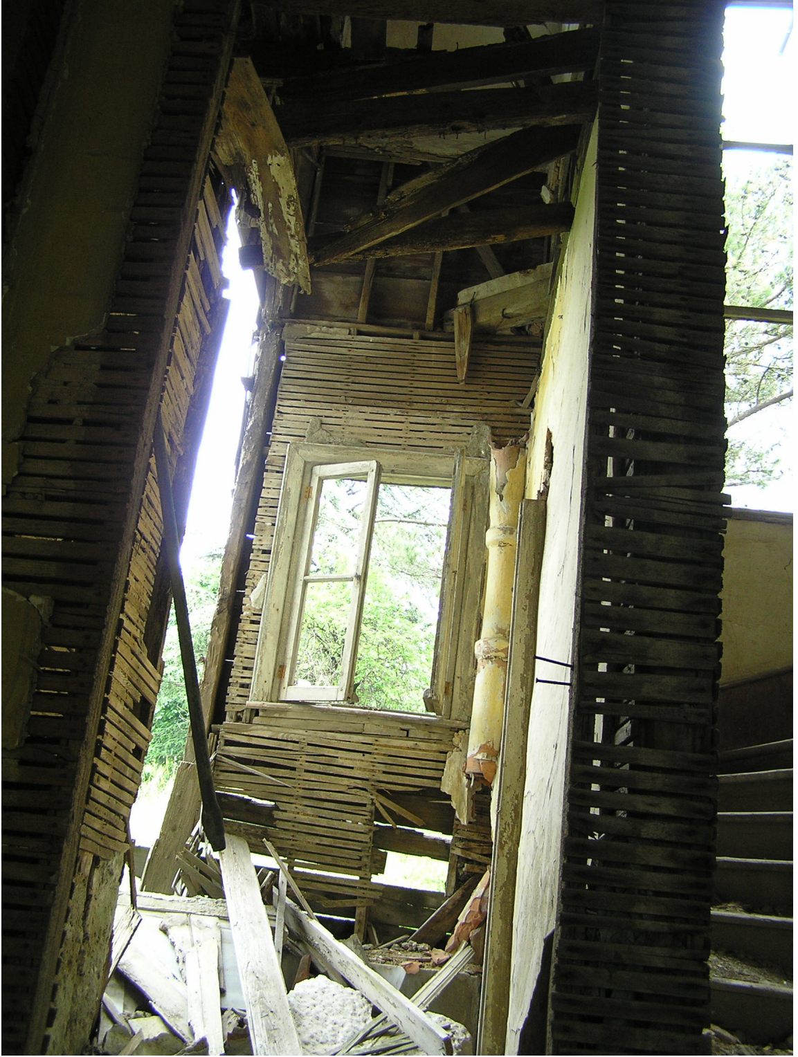
Resim 4.47 ZK05 no'lu wc genel görünüşü
