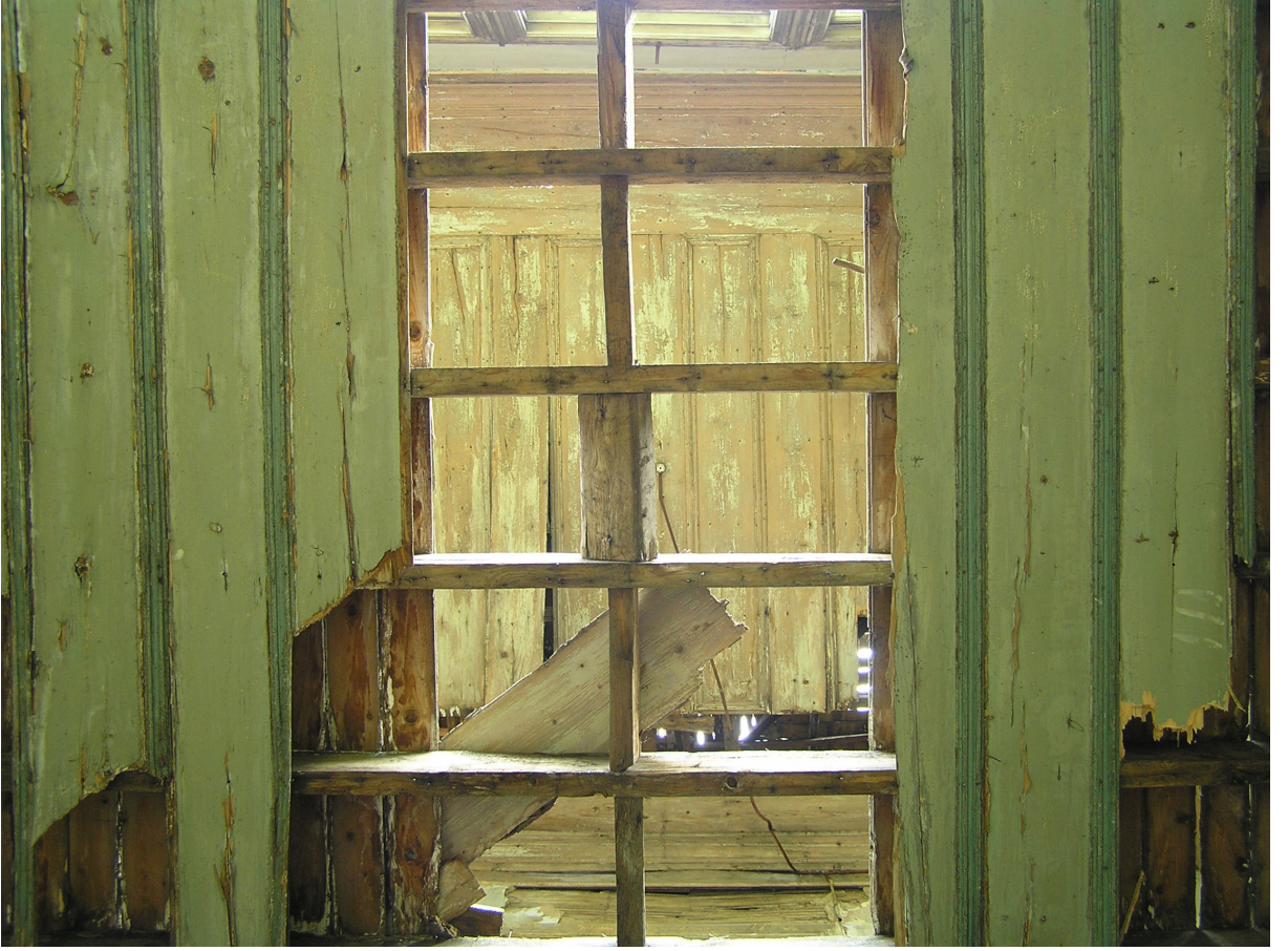
Resim 4.67 Ahşap döşeme kirişleri ve 125*12,5 cm ahşap döşeme kaplamaları
