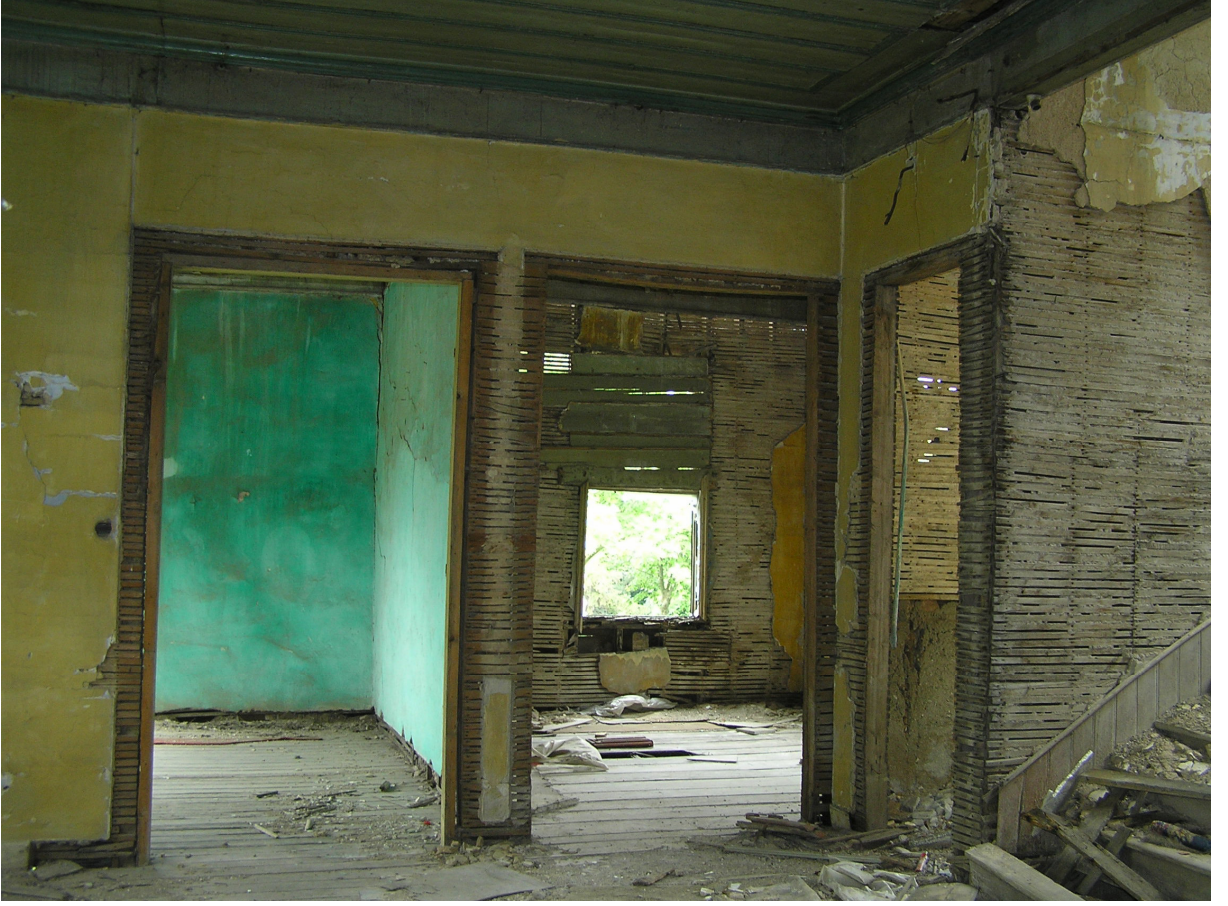
Resim 4.29 ZK03 no'lu odadan diğer odalara giriş kapıları
