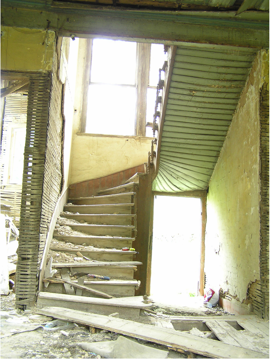
Resim 4.34 Ahşap merdivenin önden görünüşü
