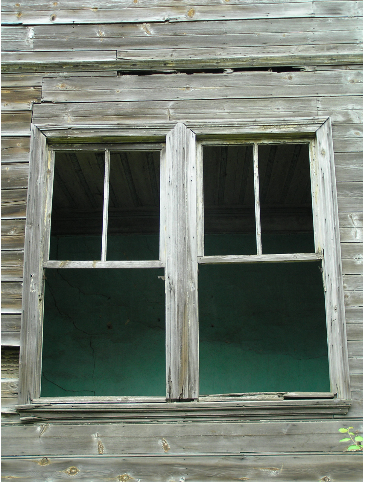
Resim 4.30 Giyotin ahşap pencereler
