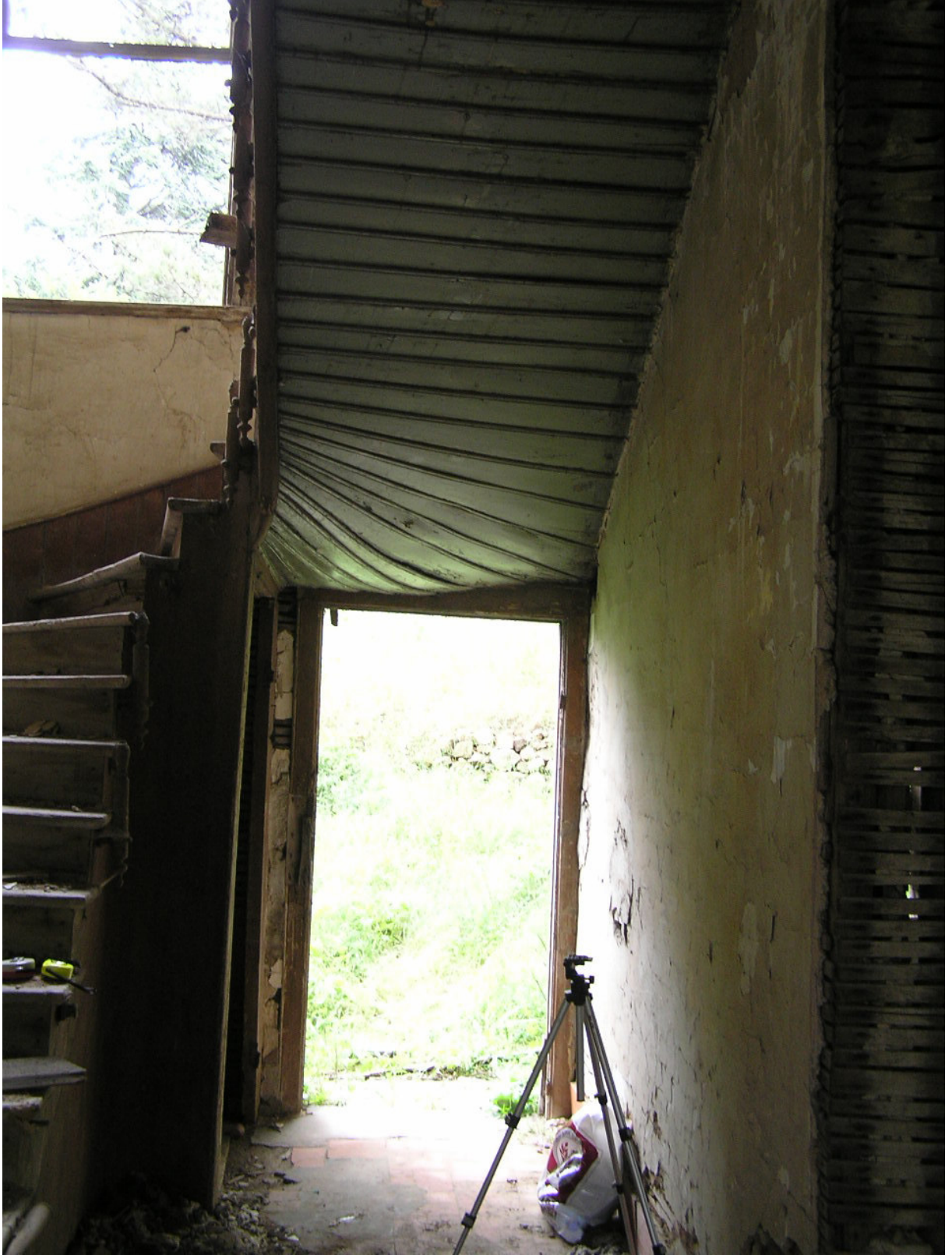
Resim 4.39 ZK04'den bahçeye çıkış kapısı boşluğu görünümü
