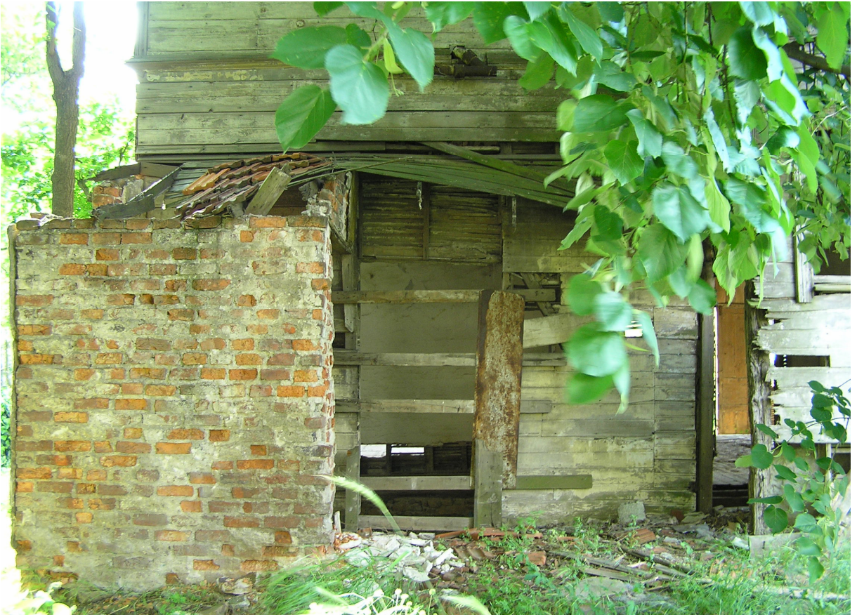
Resim 4.43 ZK09 no'lu mekan (Müştemilat)
