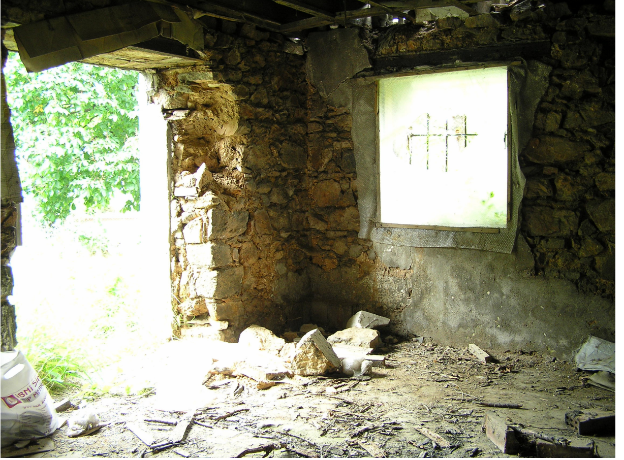
Resim 4.3 Kagir bodrum kat beden duvarları
