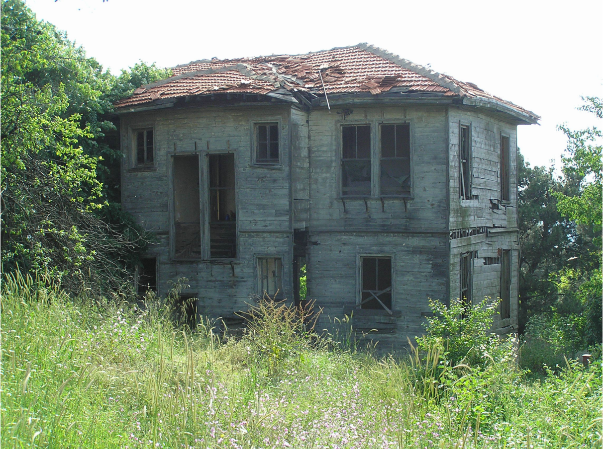
Resim 4.35 Merdiven evi çıkmasının görünüşü
