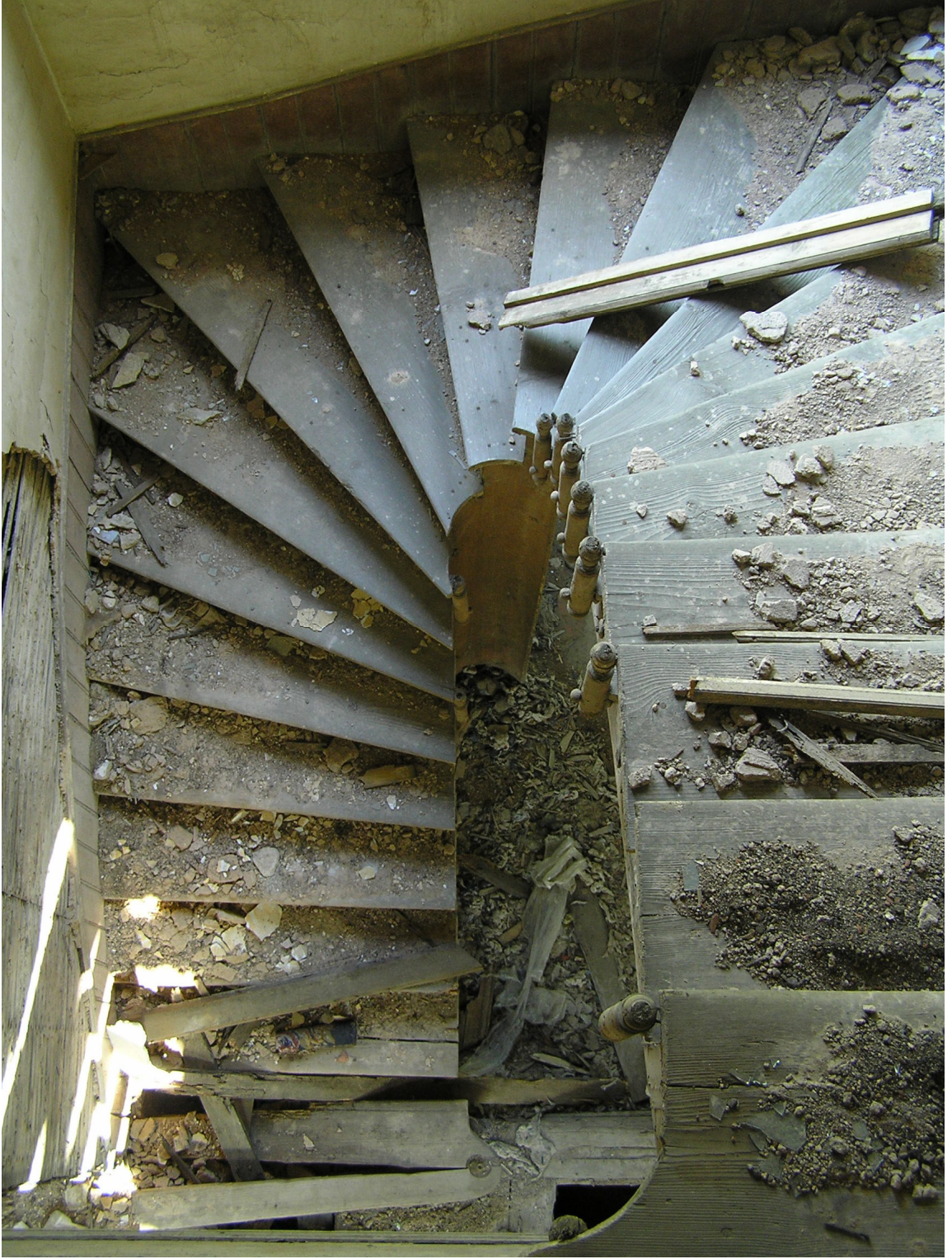
Resim 4.33 Ahşap döner merdivenin üstten görünüşü
