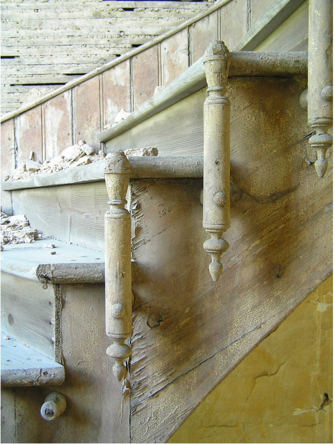
Resim 4.38 Ahşap merdiven korkuluęunun modul detayı
