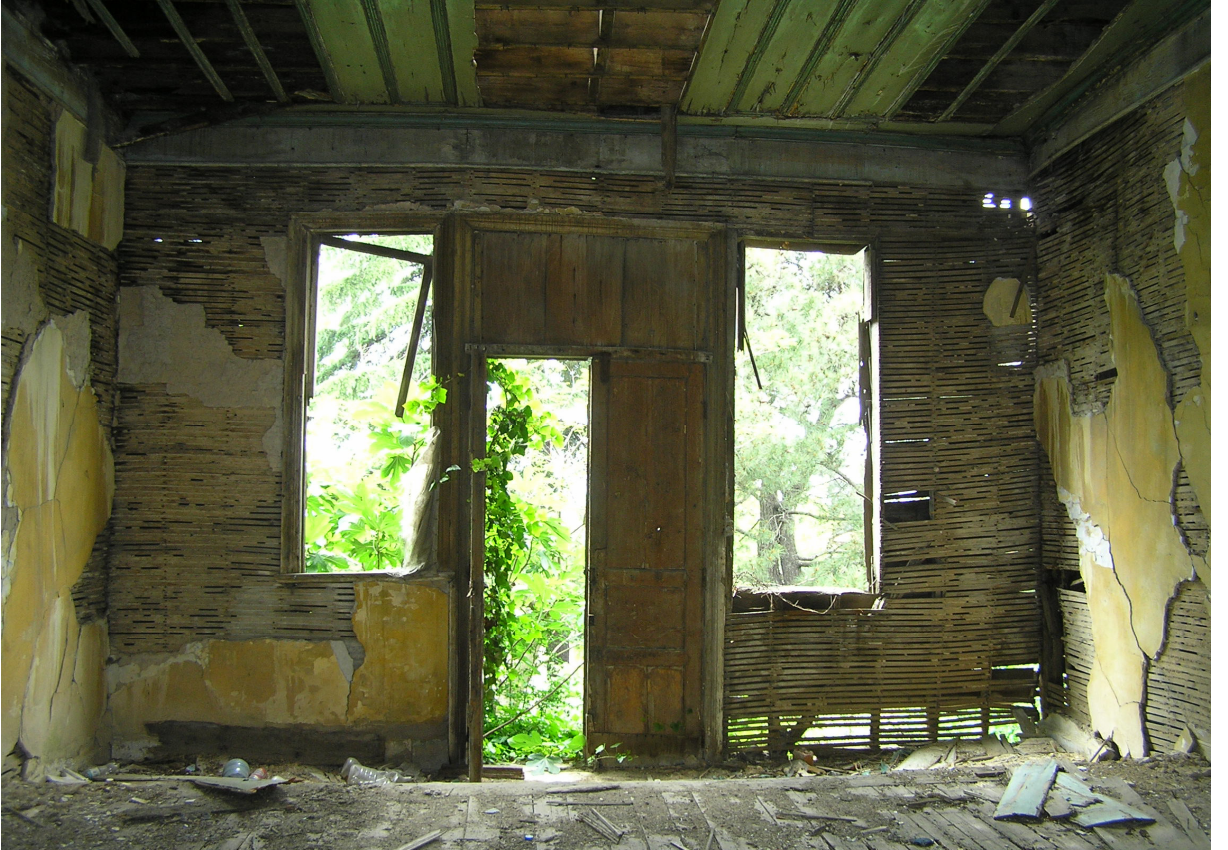
Resim 4.28 ZK03 no'lu odada zemindeki kot farkının görünüşü
