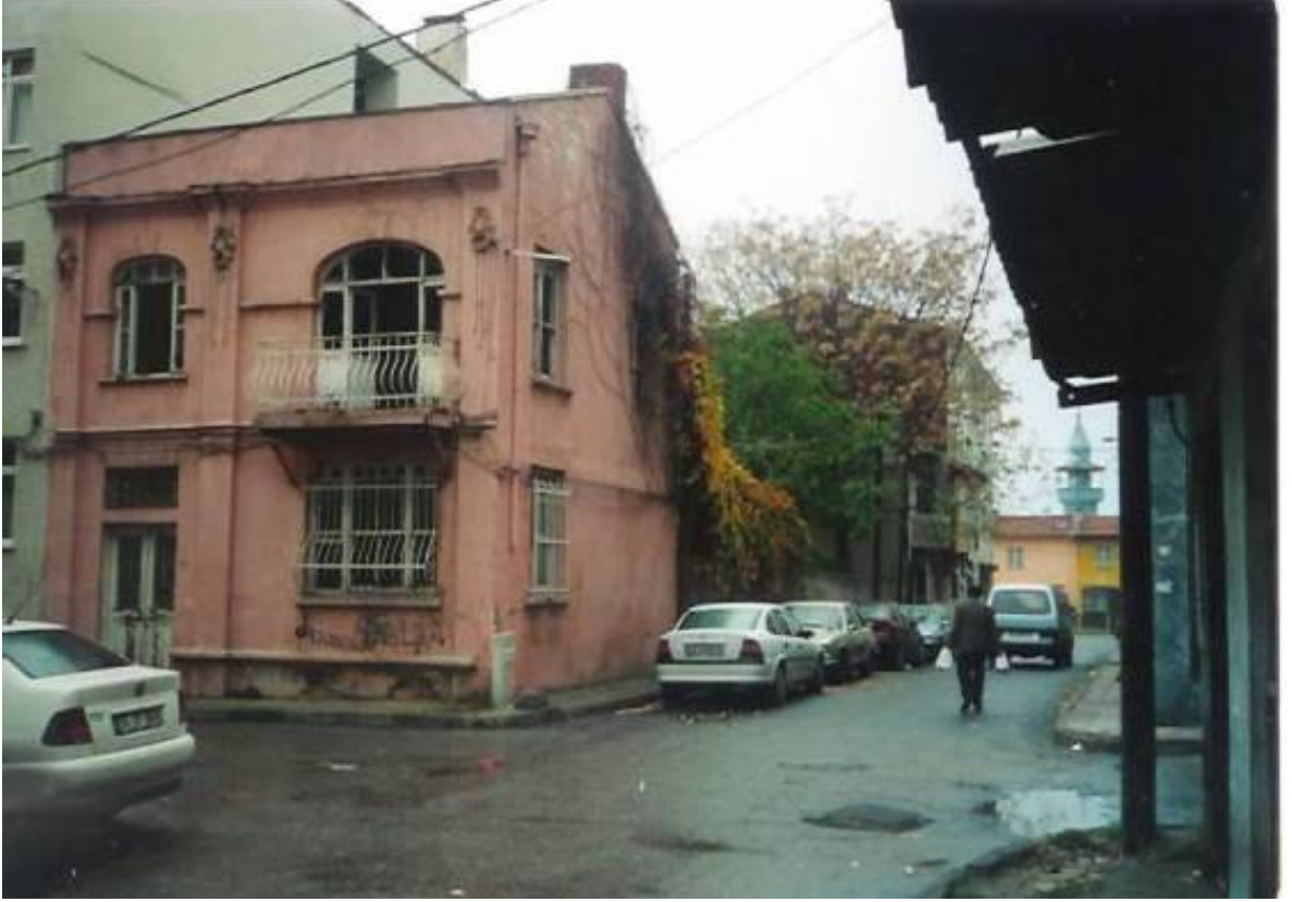
Resim 3.3 Kagir yapım sistemine rnek (Bađlarbařı Setaret Sok. No: 27)
