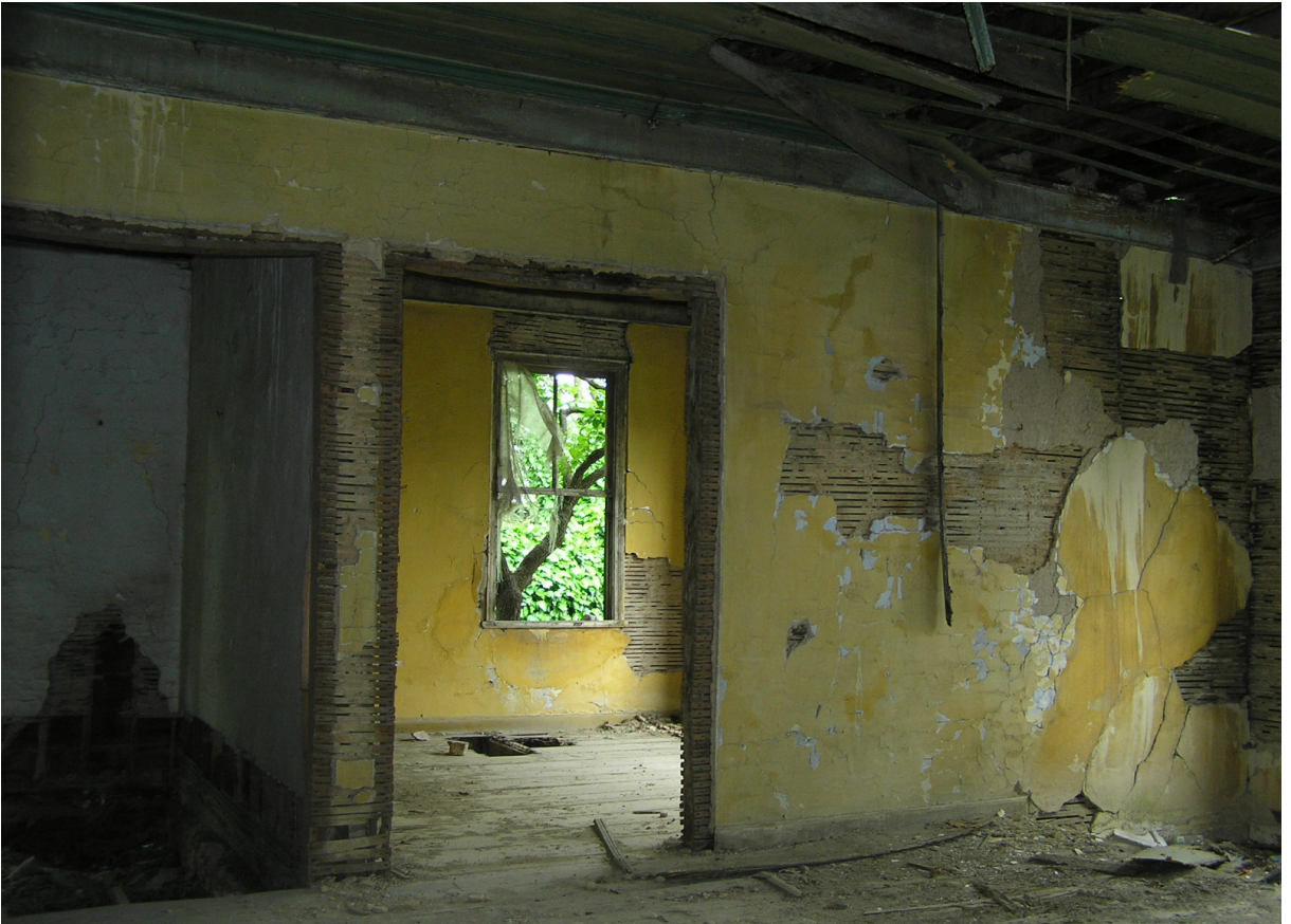
Resim 4.49 ZK08 no'lu oda genel görünüşü
