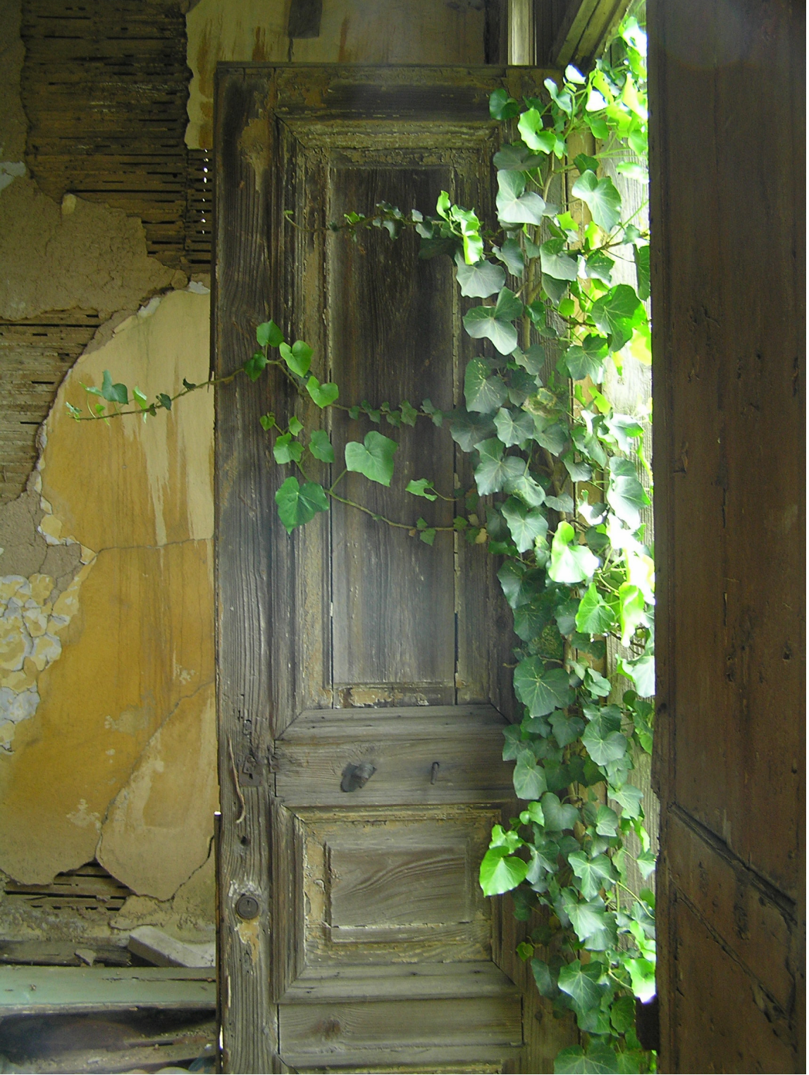
Resim 4.74 Mevcut tablalı kapı görünüşü
