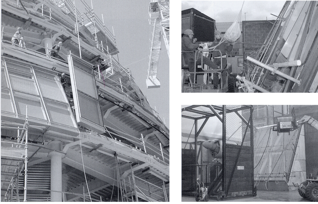
Şekil 5.9 İnşaat alanında giydirme cam panellerin uygulanması. (Kolarevic, 2003)
