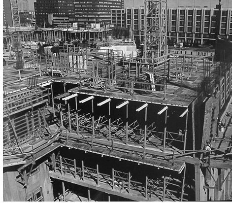
Şekil 5.33 Beton döşemelerin uygulanması. (Joyce, 2004)
