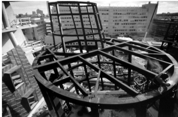
Şekil 5.31 Çelik strüktürün yerine oturtularak kaynaklanması. (Joyce, 2004)
