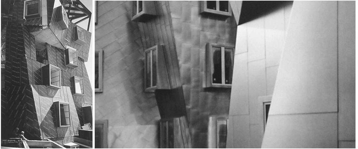
Şekil 5.37 Metal pencere kutuları yerleştirildikten sonra izolasyon kaplama ve kabuğun uygulanmış hali. (Joyce, 2004)
