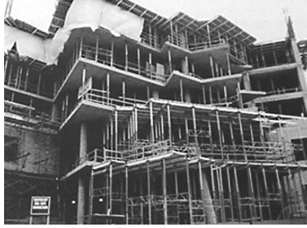
Şekil 5.32 Beton döşemelerin uygulanması. (Matsushima, 2004)
