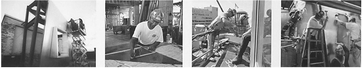
Şekil 5.34 Metal kabuğun ve pencere kutularının yerinde uygulanması. (Joyce, 2004)
