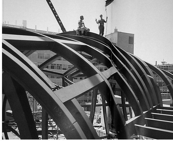
Şekil 5.30 Çelik strüktürün yerleştirilmesi. (Joyce, 2004)
