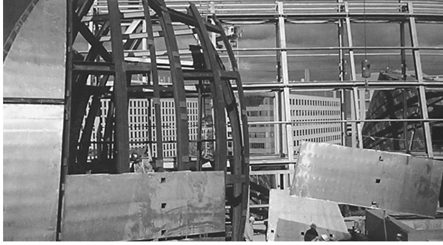
Şekil 5.36 Metal levhaların kaplama strüktür karkasına uygulanması. (Joyce, 2004)
