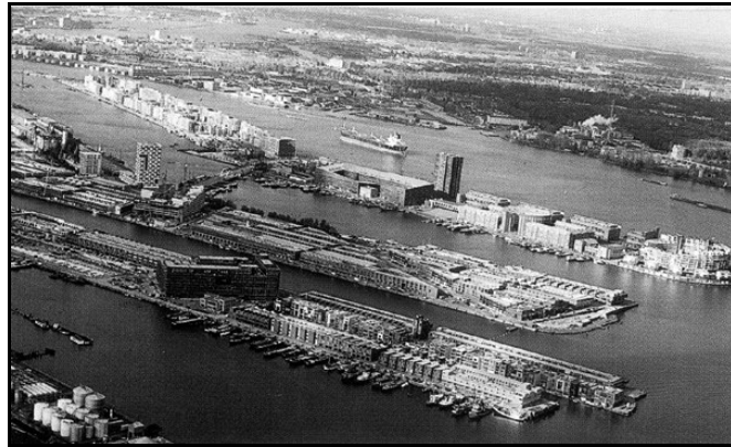
Şekil 4.31 Yapım Aşamasındaki doklar ,(üç büyük apartman bloklarını göstermektedir.) (Borret, 2001)
