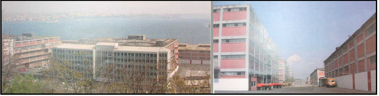
Şekil 5.11 Salıpazarı liman tesisleri içindeki depo ve antrepolar, (Gürsel, 2005)
