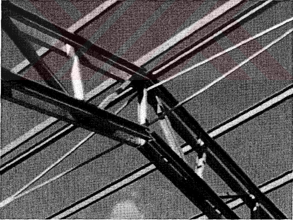
Şekil 5.53 Çatıdaki paralel başlıklı kafes kirişler arası çaprazlama
