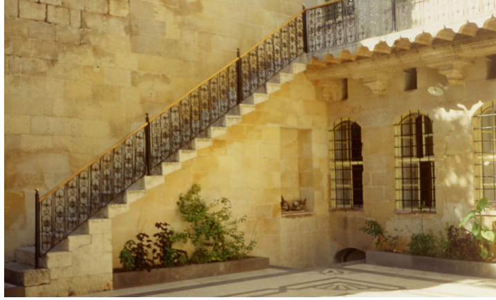
Şekil 3.22 Profilli taşlarla oluşturulan merdiven ve “S” formu korkuluklar.
