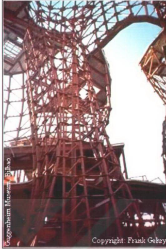
Şekil 3.3.24 Bilbao Guggenheim Müzesi yapım aşaması [50]
