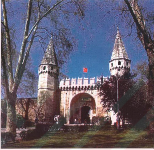
Şekil 3.3.63 Topkapı Sarayı giriş kapısı (Bab-ı Hümayun) [104]
