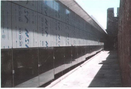
Resim 3.38 Ahır Yapıları arka cephesinde yapılan giydirme cephe, 2005
