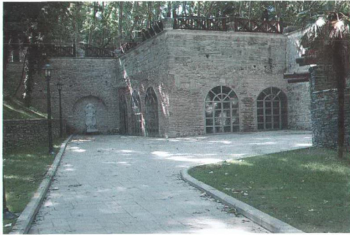
Resim 3.27 Park Sarnıcı (Dış cephe), 2004
