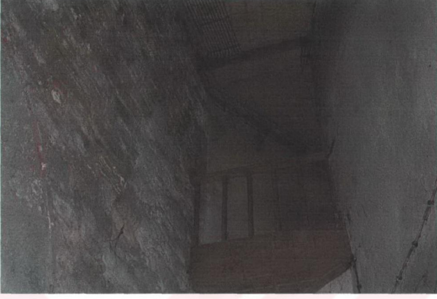
Resim 4.19 Z02 Mekanı'nın Sağ Yan Duvarı Üzerinde Düzenlenen Korkuluk, 2005
