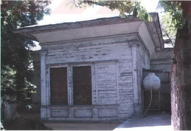
Resim 4.54 N03 Odası'nın Yan Cephesindeki Pencere Görüntüsü Verilmiş Boşluk, 2005
