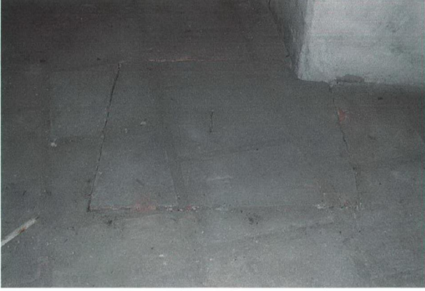
Resim 4.17 Z02 Mekanı'nın Döşemesinde Bulunan Açılır Kapak, 2005
