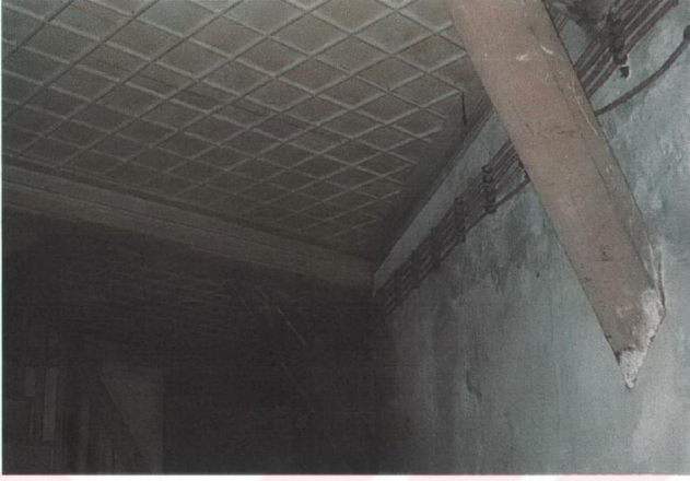
Resim 4.23 Ara Kattaki Ahşap Kirişlerin Altındaki Payandalar, 2005
