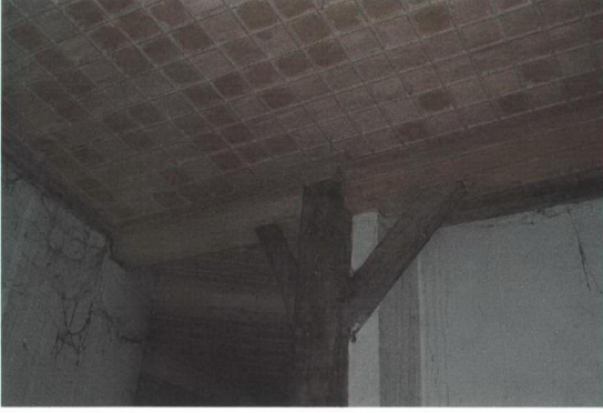
Resim 4.15 Z01 Mekanı'ndaki ahşap dikme ve kiriş, 2005
