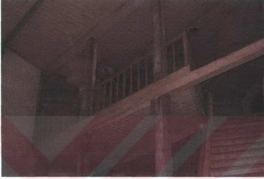
Resim 4.10 Zemin Katta Bulunan Ahşap Dikmeler, 2005
