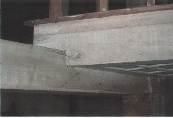
Resim 4.25 Ara Kattaki Ahşap Kirişlerin Altındaki Payandalar, 2005
