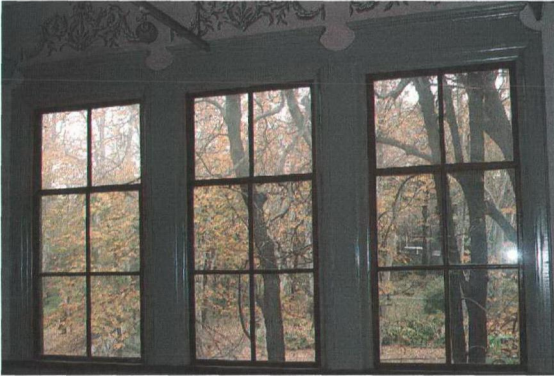
Resim 4.41 N03 Mekanındaki Pencereler, 2005
