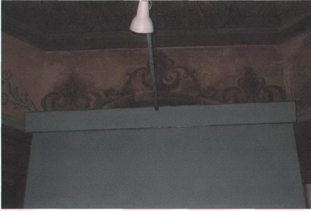
Resim 4.36 N02 Mekanı'nın Park Tarafındaki Sağır Duvarı, 2005
