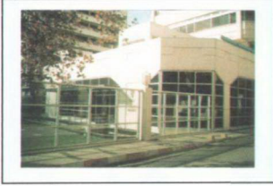
Şekil 4.31 Show TV Binası 2
