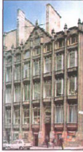
Şekil 2.6 Oriel Chambers Binası [24]
