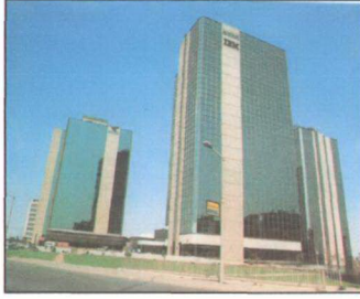
Şekil 4.37 Yapı Kredi Plaza 1
