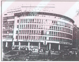
Şekil 3.35 İş Bankası Kadıköy Şubesi
