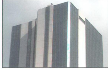
Şekil 4.41 Yapı Kredi Plaza 2
