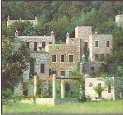
Şekil 2.36 Demir Tatil Sitesi – Turgut Cansever (Mimarlık 311, 2003, s.26)
