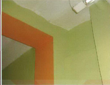
Resim 12 Börekçinin iç mekanında bazı taşıyıcı duvarlar kaldırılıp b.a. kolon ve b.a. kiriş eklenmiş, tavan orijinal volta düşeme
