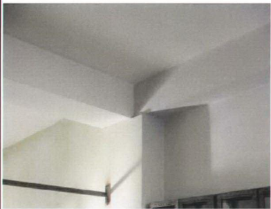
Resim 10 İkinci katın iç görünüşü
