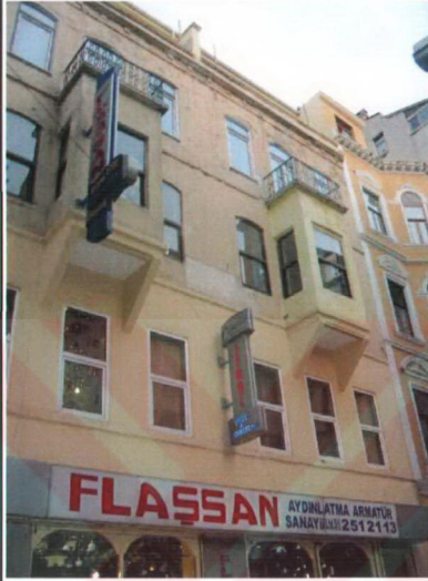
Resim 1 Binanın ön cephesi
