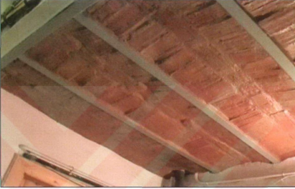
Şekil 3.6 Galata'da bir binanın adi volta döşemesi
