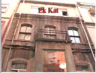
Resim 2 Arka cephede, yoğun kirlenme ve cephede parça kopmaları mevcut
