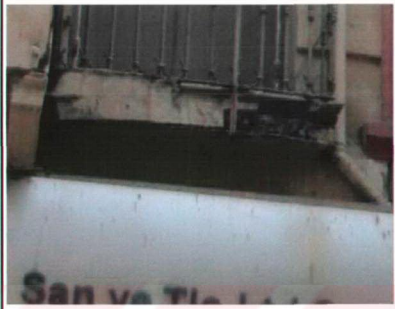
Resim 2 Ön cephede parça kopması
