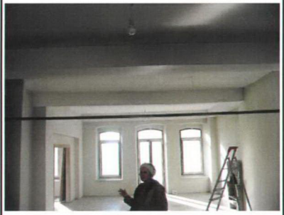
Resim 11 Binanın cephesi korunarak iç taşıyıcı sistemi tamamen değiştirilmiş
