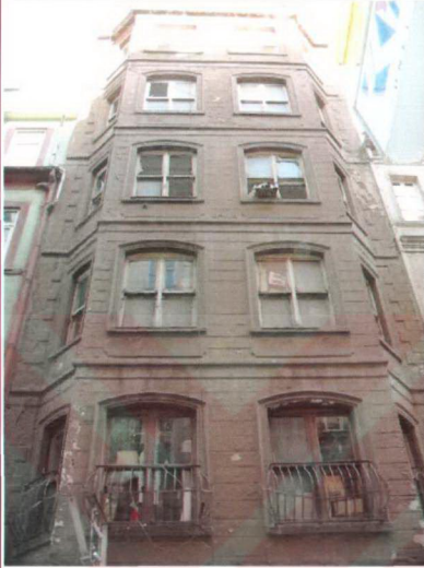
Resim 1 Binanın ön cephesi
