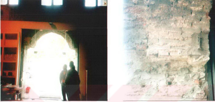
Şekil 4.10 Bilinçsizlikten kaynaklanan hasarlar (kemerin ayakları kesilerek kapı genişletilmiş, kemerin gergi demiri kesilerek giriş yükseltilmiş)
