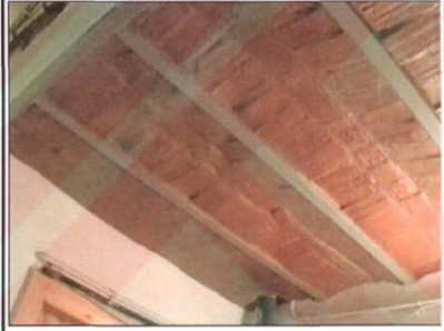
Resim 4 3. Kat döşemesi adi volta döşeme
