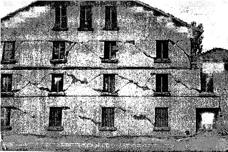
Şekil 4.3 İki yönlü deprem etkisindeki kagir yapı (Keser, 2000)
