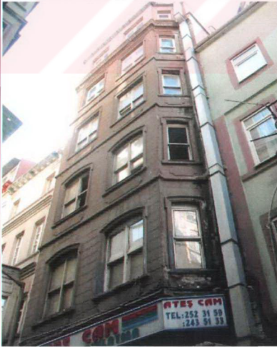
Resim 4 Arka cepheden görünüş
