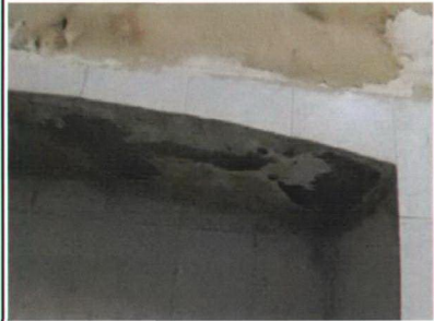
Resim 17 Rutubet ve nemden kaynaklanan bozulmalar
