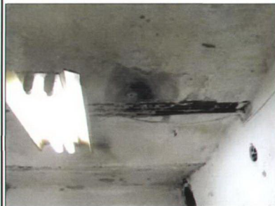
Resim 11 Suyun uzun süre binaya etkimesi sonucu, bodrum ikinci kat volta düşemesinin NPI demirlerinde korozyon
