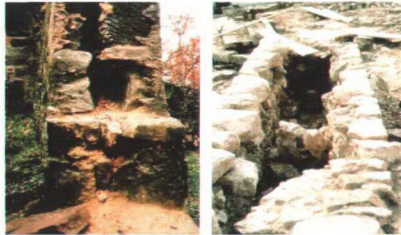
Şekil 4.13 Yanlış taş örgüsünün sonuçları (Nodoushani, 1993)
