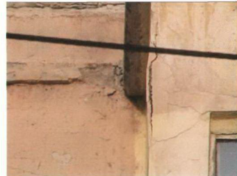
Şekil 4.15 Atmosferik etkilerden kaynaklanan bozulmalar 281/4 ve 5 ada/parsel numaralı bina
