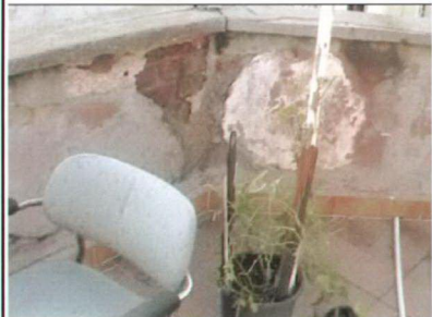
Resim 11 Terastan parapet görüntüsü.
