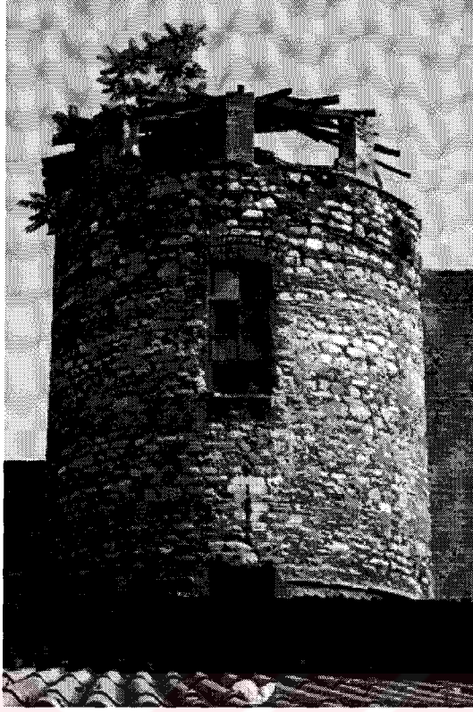
Şekil 5.49 Bölge 2 – Galata Kulesi’ne bağlanan surlar üzerinde bir burç
