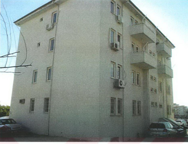
Şekil 4.30 Ahatlı Sağlık Ocağı Binası
