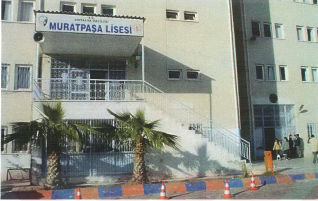
Şekil 4.15 Muratpaşa Lisesi A ve B Blok Girişleri
