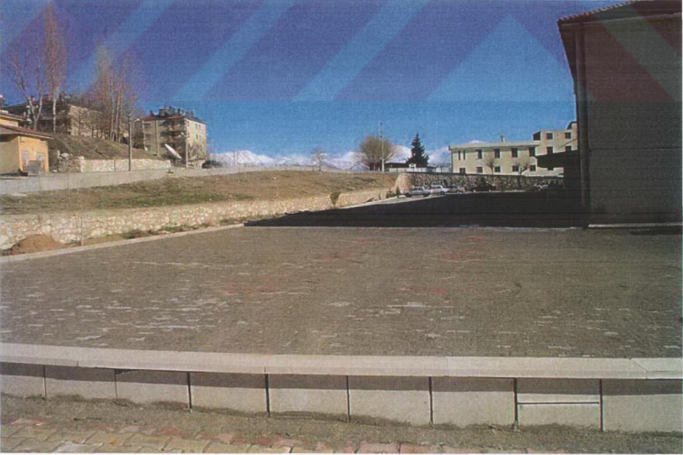
Şekil 4.11 Binanın Arkasındaki İstinat Duvarları
