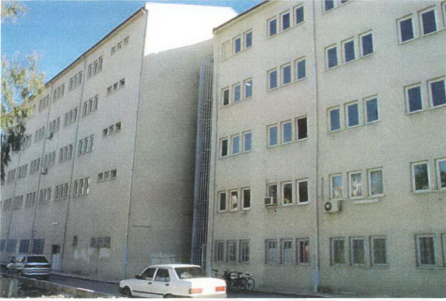
Şekil 4.27 Muratpaşa Lisesi Arka Cehesi, Çelik Konstrüksiyon Yangın Merdiveni
