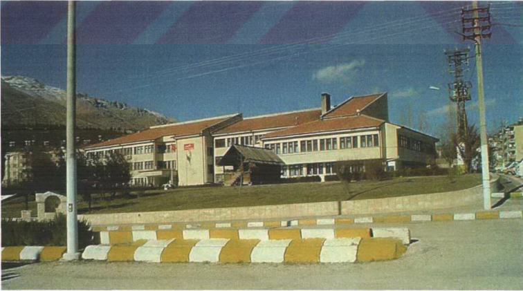
Şekil 4.13 Binanın Ana Yoldan Görünüşü
