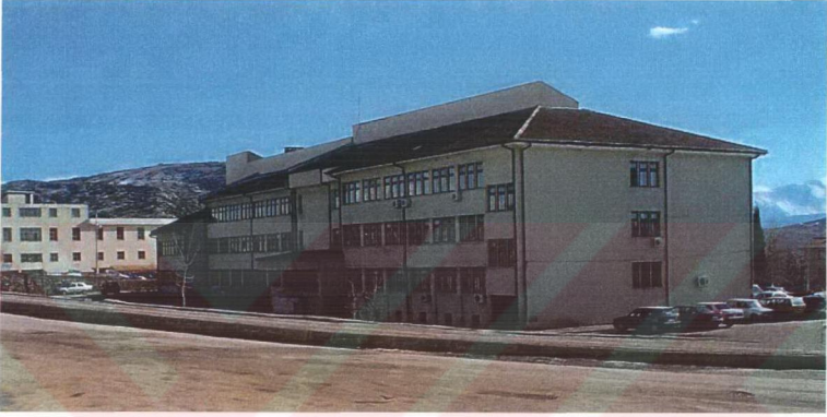
Şekil 4.10 Arka Cephe ve Arazinin Arkasındaki Yol Arasındaki Kot Farkı
