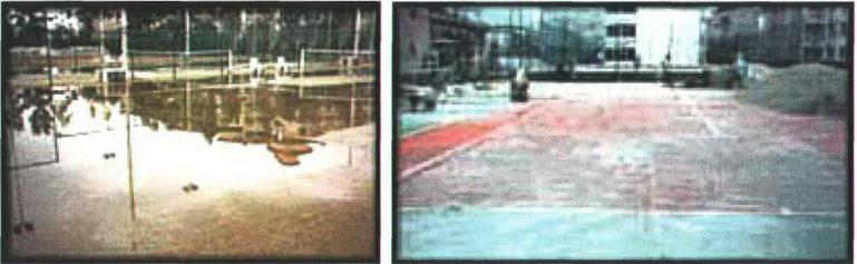
Şekil 3.8 Sentetik sahalarda zeminin suyu geçirmemesi [6]
