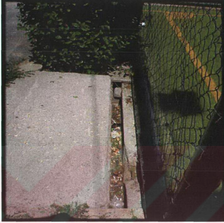
Şekil 3.11 Spor alanlarında çevresel drenaj sorunu
