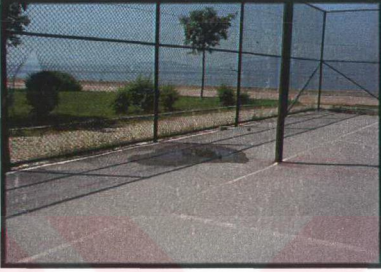
Şekil 3.2 Spor alanlarında su birikmesi
