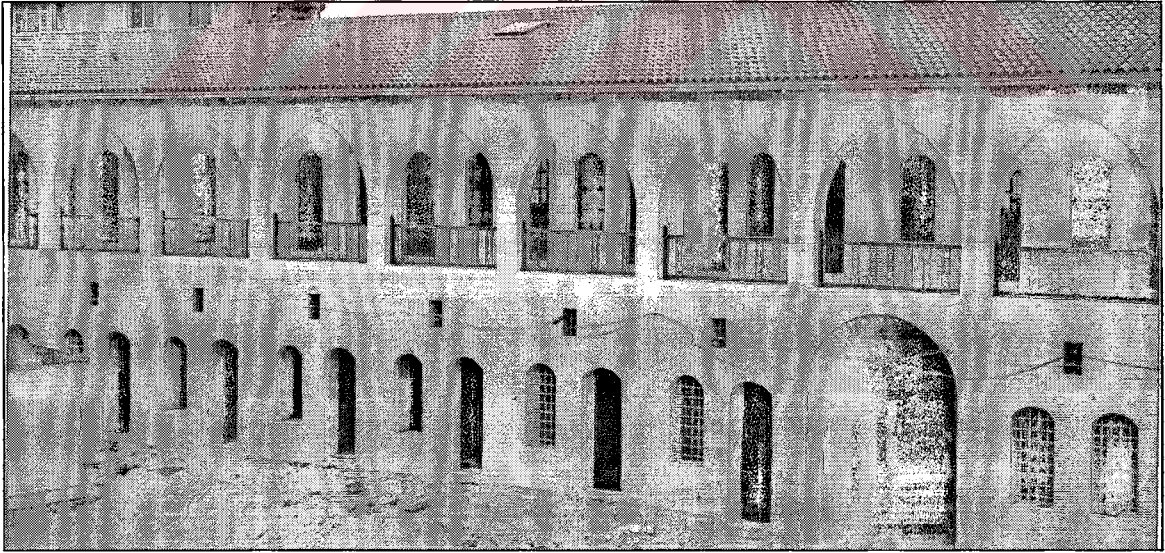
Şekil 5.68 Belediye Hanı- Restorasyon aşaması- avludan bakış(2004)
