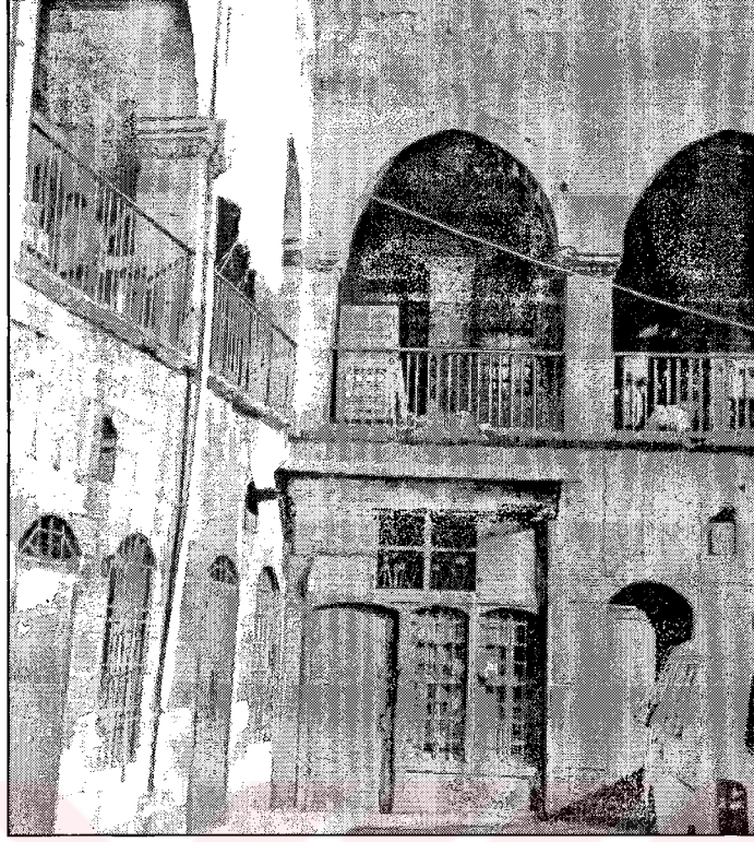
Şekil 6. 17 Şeker Hanı-kapatılan eyvan bölümü(2003)
