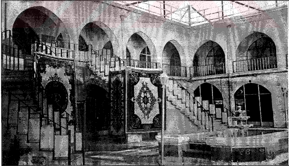
Şekil 5.35 Yeni Han 1. kata çıkan yenilenmiş merdivenler(2004)
