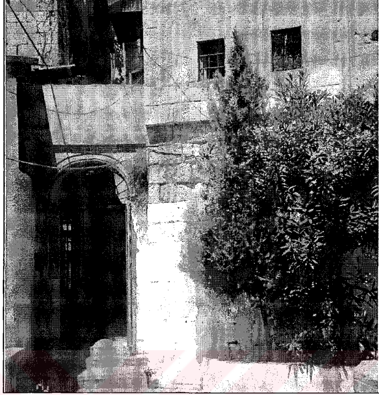
Şekil 6.28 Güleç evi-cami avlusuna sokaktan giriş (2004)
