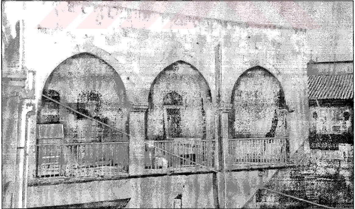
Şekil 6.10 Şeker Hanı-1. katta revaklı doğu bölüm(2003)
