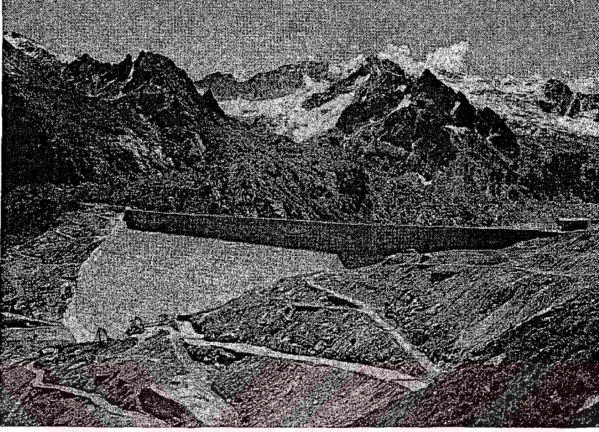
řekil 3.2 Dađda bir baraj yapısı: Albigna Power Station-Lbbia, 1959 (Werk,Bauen und Wohnen, 1993)
