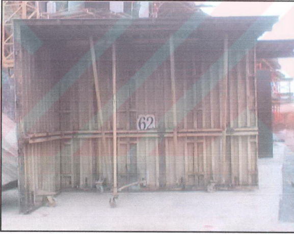
Şekil 3.6 Yarım tünel kalıp
