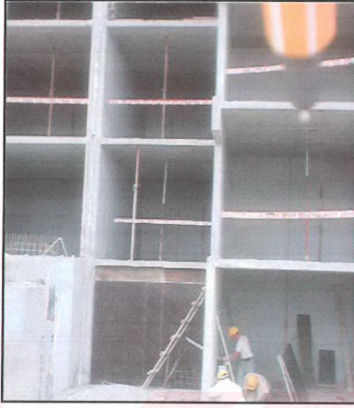
Şekil 3.17 Hacimlerin teleskobik dikmelerle desteklenmesi
