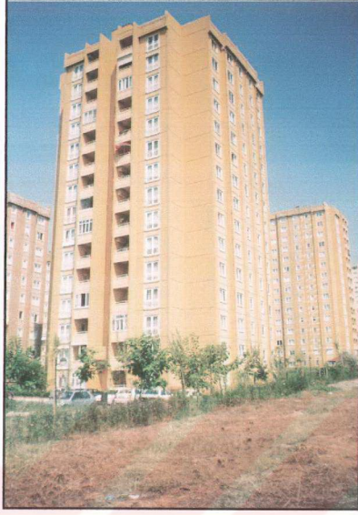
Halkalı III. Etap Toplu Konutları / B Blok
