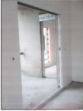
Şekil 3.2 Tünel kalıp sistemiyle üretilen Mesa Yamaçevler' de iç duvarlarda alçı panel uygulaması
