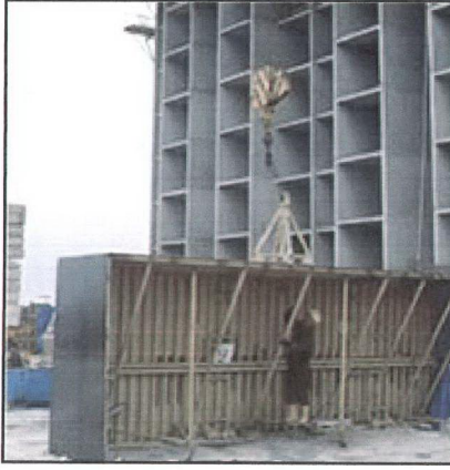
Şekil 3.8 Tünel kalıpların kreynlere tutunmaları için gerekli üçgen askılar
