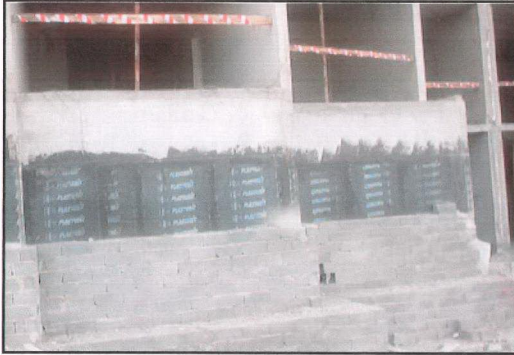
Şekil 3.13 Bodrum kat yapımı
