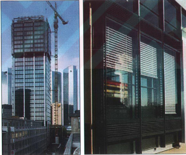
Ek 2.18 Eurotheum Yapısı ve tek üniteli cephe sisteminin görünümü
