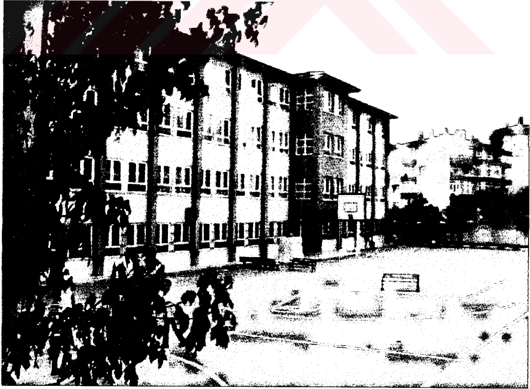
Şekil 6.1 İhsan Zakirođlu dersliđi kamu ilköđretim okulu genel görünüşü
