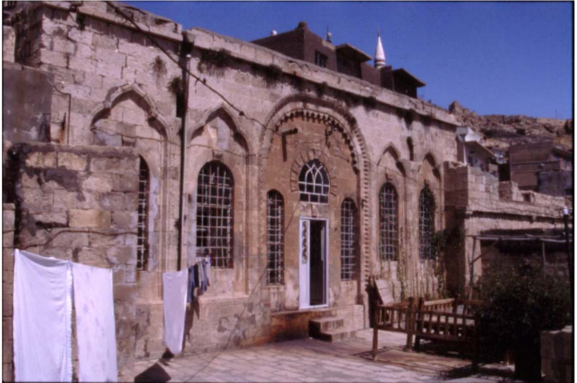
Fotoğraf 3.20 Ağıza taş örülerek inşa edilen eyvan (Özbek, 2003)
