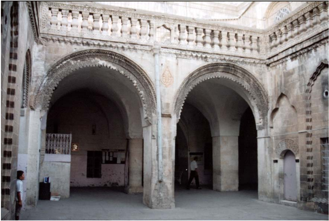
Fotoğraf 3.22 İlkokula dönüştürülen Gazipaşa İlkokulu'nun giriş katındaki revak (Özbek, 2003)
