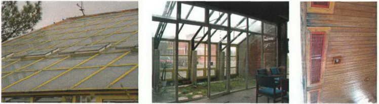
Şekil 4.11 Tromb çatı, seranın içten görünümü ve tavadaki menfez kapakları.
