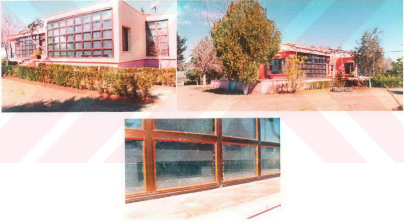
Şekil 4.8 Yapının güney cephesi ve Trombe duvarından detay, Adana Güneş Evi
