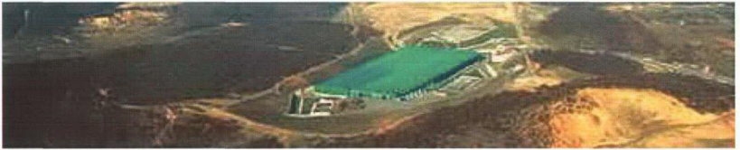
Şekil 3.65 İstanbul Büyükşehir Belediyesi Kemberburgaz 'Çöp Gazından Elektrik Enerjisi Üretim Tesisi' ([19])
