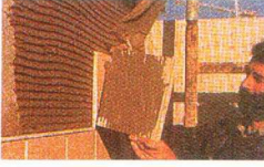
Şekil 3.1 Yapıştırıcı ile uygulama yöntemi (Weber, 2001)
