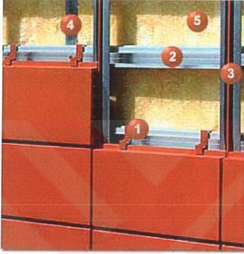
Şekil 3.43 Klinker plakların profilli-gizli yöntem ile uygulanması [9]
