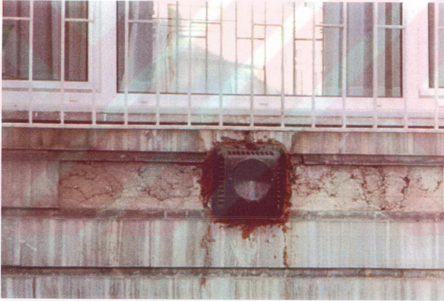
Şekil 4.4 Plak üzerine sonradan ilave edilen metal bir parça nedeniyle düşen mermer plak
