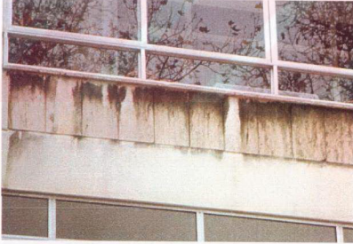
Şekil 4.23 Hatalı tasarımdan dolayı denizlik altındaki traverten kaplamada oluşan kirlilikler
