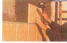
Şekil 3.1 Yapıştırıcı ile uygulama yöntemi (Weber, 2001)
