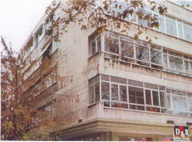
Şekil 4.3 Traverten kaplamada görülen cephe kirlenmesi
