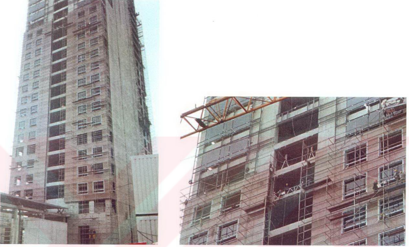
Şekil 3.3 Ankrajlı yöntemlerle uygulanan granit cephe kaplaması
