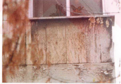
Şekil 4.23 Hatalı tasarımdan dolayı denizlik altındaki traverten kaplamada oluşan kirlilikler
