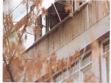
Şekil 4.3 Traverten kaplamada görülen cephe kirlenmesi
