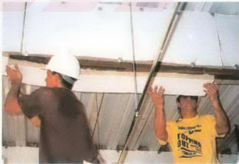
Şekil 5.15 Kirişte mineral lif levhaların klipslerle sabitlenerek korunum sağlanması (Cafco Ltd.Şti) [8].
