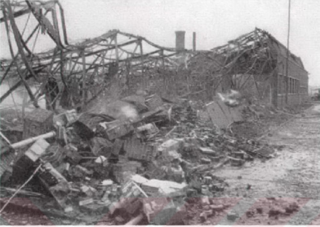
Şekil 4.5 Korunmasız çelik kafes kirişlerin çökmesiyle taşıyıcı yığma duvarların birlikte göçmesi (Thomas, 1972).
