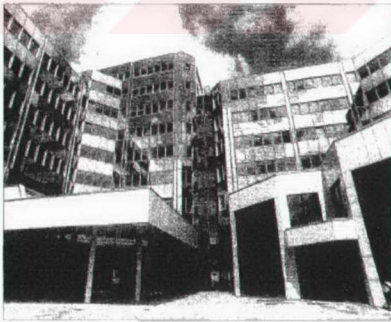
Şekil 5.4 Avrupa Parlamentosu yönetim binası, F 90 yangın direnimi sağlamak amacıyla kolonlar ve döşemeler betonla korumaya alınmıştır, Kirchberg (Eurofer, 1990) [5].
