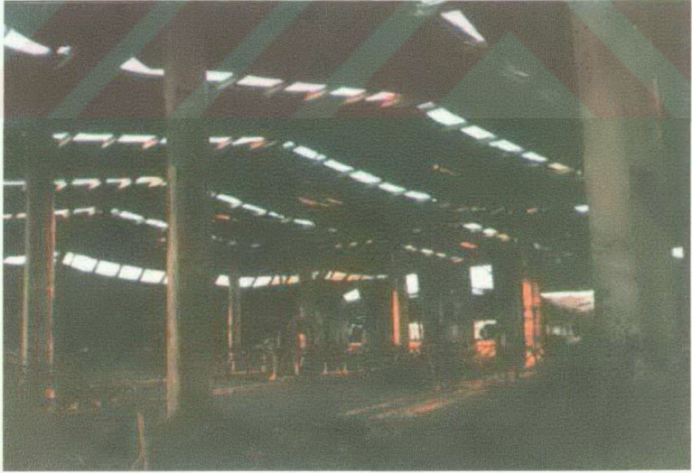
Şekil 4.13 Montel fabrikasının yangından sonra ayakta kalan kolonlarından bazıları.
