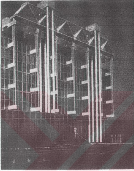
Şekil 5.24 Doğal su dolanımı ile korunan Hannover' deki ofis binası (Norconhaus) (Eurofer, 1990) [5].
