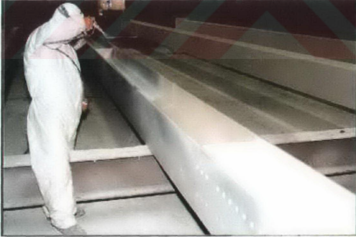
Şekil 5.21 Çelik yapı elemanı üzerine püskürterek koruyucu boya katmanı oluşturulması (Smith, 2000) [7].
