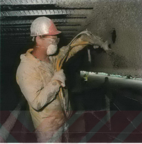
Şekil 5.18 Çelik taşıyıcı kirişe koruma katmanının (vermikülit ve çimento karışımı) püskürtülerek uygulanması (Smith, 2000) [7].
