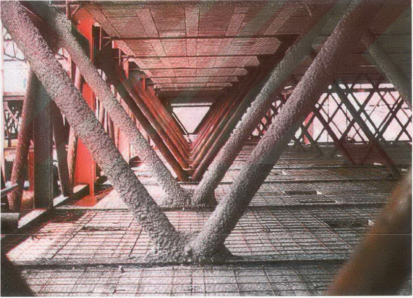
Şekil 5.17 Püskürtme sıvalarıyla korunmuş olan çelik kafes kirişleri görülüyor (Smith, 2000) [7].
