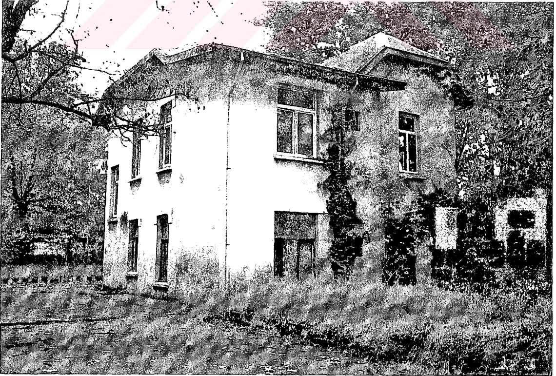
Resim 5.36 9 nolu ofis binası.
