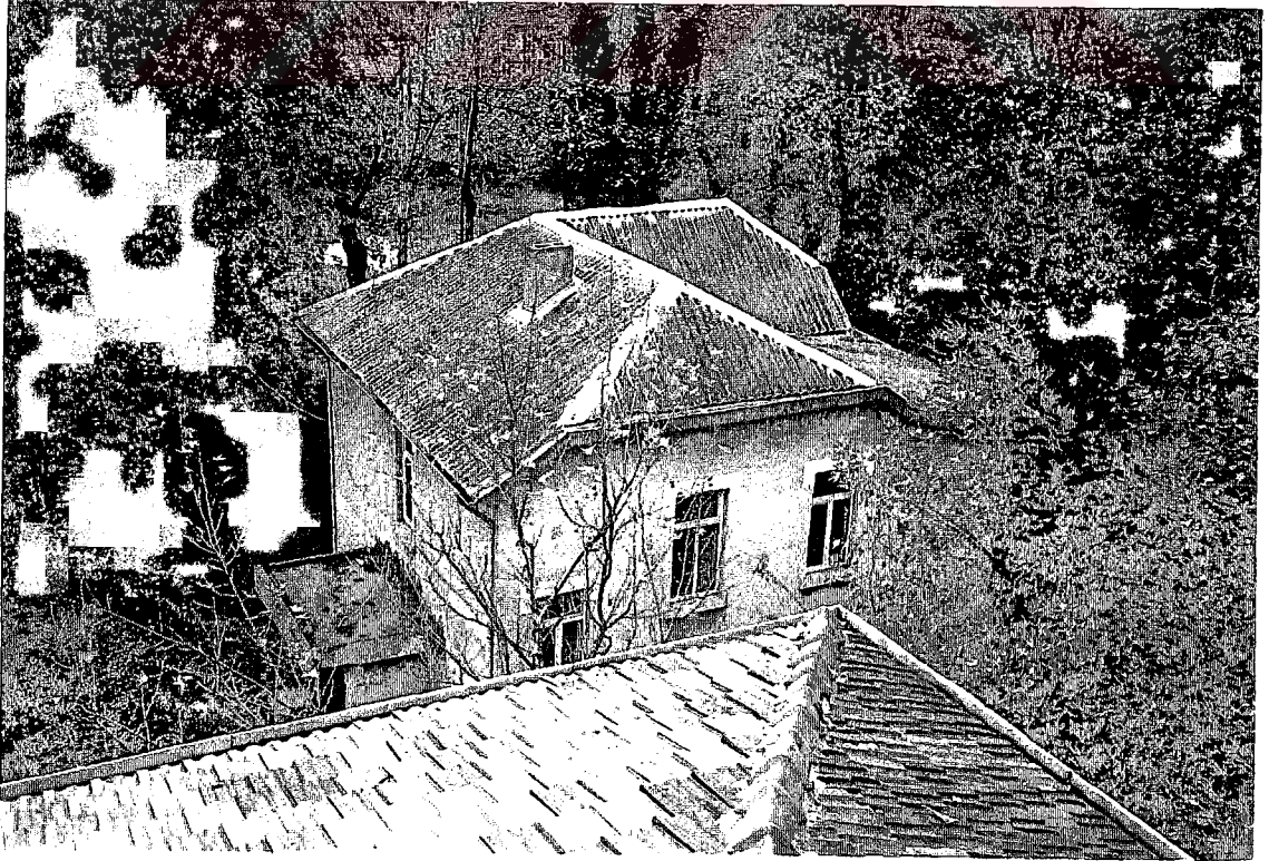
Resim 5.38 9 nolu ofis binası çatısı.
