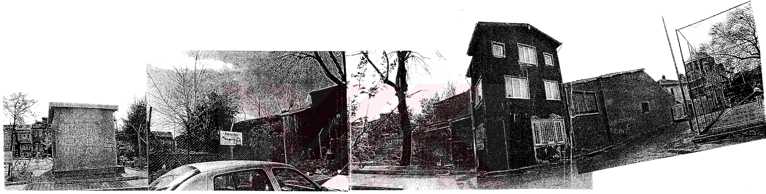
MEHMET PAŞA DEĞİRMENİ SOKAK GÜNEYBATI YÖNÜ
