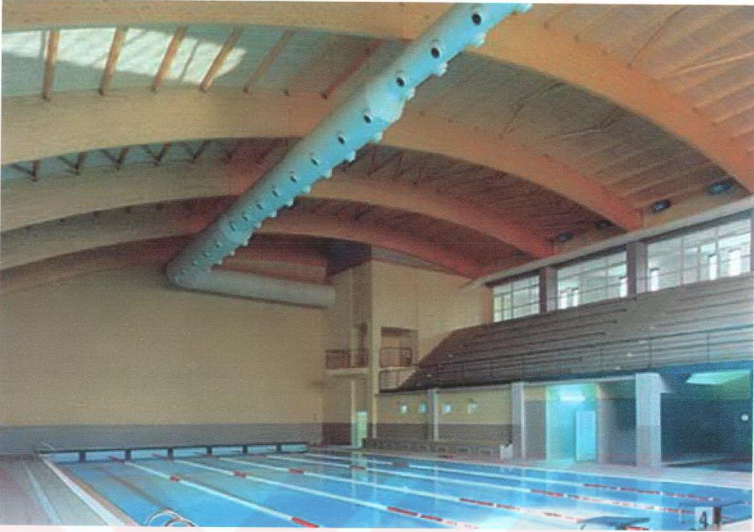
Piscine buriassat-Valencia, kapalı yüzme havuzu yapısının örtüsünde kullanımı, [10]
