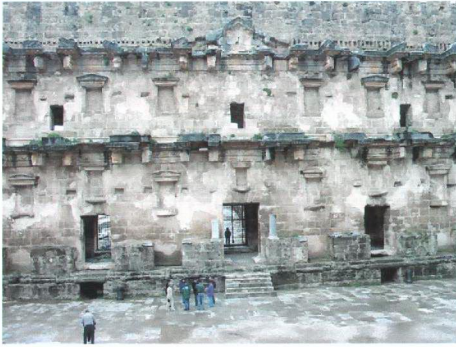
Şekil 4.15 Sahne önü cephesi
