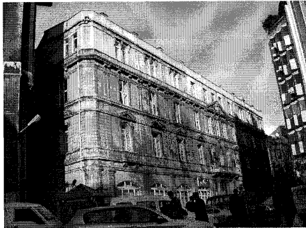
Şekil 4.61 Sanasaryan Han Mimar Kemallettin sokağı giriş cephesi
