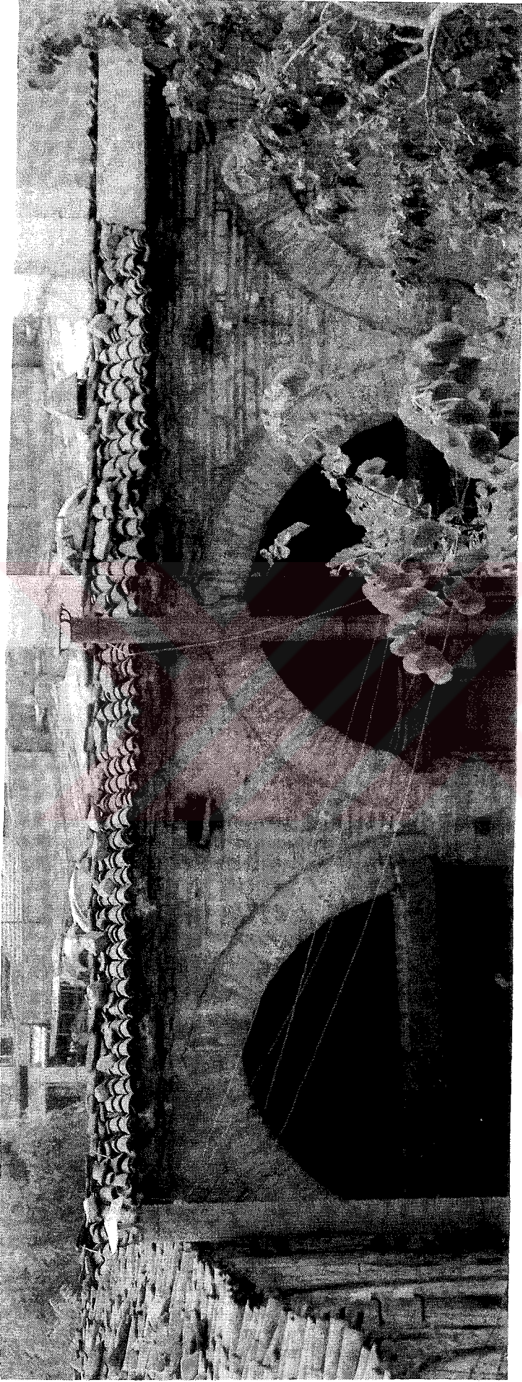
Resim 2.43 Tuz Han'ın batı kolunun revak kemerleri, saçağı, taş örgüsü.
