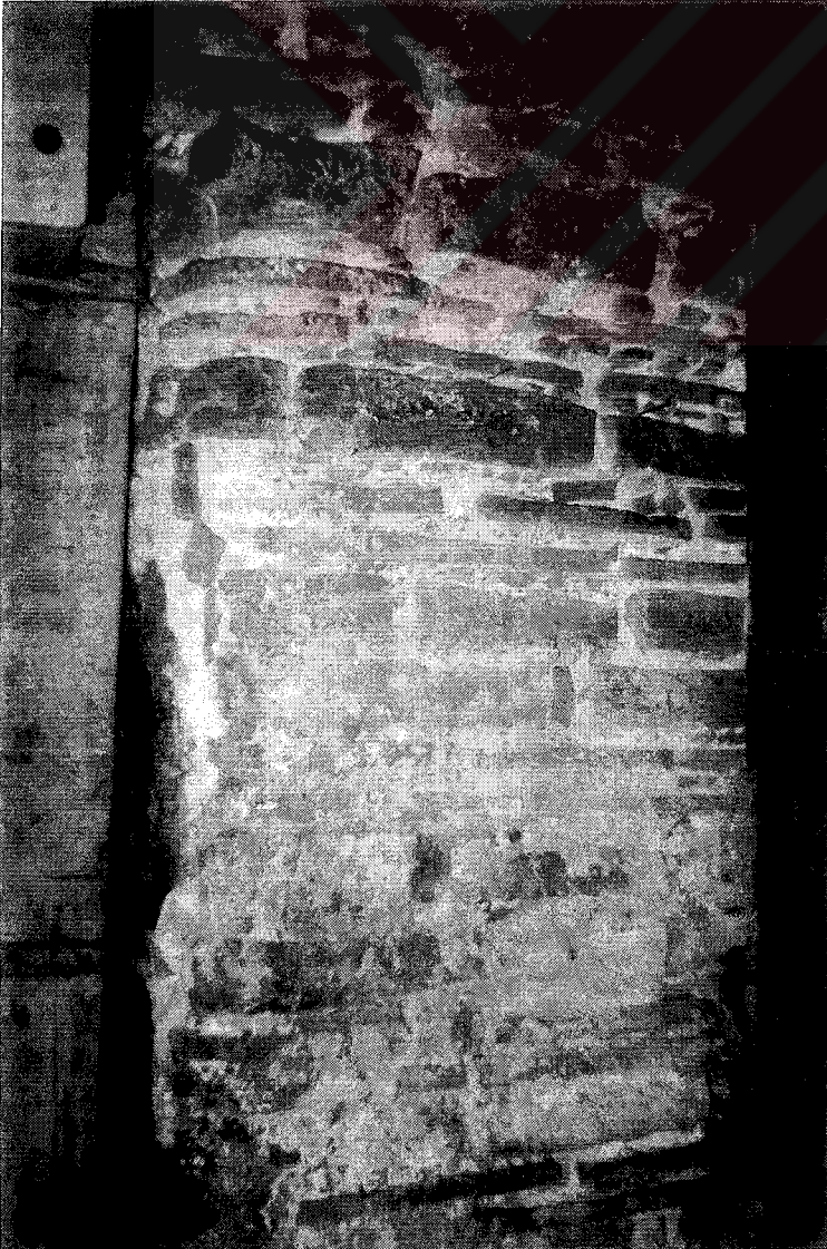
Resim 2.114, Üst kat revakında tonoz tavana ait taş örgüsü.
