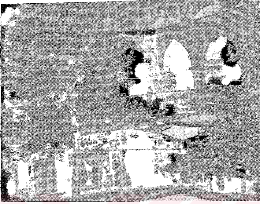
Resim 2.7 İpek Han' ın revağından, taşıyıcı tuğla ayaklarına ve kemerlerine bakış.
