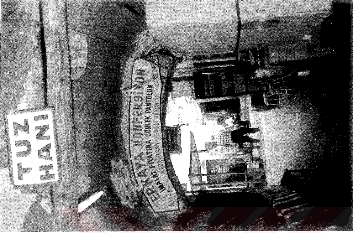
Resim 2.121 Tuz Hanı'nın giriş kapısı üstündeki basık kemer.
