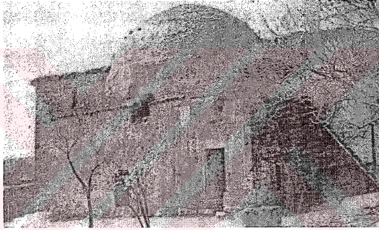
Resim 2.4 Konya, Meram Darülfazlî doğu cephesi (Diez, 1950: 144)
