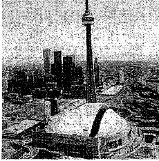
Şekil 4.23 Çatı kapalıyken bir görünüş [Allen, 1992]
