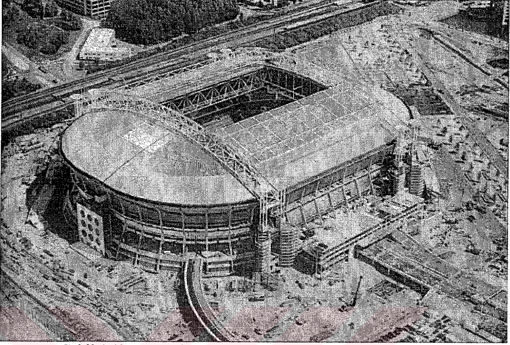
Şekil 4.48 Amsterdam Arena çatısının açık hali [Ishii, 2000]
