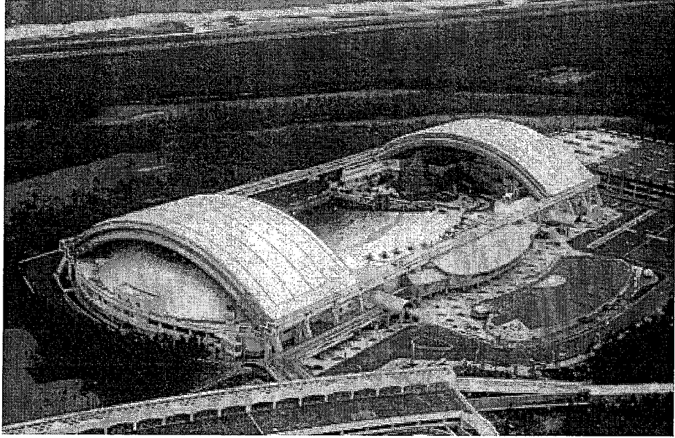
Şekil 4.41 Ocean Dome çatı açırken genel görünüş [Ishii, 2000]
